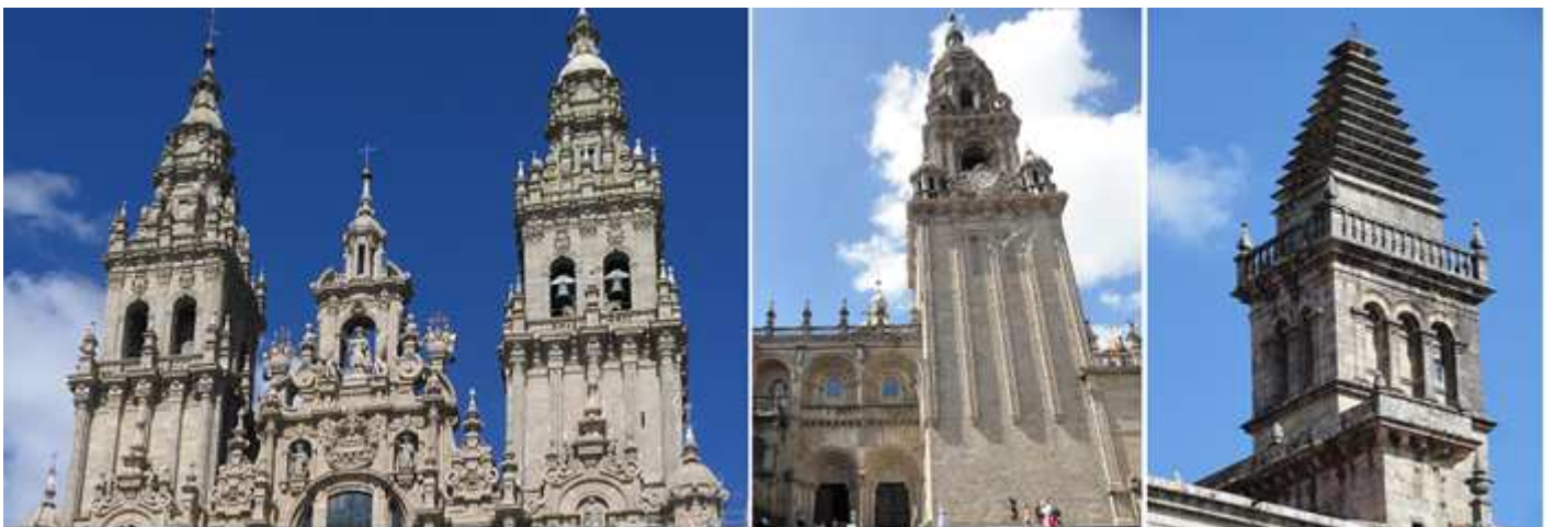
❶ Las dos torres de la fachada principal., a la izquierda la torre de la Carracla y a la derecha la de las campanas. ❷ Torre del Relo o de Berenguela, 72m. S. XVII. se añadió bajo el obispado de Berenguer de Landora S. XVI. Solo dispone de una aguja para las horas, los cuartos son marcados por campanas. ❸ Torre del Tesoro.
