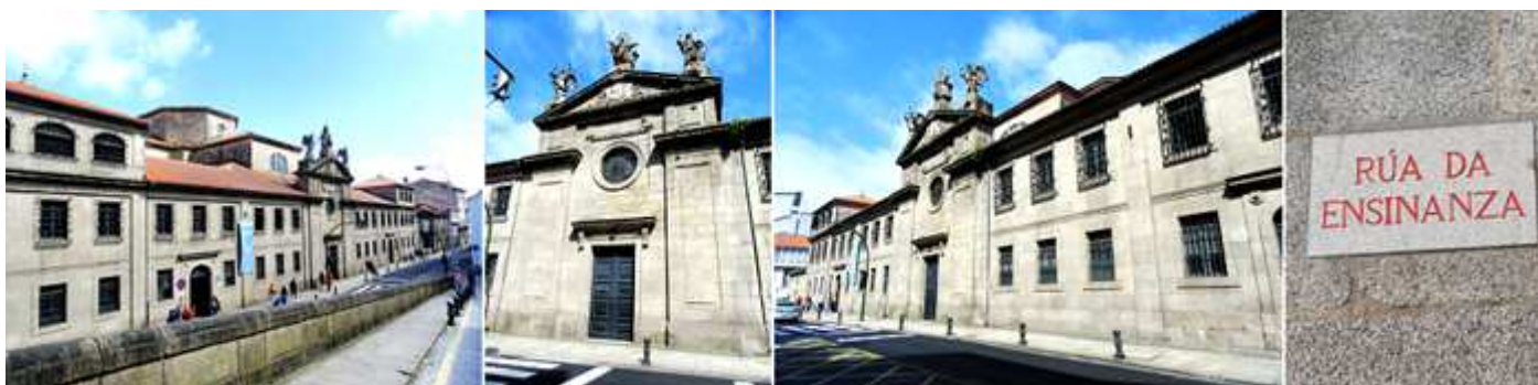
❶ Una amplia fachada con la portada del templo en la parte central en esta Rúa de la Ensinanza. ❷ Austera portada de la iglesia con una entrada adintelada con un óculo y un frontis triangular que corona con un escudo de su fundador el arzobispo Rajoy y Losada y sobre el mismo la Inmaculada con dos ángeles en los laterales. ❸ Es un edificio de dos plantas construido en granito y que ocupa una considerable extensión. ❹ Rótulo de la calle.
