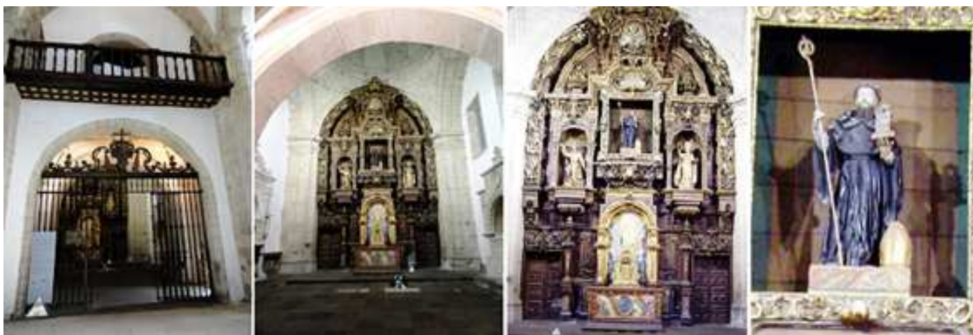
❶ Capilla con los sepulcros de los Gallegos Ilustres. ❷ Al fondo el retablo. Con los sepulcros en los laterales y en el suelo. ❸ Retablo dorado de tres calles. ❹ San Vicente Ferrer en la calle central. Este retablo se restauró en el año 2000.
