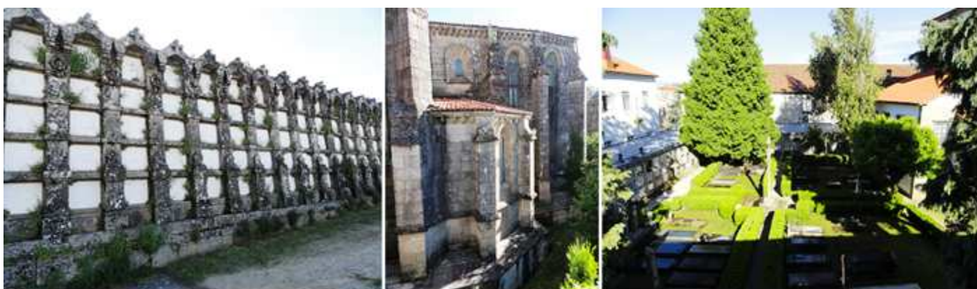
❶ Lienzo con sepulturas adosado al cementerio por la parte exterior y frente la cabecera del templo. ❷ Ábside del lado epistolar y la cabecera desde la terraza que hay ante el cementerio. ❸ Jardines del monasterio, vistos desde la terraza.
