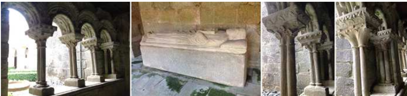
1 Esta ala conserva las nueve arcadas del claustro original. 2 Sepulcro del Canónigo Don Bernardo Arias de granito, con inscripciones en el frontal. † 1291. 3 Sus arcadas tienen unos elaborados arcos de medio punto sustentados por dobles columnas. 4 Arcos decorados interior y exteriormente con multitud de detalles cubiertos por guardapolvos que descansan en impostas y con capiteles decorados con motivos vegetales descansando sobre paralelos de columnillas.
