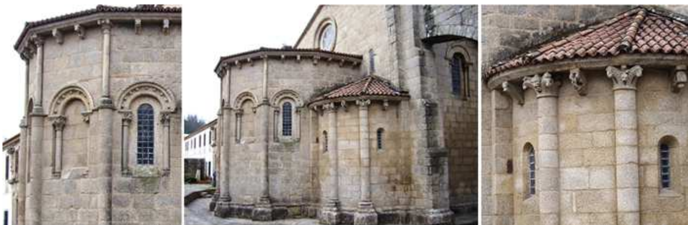
❶ Detalle de los paños del ábside central abierto con ventanas de medio punto con arquivoltas acanaladas y decoradas con bolas mas columnas y capiteles decorados, de sus cinco ventanas exteriores dos son ciegas. ❷ Sobre el ábside central se abre para la iluminación del templo un gran óculo. ❸ Todos los ábsides con columnas redondas adosadas con capiteles con volutas vegetales y canecillos variados.
