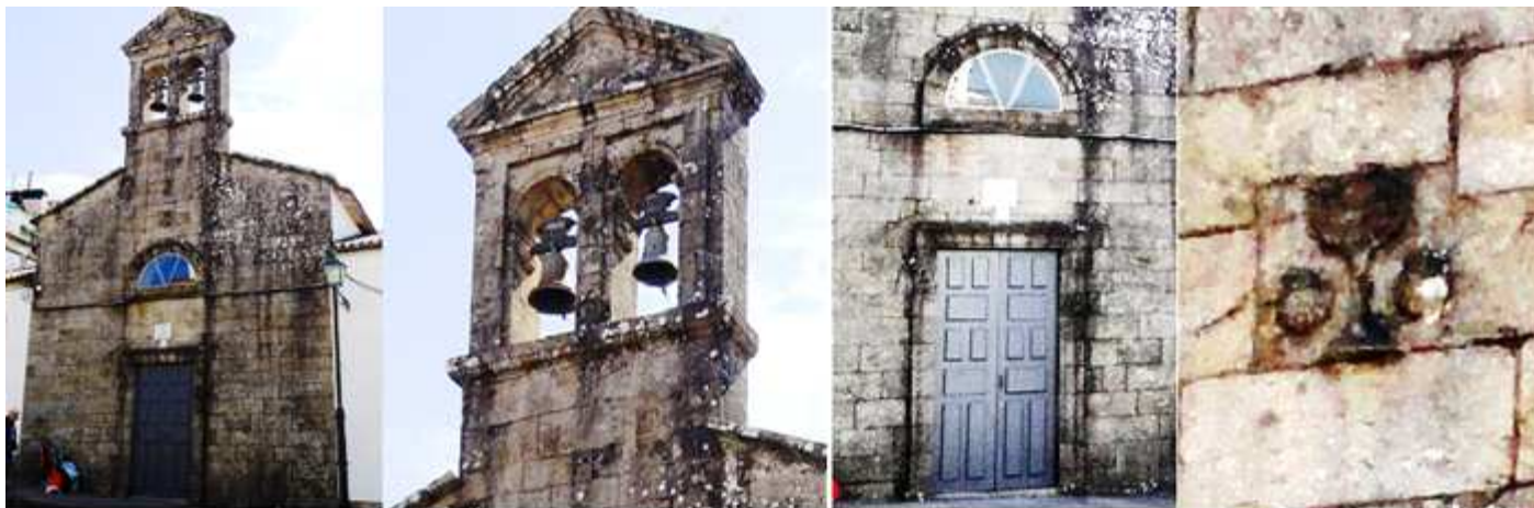
❶ Su parte central construida con piedra sillar. ❷ Cuerpo de su doble espadaña culminada con un frontis triangular. ❸ Su sencilla puerta adintelada. ❹ Y sobre el dintel de a puerta tiene un relieve con un copón con dos conchas a sus lados..
