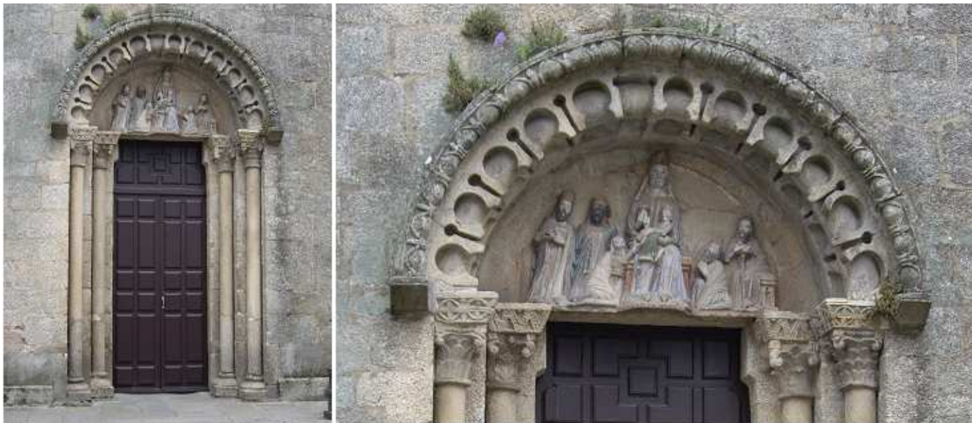
❶ Su puerta con una arquivolta, y guarda lluvias. ❷ Portada con dos capiteles a cada lado decorados con hojas vegetales bajo impostas decoradas en ziz-zag y aros con flores, en su tímpano el relieve de la Epifanía (gótico) de lo que construyó el arzobispo Gelmírez de 1316.
