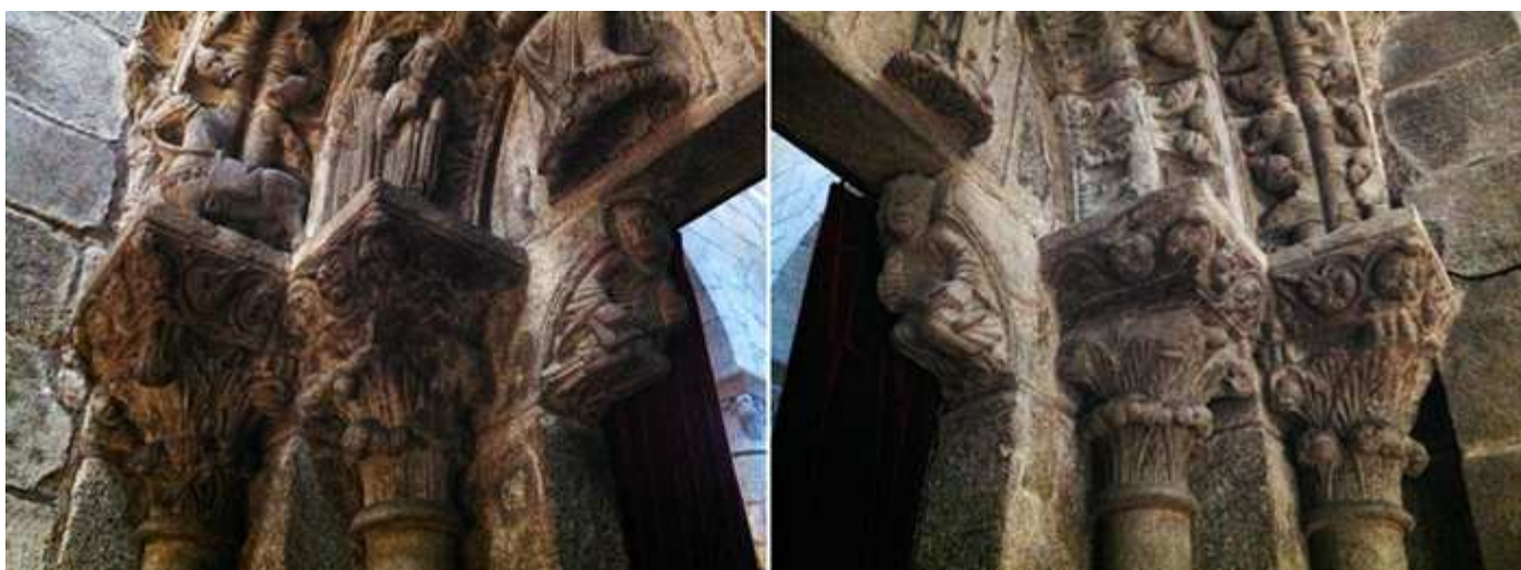
❶ Capiteles del lado izquierdo y la ménsula que sostiene el tímpano. Decorados con motivos vegetales sobre impostas con roleos. ❷ Capiteles del lado opuesto con diferentes labrados.
