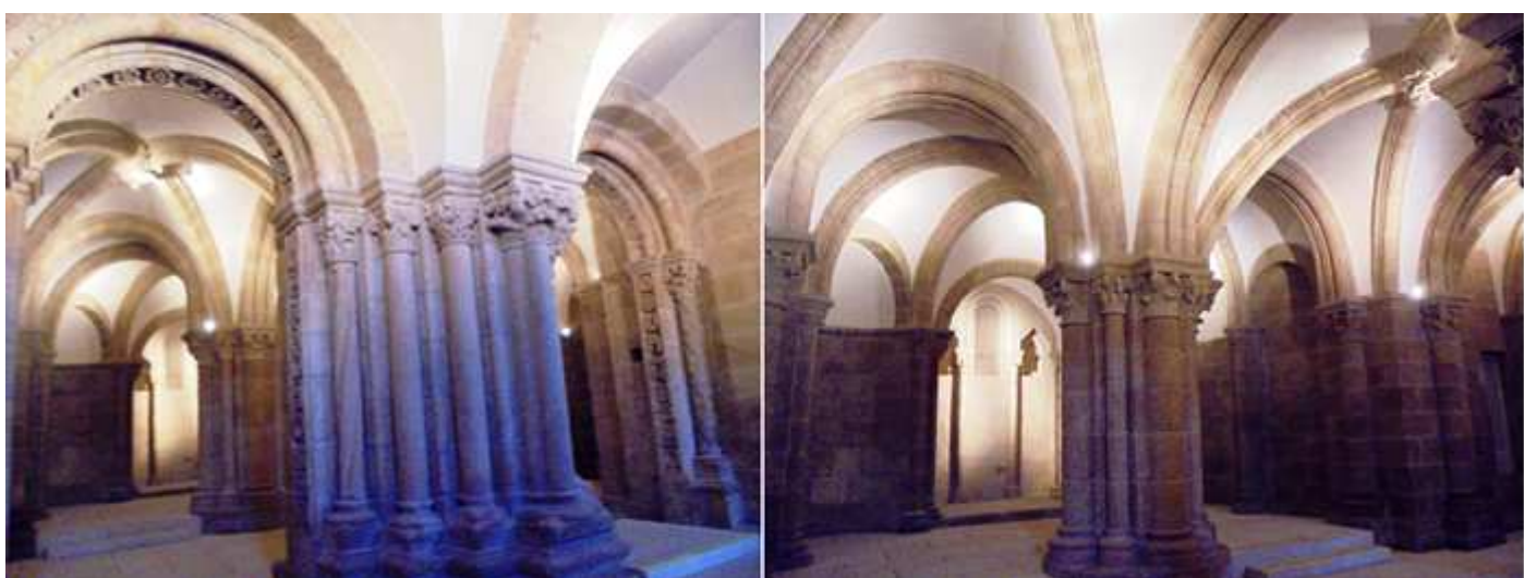
❶ Imagen tras el pórtico del primer tramo de la nave. ❷ En esta la agrupación de columnas (central) se ha reducido considerablemente, corresponde al segundo tramo de la nave. Y al fondo la cabecera con sus tres ábsides.
