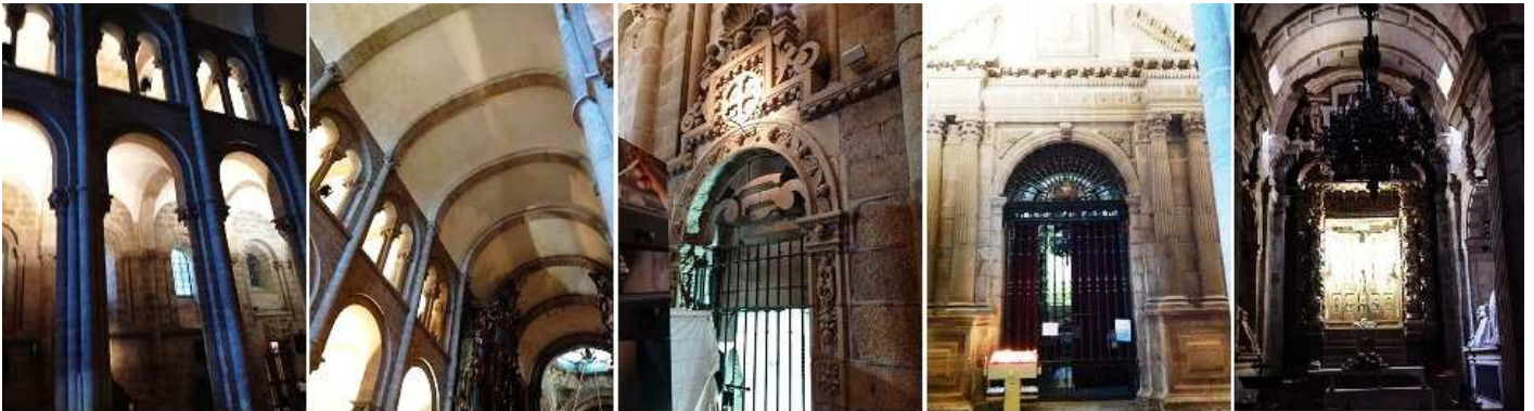
1 Vista de la galería sobre la nave lateral de la central de la catedral. 2 Bóveda de cañón de la nave central ligeramente rebajada sobre arcos fajones. 3 Capilla lateral según se entra a la izquierda de ¿San José?. 4 Portada de la capilla del Santo Cristo de Burgos. 5 En el altar tiene una talla del Santo Cristo en madera de autor desconocido y realizada en Burgos. A los lados están los mausoleos del cardenal García Cuesta †1873 y del arzobispo Pedro Carrillo y Acuña †1667, obra de Pedro del Valle.
