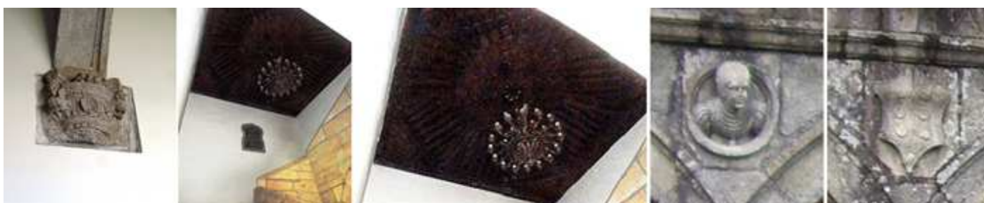
1 Ménsula con una concha. 2 Escalera desde el claustro. 3 Con artesanado de madera ochavado. 4 Medallones en la enjutas de los arcos del claustro. 5 Que se alternan con los Escudos de Alfonso Fonseca III.
