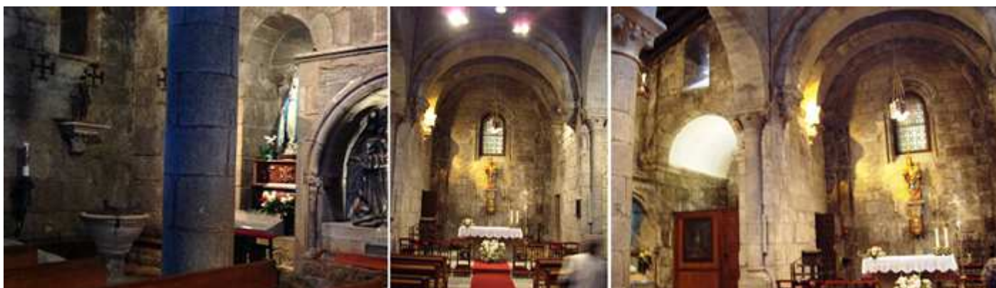
❶ parte inferior de la nave del Evangelio. ❷ Parte central de la cabecera con la Virgen de la Consolación. ❸ Absides izquierdo y central de la capilla.
