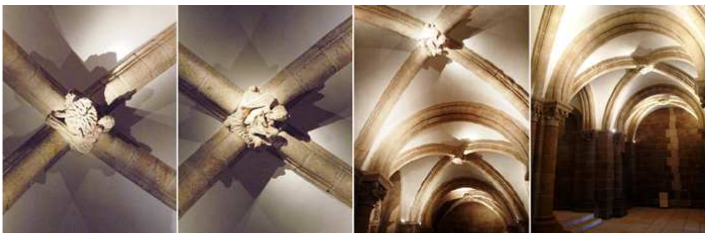
❶ El tramo próximo a la cabecera cuenta su crucería con claves decoradas. En esta el ángel sostiene un disco solar. ❷ Este otro ángel porta el símbolo de la luna. ❸ Sus bóvedas de crucería cuentan con nervios baquetonados. ❹ Imagen del segundo con el tramo de la nave epistolar al fondo.
