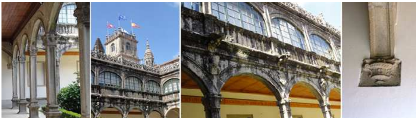
1 Los capiteles mantienen formas distintas. 2 Desde este ángulo se ve la torre del pazo y/o colegio y las de la catedral. 3 En primer piso dispone de una balaustrada con arcos mucho más rebajados (carpaneles) y cerrada. En la parte interior de la galería baja dispone de una inscripción epigráfica. 4 Ménsula de los arcos interiores de las galerías.
