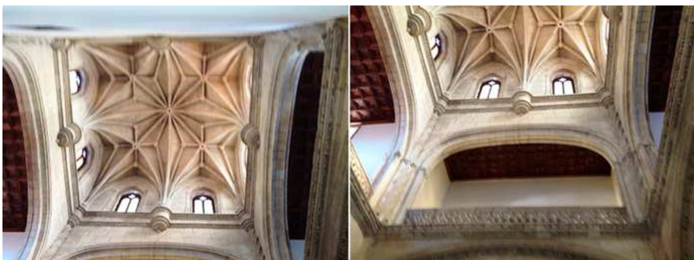
❶ Bóveda del crucero estrellada de Juan de Álava realizada en 1527, con una linterna con ocho ventanales de arcos rebajados. Construida esta bóveda con piedra de Coímbra. ❷ los lados del crucero conforman una tribuna, donde los enfermos podían seguir los oficios litúrgicos. Desde su cama, y en un lateral se comunica con una puerta al antiguo observatorio de moribundos que estaba situado sobre la sacristía.
