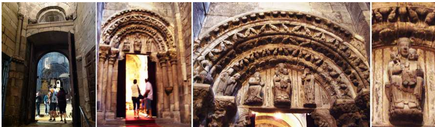
❶ Puerta del primer tramo desde el crucero, que la une a la catedral del S. XVII. ❷ Puerta románica con tímpano y dos arquivoltas sobre columnas con capiteles de principios del S. XIII. ❸ Cubierta con un guardapolvo su arquivolta exterior con un labrado con hojas vegetales vueltas y la interior con un trabajo similar y dos reyes a la derecha. En el centro del tímpano la Virgen con San José a la derecha y un rey mago arrodillado a la izquierda. ❹ Imagen de la Virgen con el Niño sedente.
