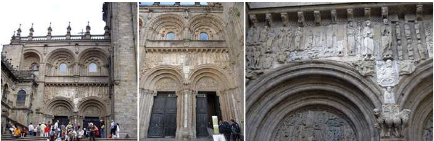
❶ Esta portada esta ante una amplia escalinata. ❷ Dotada con dos puertas de medio punto. ❸ Donde se encuentra un amplio conjunto iconográfico desde el Padre Eterno, hasta la representación de un crismón con el principio y el fin.
