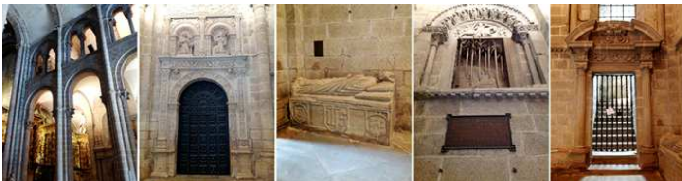
❶ Esquina del crucero con la nave central, junto a la capilla Nuestra Señora del Pilar. ❷ Puerta de entrada al claustro desde el templo. ❸ En este dintel de una de las puertas de la antigua basílica rodeado de una corona de ángeles que se ve arriba está representada la maravillosa representación del apóstol Santiago en la batalla de Clavijo en la cual libró a España del exterminio que la amenazaba. Este tímpano es del S. XI. ❹ Escaleras de acceso.
