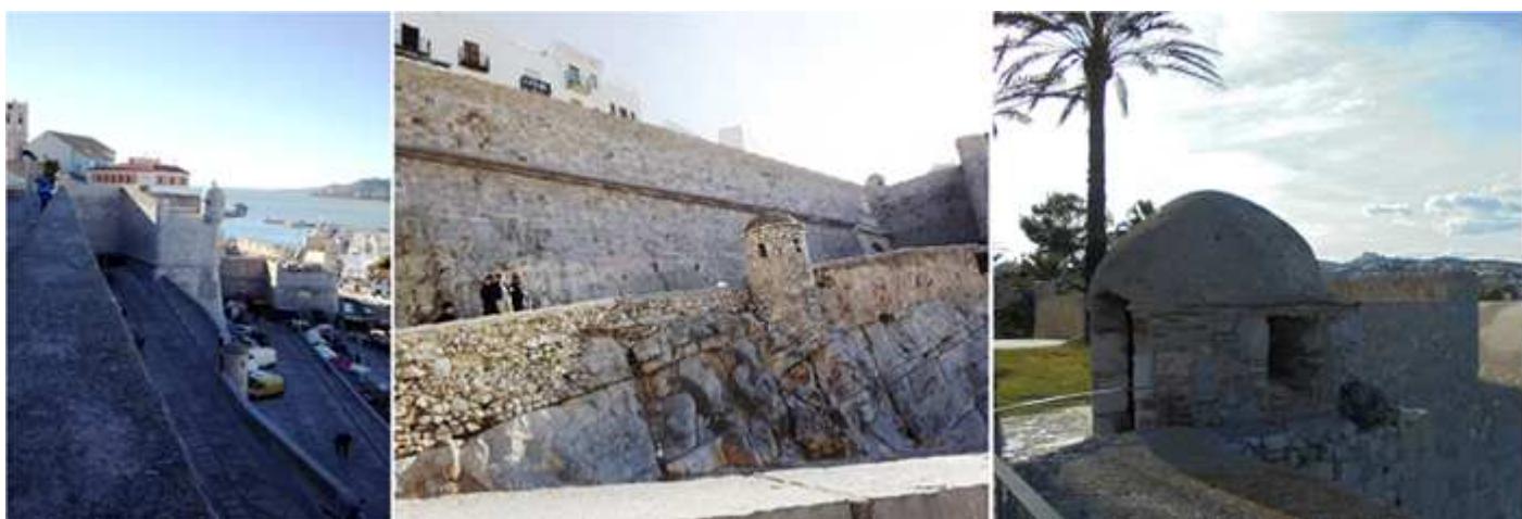
❹ Rampa de Felipe II ❺ Otra vista de esta empinada rampa de dos tramos. ❻ Rincón del Parque de artillería espacio de varias secuencias.
