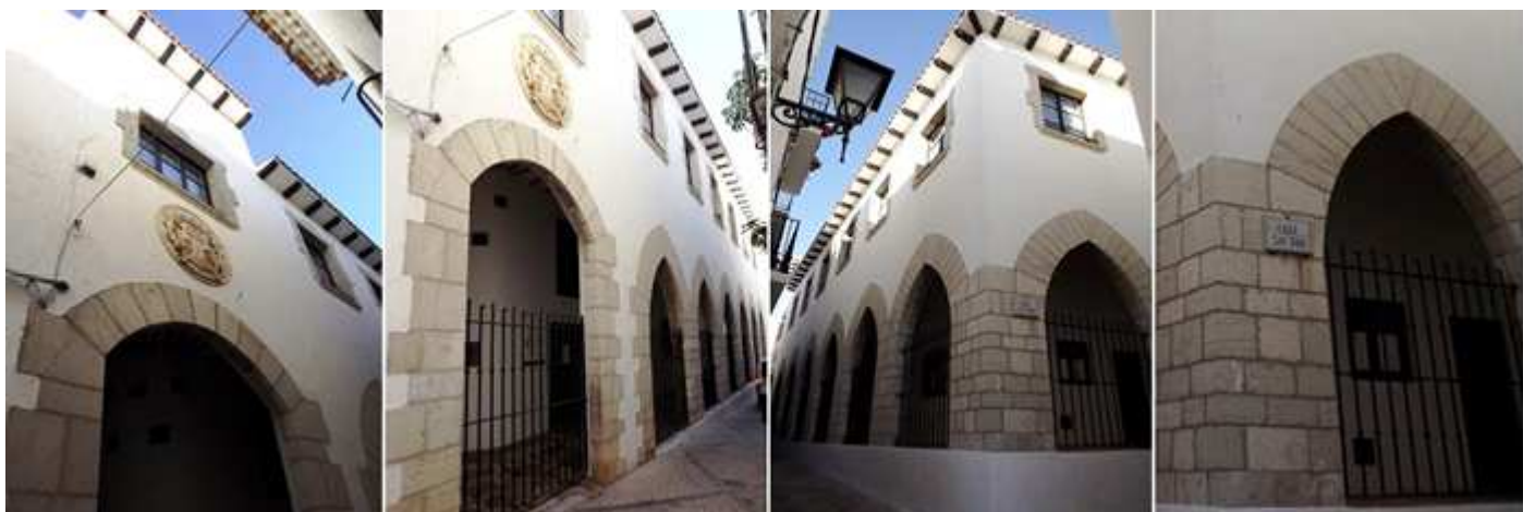
❶ Sobre el arco rebajado de entrada el escudo redondo de Peñíscola moderno. ❷ A demás de este arco rebajado en la calle Juan José Fulladosa le siguen otros cinco arcos apuntados. ❸ Fachada del palacio con la calle de San Juan. ❹ Calle San Juan donde cuenta con dos arcos más
