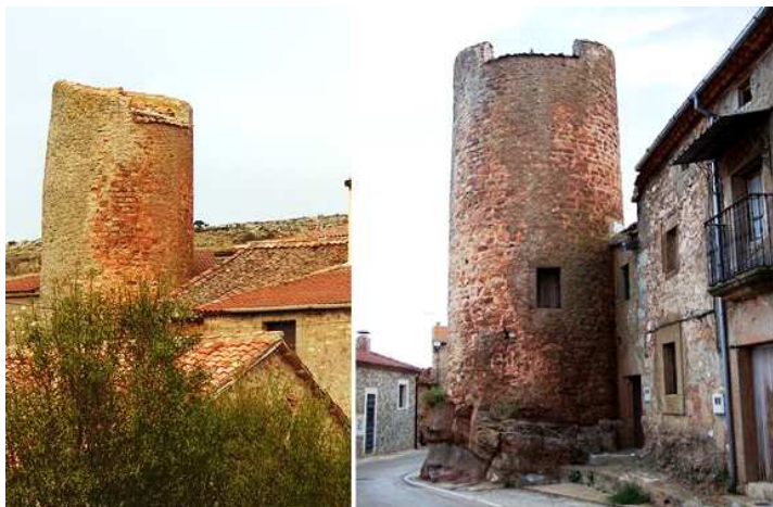
❶ Esta torre de vigilancia que se encuentra entre las casas del caserío y no en un lugar elevado. ❷ Detalle de la parte inferior asentada en la roca y su puerta de entrada a cierta altura.
