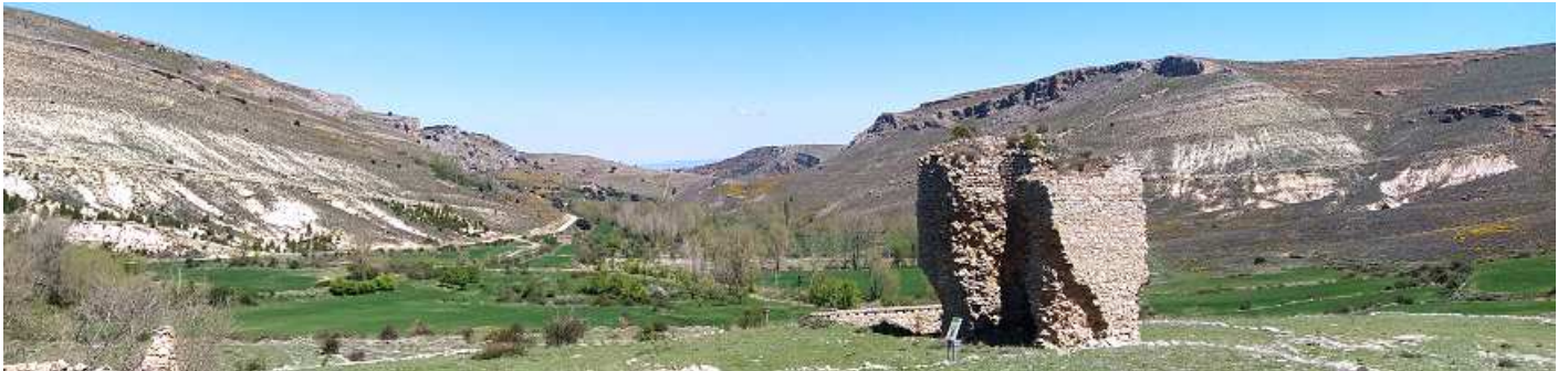
① Los restos de la torre llamada fortín (al fondo se atisba la ermita y la atalaya). Fotos: Diego Pacheco Landero.
