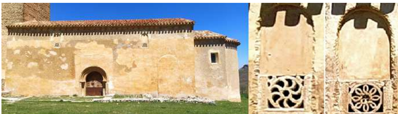
❶ El lado epistolar tras la puerta presenta un arco cegado. La nave posee bajo su alero canecillos lisos. ❷ En el lateral se encuentran en los arcos cegados dos celosías, en esta una rueda de brazos curvos. ❸ Y esta con lazos. Fotos: Diego Pacheco Landero.
