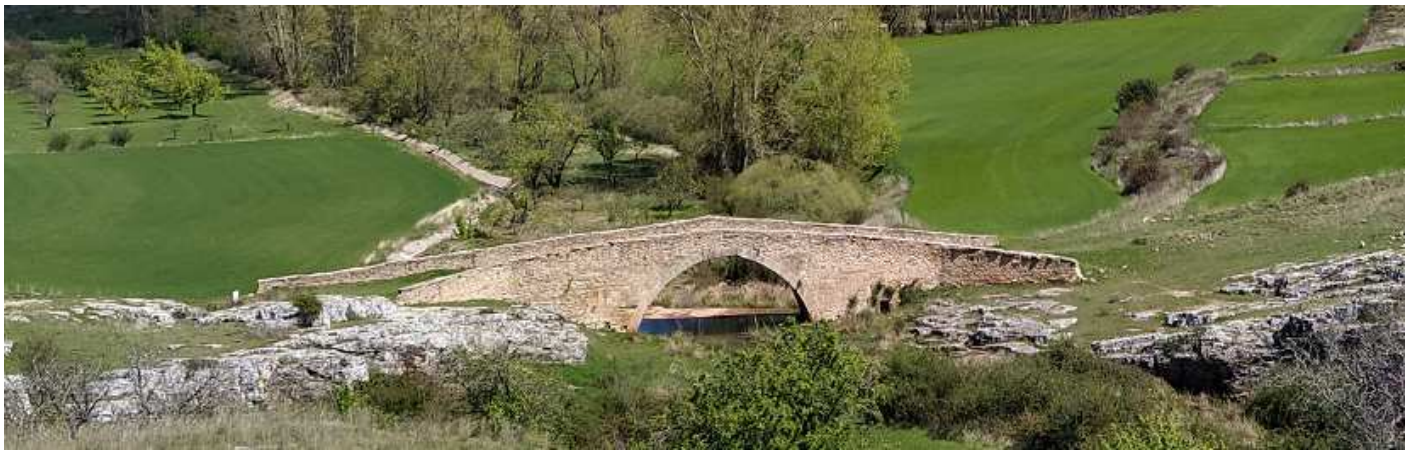
❷ Puente sobre el río Caracena de un solo ojo con ligero "lomo de asno". Se asienta en sus laterales sobre roca viva. Fotos: Diego Pacheco Landero.
