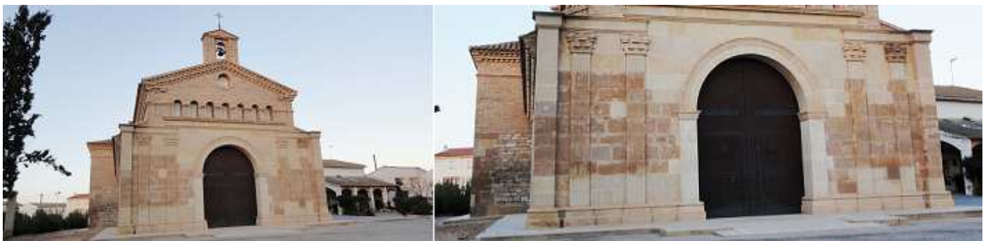
❶ Ermita de Los Dolores sobre su portada dispone de siete ventanas de medio punto. ❷ En su interior consta de una nave cubierta con bóveda de medio cañón.
