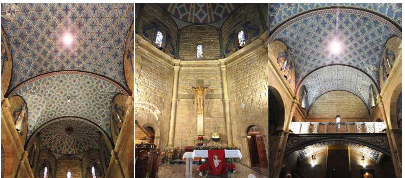
❶ Bóveda de La Natividad de Ntra. Sr a . ❷ Cabecera poligonal con cúpula rebajada, con el Altar Mayor y a los lados se abren dos dependencias. ❸ Imagen del coro elevado sobre un arco y barandilla de tradición mudéjar.
