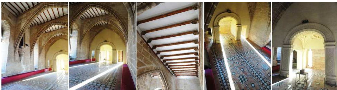
1 - 2 - 3 Mas detalles de sus arcadas y sus techos que alguna de las vigas aún conservan su policromado. 4 - 5 Vista desde el púlpito de sus suelos y de la capilla absidal en la cabecera, esta de planta cuadrada.
