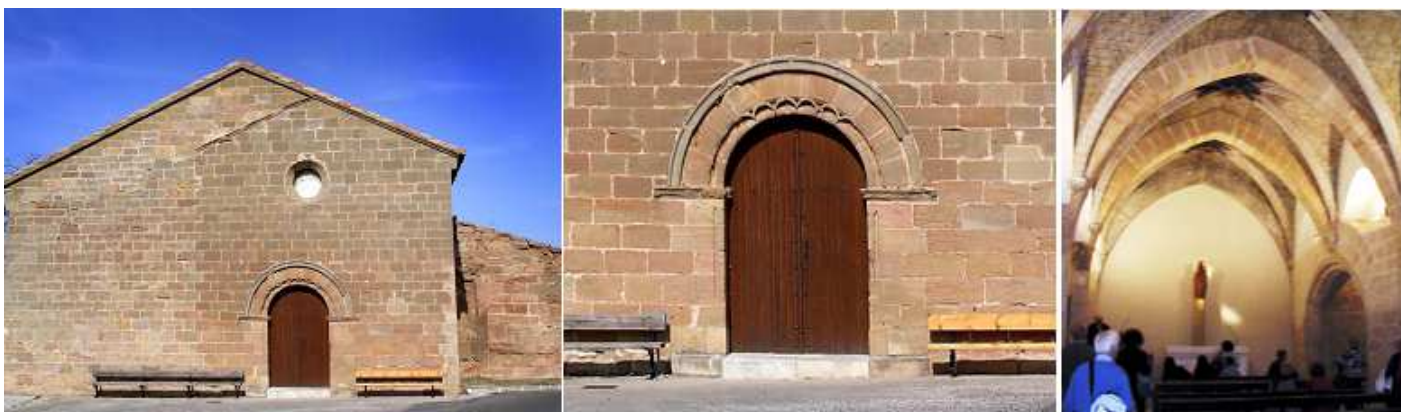
📍 Fachada de la Ermita del Pilar. 📍 Portada de medio punto con sus arquillos en la parte interior (los que quedan). 📍 Interior de la nave con sus arcos fajones apuntado arrancando desde ménsulas decoradas.
