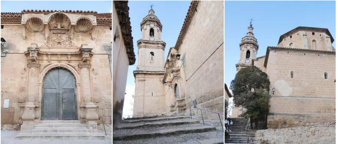
❶ Imagen de la portada completa. ❷ A los pies del templo en este muro lateral se encuentra la torre cuadrada de tres cuerpos, siendo el último como campanario octogonal. ❸ El cabecero del templo es recto exteriormente.
