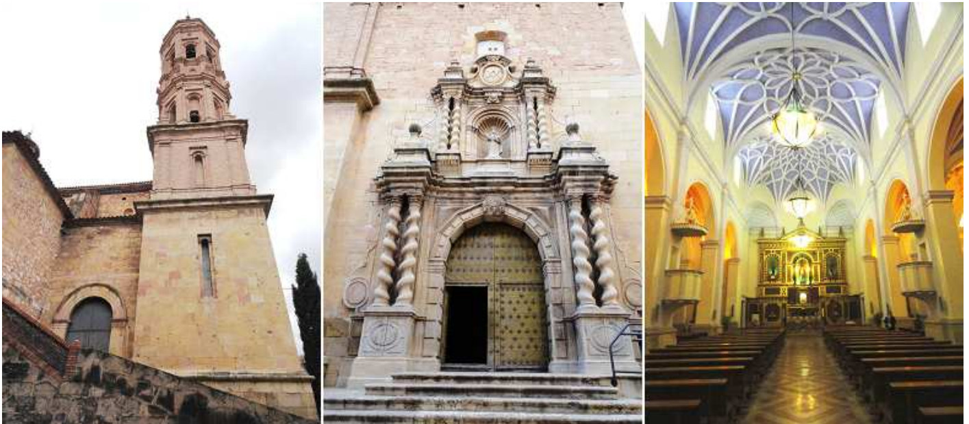
❶ Torre de cuatro cuerpos, siendo los dos primeros de planta cuadrada y los dos últimos octogonales en ladrillo, y que mantiene la tradición decorativa mudéjar. ❷ Portada barroca, posiblemente obra de canteros franceses. ❸ Nave central del templo con la crucería estrellada de su bóveda.
