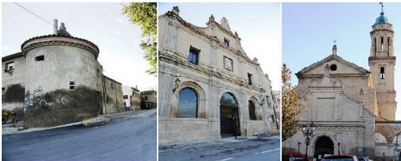
❶ Restos del perímetro amurallado que disponía la Cartuja. ❷ Portada de la Portería de estilo barroco. ❸ Fachada de la iglesia y su torre, cuadrada y el último cuerpo octogonal, siendo su obra de ladrillo.
