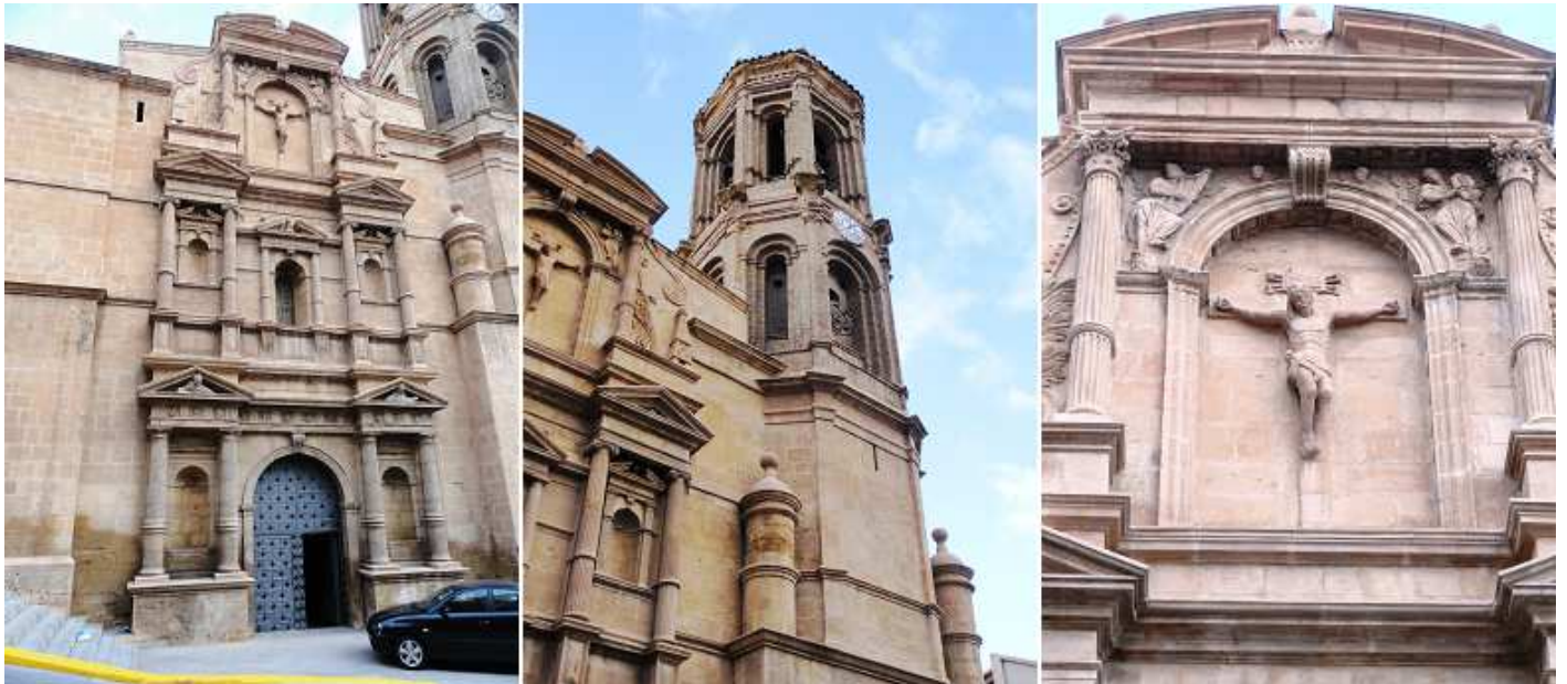
❶ Fachada con los tres órdenes arquitectónicos griegos: dórico, jónico y corintio. ❷ La torre fue construida en 1660 siendo los dos primeros cuerpos de piedra y los dos siguientes de ladrillo. ❸ Cristo crucificado entre unos ángeles. Fachada claramente Manierista.
