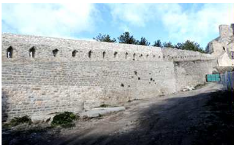
1 Murallas del lado sur.
