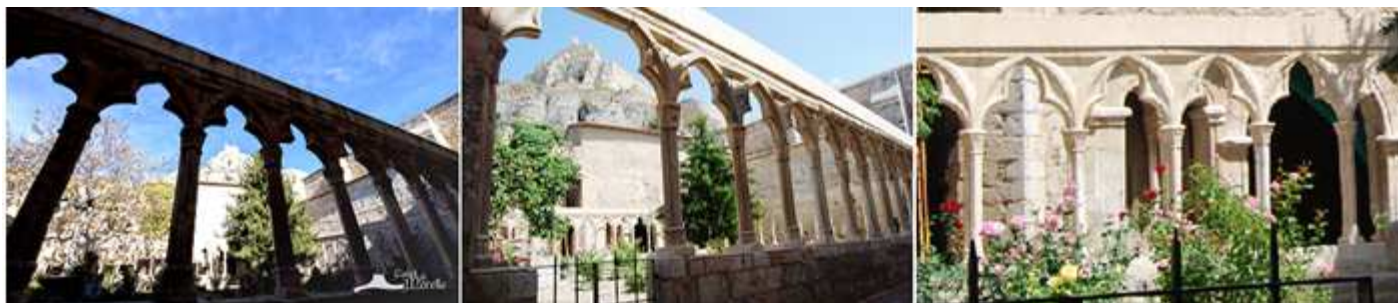
❶ Las pandas del claustro sin bóvedas. ❷ Con un jardín en su interior. ❸ Arcos trilobulados. Fotos: Oficina Turismo de Morella.
