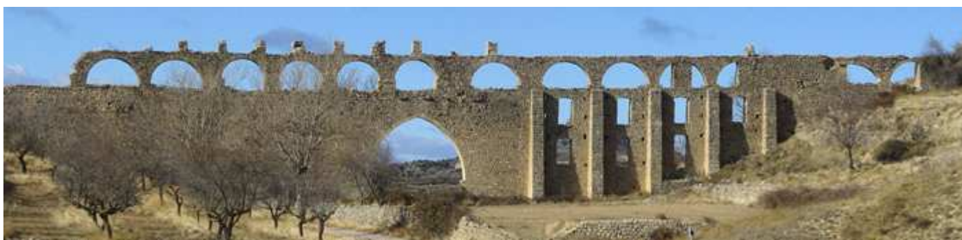
📍 Panorámica del acueducto entrando por la carretera.
