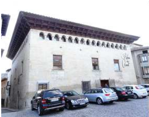
1 Fachada principal del palacio Miró.
