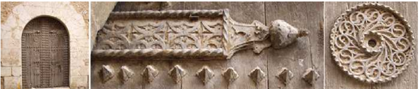
❶ Puerta de la parte inacabada de la iglesia con dovelas lisas. ❷ Y posee estos interesantes herrajes en la misma. ❸ Con filigranas en los mismos.
