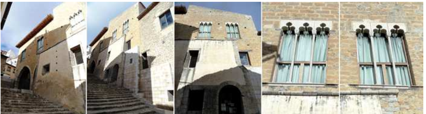
1 Escaleras en uno de sus laterales con la lonja en su parte inferior. 2 En la planta noble varias ventanas dos biforas y dos triforas con arquería tetra lobulada. 3 Entrada a las dependencias y la prisión medieval. 4 - 5 Ventanas con triple arquillo en la parte derecha de su fachada.
