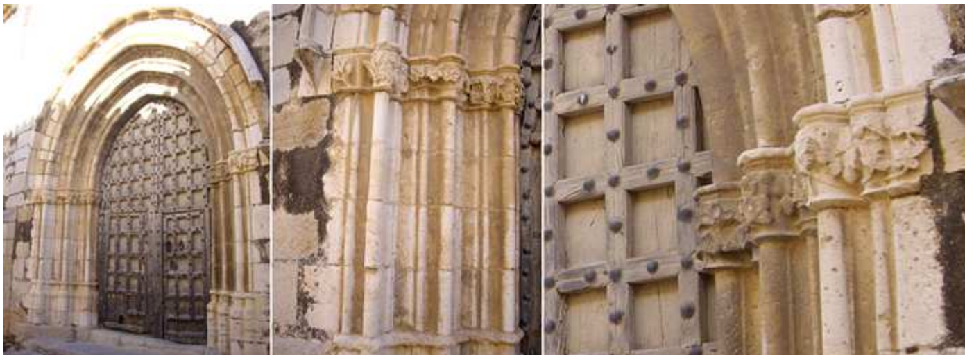
❶ En el lateral del Evangelio se encuentra esta puerta de arco apuntado con tres arquivoltas. ❷ Detalle de las columnas y los motivos florales de sus capiteles corridos. ❸ Y los del lado derecho
