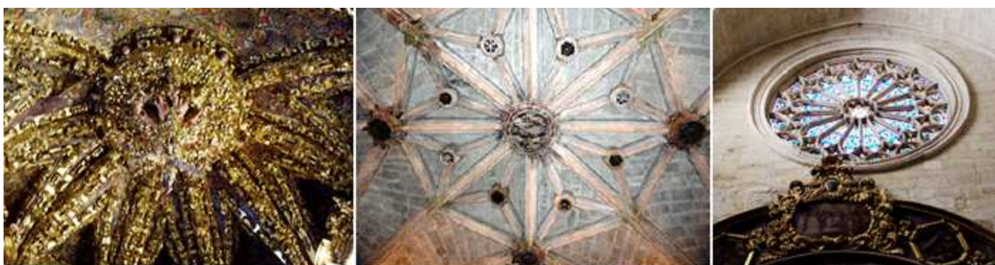
1 Clave de la bóveda del altar Mayor. 2 Bóveda de coro con elaboradas claves policromadas. 3 Rosotón sobre la capilla del baptisterio.
