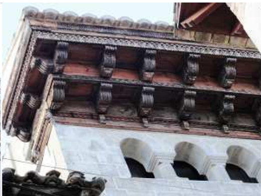
2 Detalle de su amplio alero de Madera.
