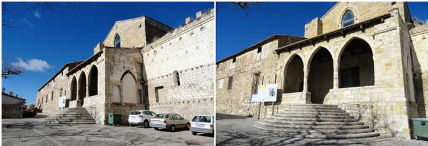
❶ Fachada del convento de San Francisco. ❷ Con una gran escalita de acceso a su templo con un pórtico con arcos ojivales.
