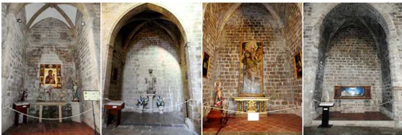
1 - 2 - 3 - 4 Capillas en el lado del Evangelio alojadas en los contrafuertes con bóvedas de arco apuntado y de crucería.
