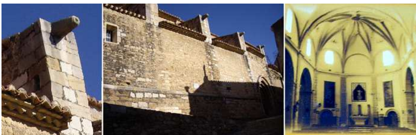
❶ Una de las gárgolas sobre los contrafuertes. ❷ Lateral del lado del Evangelio donde dispone de su otra entrada. En la calle de Fredes ❸ Su cabecera poligonal con bóveda de crucería estrellada. Foto del panel informativo.
