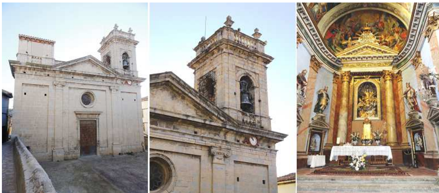
❶ Fachada de estilo Herreriano con tres cuerpos de buena piedra sillar con dos pilastras adosadas, y un remate clásico, el frontón. ❷ Su torre de lado de la Epístola, es la que está acabada y alberga las campanas, en arranque de la torre dispone de un reloj de 1889. ❸ Altar Mayor de mazonería realizada por los Ferrer de Mirambel.
