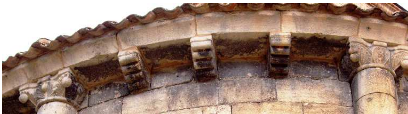
❸ Bajo la cornisa podemos apreciar modillones de cuatro rollos escalonados en buen estado de conservación.
