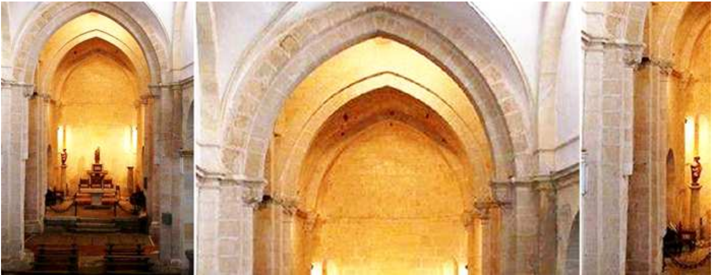
❷ Nave central de Nuestra Señora del Campanario. ❸ Arcos fajones del presbiterio y ábside central. ❹ Arranque desde ménsulas de sus arcos fajones. Foto enviada por la oficina de Turismo.
