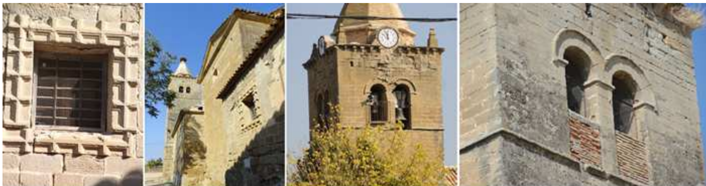
❶ Esta sacristía posee esta ventana que dispone de este marco en piedra. ❷ El lado epistolar con la torre al fondo. ❸ Los relojes entre el alero de su torre y el tambor del chapitel piramidal. ❹ Detalle de estas dos ventanas cegadas en parte.
