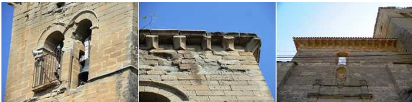
❺ Ventanas de la torre que dan al mediodía. ❻ El alero de la torre con canecillos de nacela. ❼ Parte superior de la fachada.
