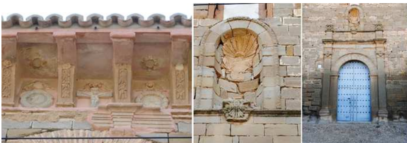
❶ Su cornisa realizada en yeso con una decoración variada en sus modillones. ❷ Hornacina aveverada que ya ha perdido parte de su estuco decorativo y en el exterior de su arco dispone de un cordón vegetal en relieve. ❸ Su puerta a los pies.
