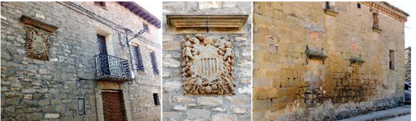
❶ Casa de los Otales en la calle xxx ❷ Sobre su fachada construida con cantería ostenta este escudos con su armas cuatribarradas rodeada de amorrillos, y a los pies dos figuras con armas de fuego. ❸ Casa construida con piedra de sillería de dos alturas en la calle xxxx.
