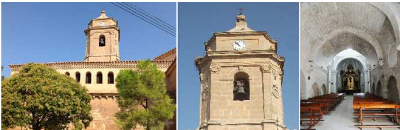
❶ Recrecimiento de la galería sobre el muro románico en los S. XVI-XVII ❷ Cuerpo superior de la Torre con sus ángulos achaflanados. ❸ Interior de la nave con bóveda apuntada sostenida por arcos fajones que arrancan sobre ménsulas.
