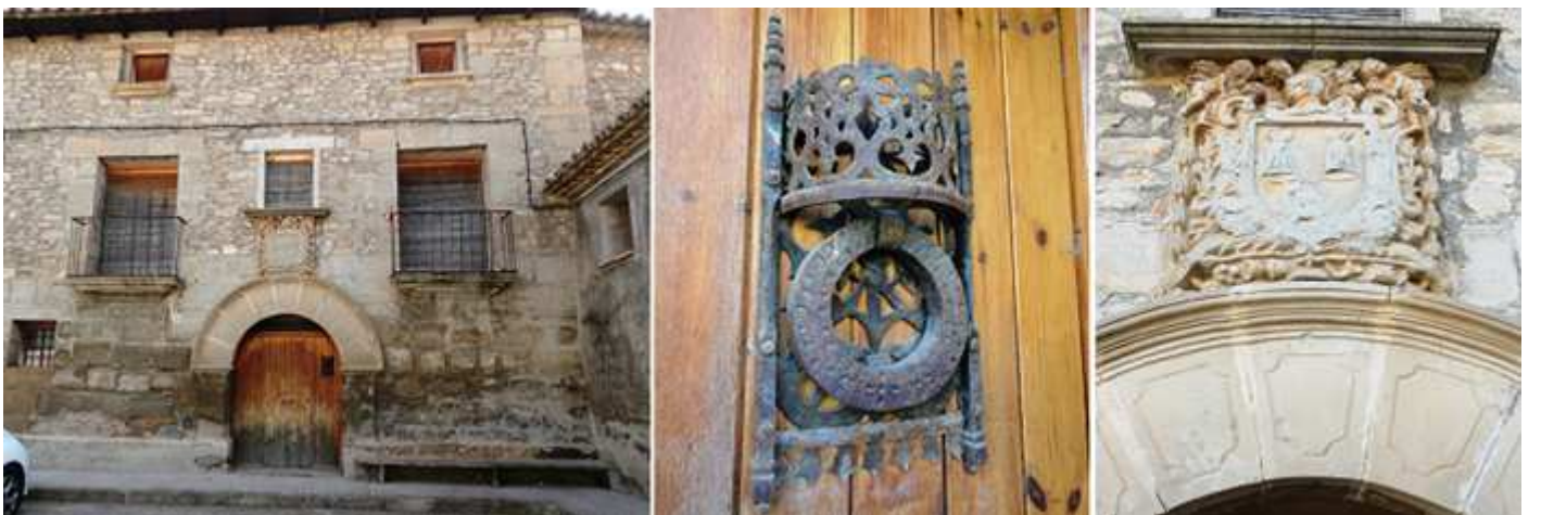
❶ Casa de los Caveros construida con piedra de cantería irregular. ❷ Con este artístico llamador de forja. ❸ Sobre el arco de la puerta su escudo de armas con tres campanas y las filacterias con su nombre, completada con decoración vegetal.
