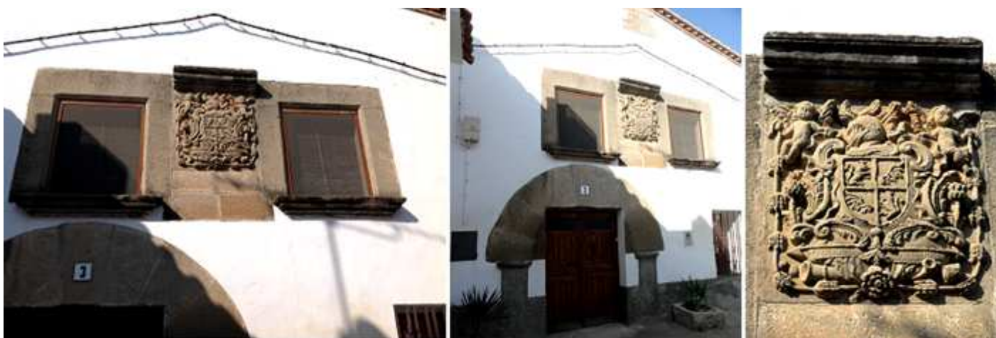
❶ Casa Oliva en la placeta del mismo nombre, nº 3 con un escudo entre sus dos ventanas adinteladas, del S. XVIII. ❷ Posee una puerta de grandes dovelas lisas que ha sido reconvertida en adintelada. ❸ Escudo con profusa decoración, con dos angelitos que sostienen un cordón que lo rodea con yelmos sobre el mismos y cuatro cuarteles con dos leones rampantes y dos alas, bajo el mismo la inscripción: "Armas de los Oliva de Lupiñén".
