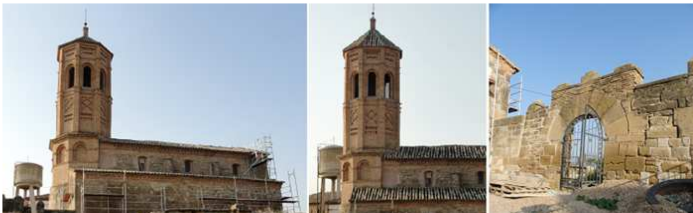
❶ Silueta del templo desde la ermita. ❷ La nave de la Epístola totalmente cerrada y las ventanas de la nave central. ❸ Portón lateral de medio junto a la fachada del templo.
