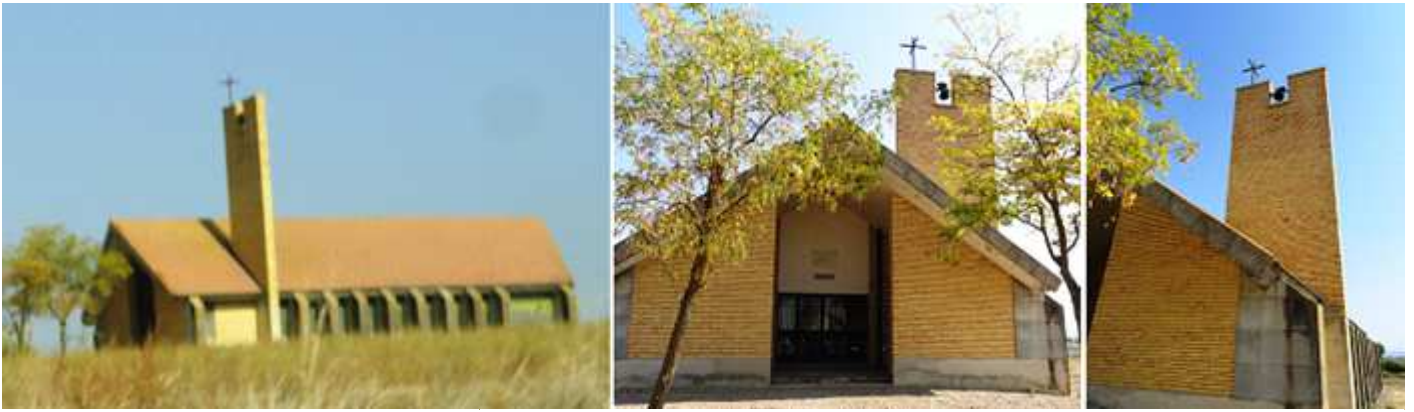
❶ Silueta del templo con su campanario. ❷ Fachada a dos aguas. ❸ Lateral con su campanario en ladrillo.
