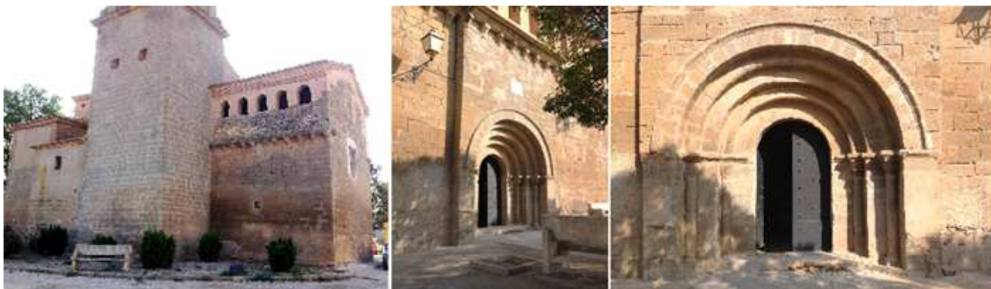
❶ Exterior del lado norte del templo. ❷ Su portada ligeramente adelantada en el lado de la Epístola. ❸ Puerta de medio punto con la degradación de sus cinco arquivoltas.
