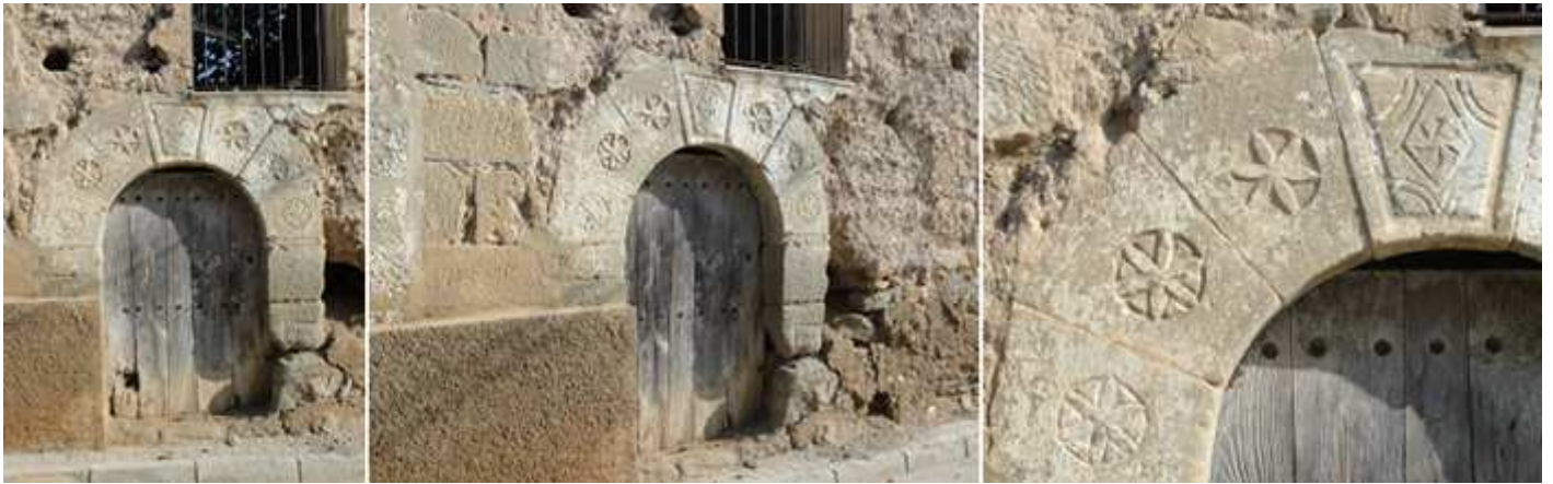
❶ Casa de la calle xx que solo conserva su fachada con esta puerta. ❷ Puerta de medio punto con decoración en su clave y en las dovelas con distintos tipos de rosáceas. ❸ En sus dovelas esta grabadas en unos discos en bajo relieve unas flores de seis pétalos distintas, que se repiten en el lado opuesto del arco, y en su clave central dispone de otra dentro de un rombo.
