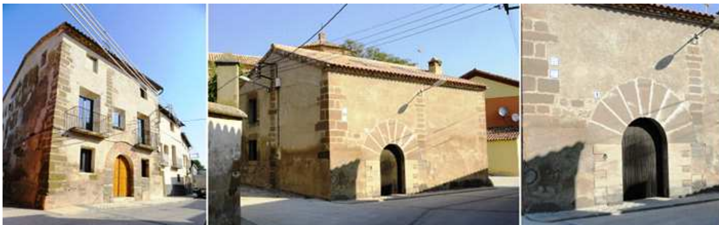
❶ Plaza Mayor. ❷ Granero de la Casa Fabana de 1802, en la calle Mayor, nº1. ❸ Con una puerta de medio punto con grandes dovelas lisas.
