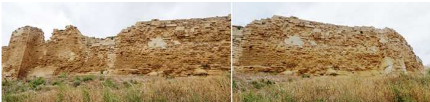
❶ - ❷ Restos de sus muros.
