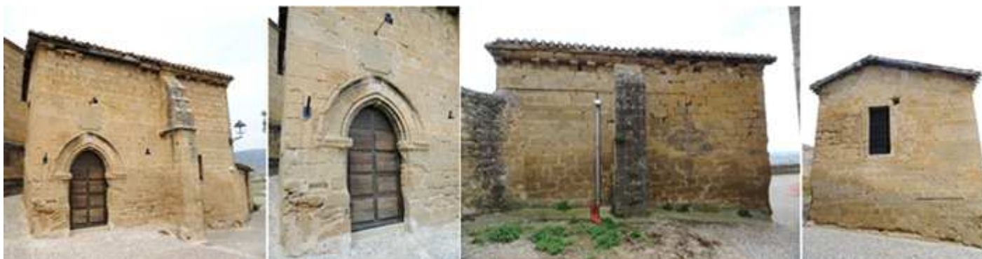
❶ Fachada con una puerta apuntada u un grueso contrafuerte a su derecha. ❷ Puerta con una arquivolta con grandes dovelas lisas que en su interior tiene tres baquetones en degradación sobre una imposta. ❸ Lateral posterior igualmente protegido por otro contrafuerte. ❹ Hastial frente a la iglesia con una ventana adintelada.
