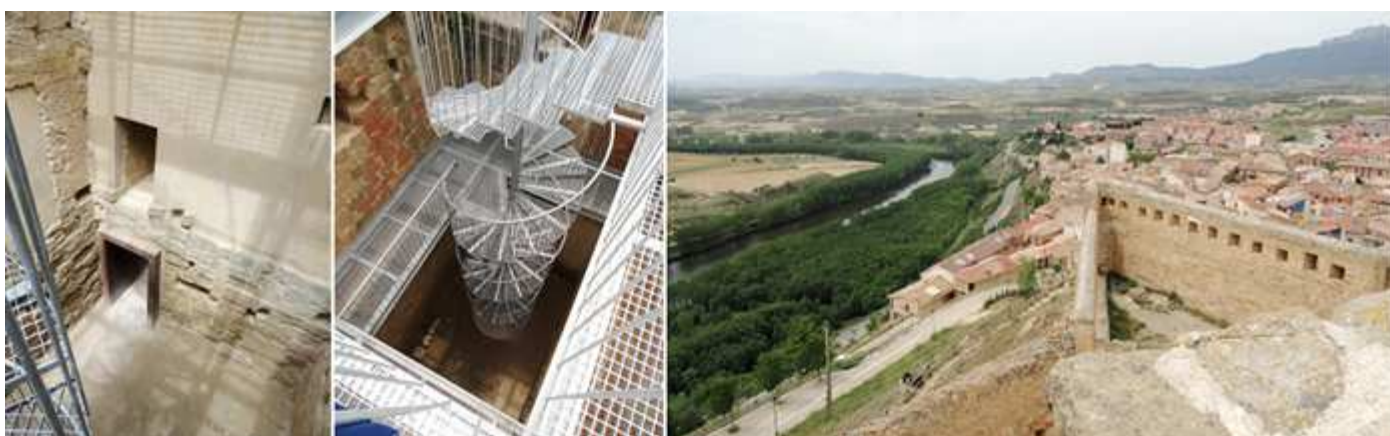
❶ Tras rehabilitarlo esta hueco y con una escalera de caracol metálica ❷ Colocada en su parte central. ❸ Paisaje desde el mirador y uno de los ángulos de la muralla del castillo.
