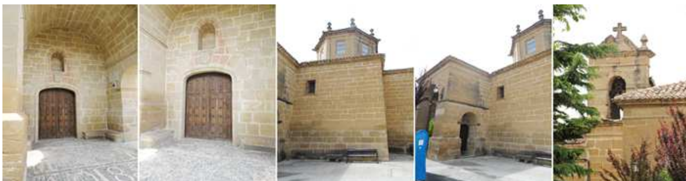
❶ Su portada cobijada bajo este pórtico de arco rebajado. ❷ Y sobre su puerta la hornacina vacía de la Virgen. ❸ Su cúpula octogonal abierta con grandes ventanales adintelados. ❹ Lateral derecho del pórtico abierto con un arco. ❺ Y la espadaña de un solo vano culminada con un frontis con una cruz.
