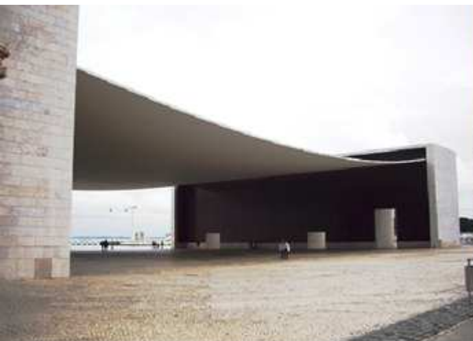
❶ Pabellón de Portugal, con una cubierta de cemento sin más pilares que los edificios de los lados. ❷ Uno de sus laterales.
