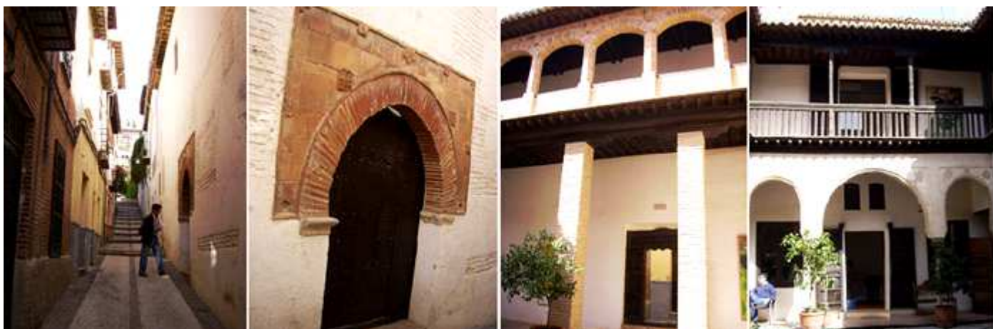
❶ La estrecha calle del Horno de Oro y con algunos tramos de escaleras. ❷ Posee esta puerta de arco de ladrillo algo apuntado sobre impostas y en la parte del arco una decoración enmarcada de cerámica. ❸ El ala del patio junto a su puerta de entrada con una galería de arcos rebajados. ❹ El ala del patio orientada al medio día dispone de tres arcos y sobre ellos una galería abierta.
