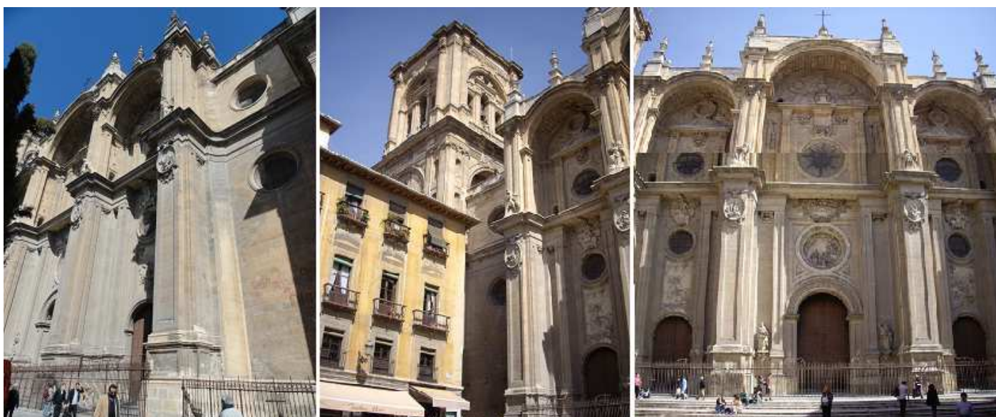
❶ La portada está enmarcada con estos grandes contrafuertes. ❷ Ala izquierda de la misma se eleva su campanario de planta cuadrada. ❸ Montaje fachada completa. Cuando Cano proyectó la fachada principal la concibió como un monumental arco de triunfo. Molduras y pilastras proporcionan al conjunto un intenso ritmo lineal, acentuado por los contrastes luminosos y por el marcado entablamento que le recorre a la mitad de su altura.
