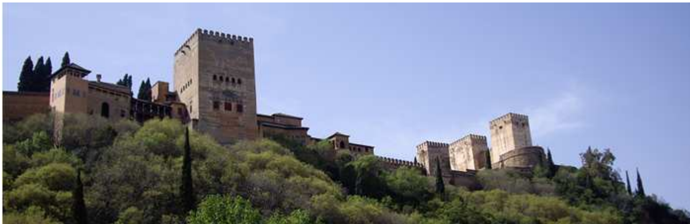
❶ Desde sus jardines hay una visión de las construcciones que dan a esta parte de la colina. A la izquierda la Alcazaba, en el centro la torre de Comares.
