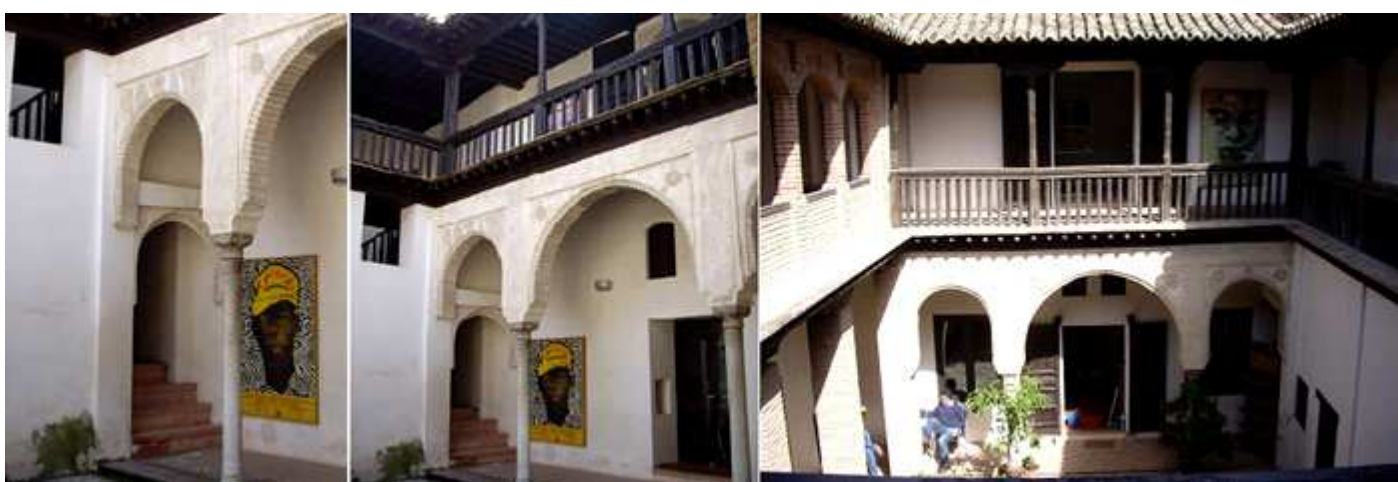
❶ Escalera a la primera planta. ❷ Sus arquerías con columnillas y capiteles con medias lunas de piedra. ❸ Vista del patio desde la primera planta. Las tres galerías están construidas de madera con columnillas y zapatas, con armaduras mudéjares.
