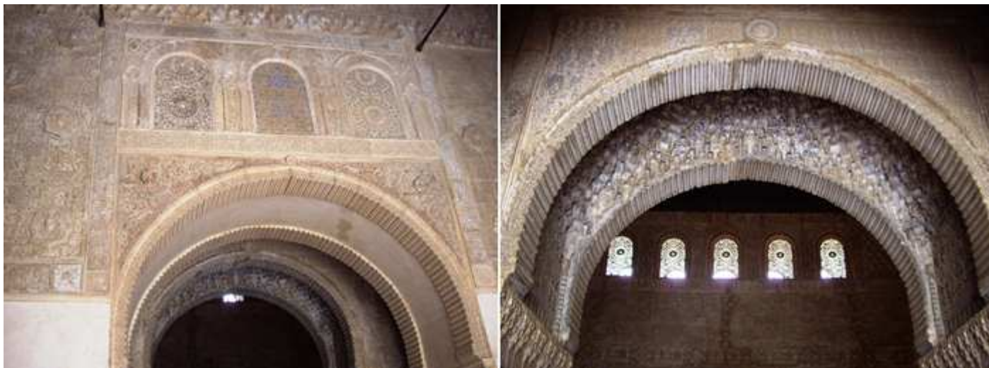
❶ Su fachada bajo el pórtico igualmente esta toda ella trabajada con preciosas labores de yeserías. ❷ Segundo y tercer arco antes de entrar al salón.
