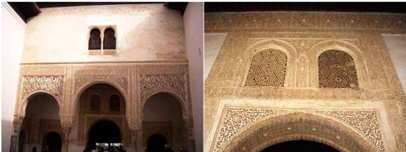
❶ Al norte del patio, tras el característico pórtico de tres arcos se encuentra el Cuarto Dorado, cuya decoración original se debe a Muhammad V. ❷ Puerta de acceso sobre la que posee dos ventanas con caladas celosías. En su interior una bella techumbre cubre toda la sala. Este Patio Dorado es el acceso al Palacio de Comares.
