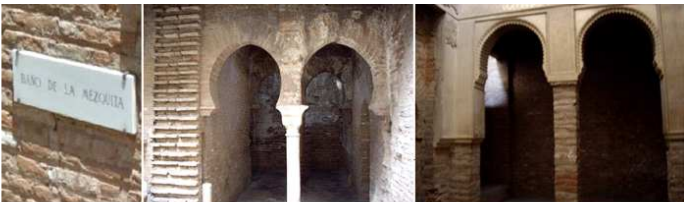
❶ Placa en la fachada de la calle Real. ❷ La sala caliente con alharias laterales separados por arcos de herradura apuntados. ❸ A partir del S. XIX fue bastante la transformación que tuvo.
