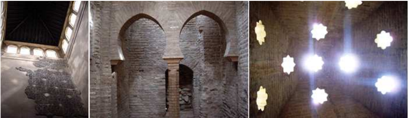
1 El Vestuario con un artesanado a cuatro aguas y con restos de sus yeserías en sus muros. Y abierto con ventanas con celosías. 2 El bayt al-barid o sala fría. 3 Detalle de los lucernarios con estrellas de ocho puntas.
