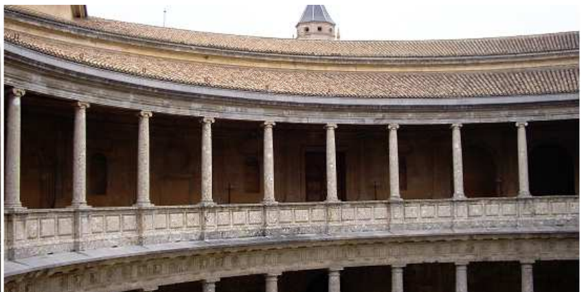
2 Panorámica de la columnata jónica de esta primera planta.
