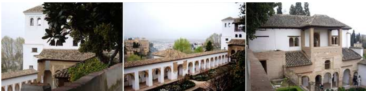
❶ Esta parte el terreno tiene varias terrazas a distinta altura. ❷ Galería porticada junto a los jardines. ❸ Sobre el pórtico un mirador cubierto.
