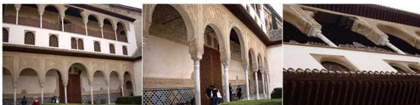
❶ Posee siete arcos en cada planta. ❷ Su parte inferior con un zócalo de azulejos y sobre él una franja con inscripciones. ❸ Detalle del alero del pórtico.
