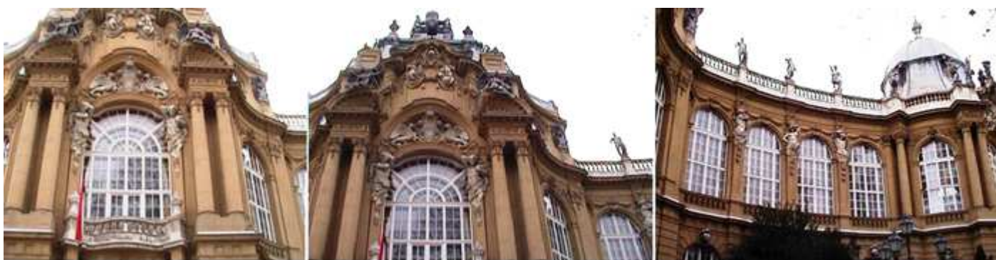
❶ Parte superior de la puerta de entrada del museo Agrícola Húngaro. ❷ Con dobles columnas a sus lados y un balcón. ❸ Y coronado con una balaustrada con estatuas.
