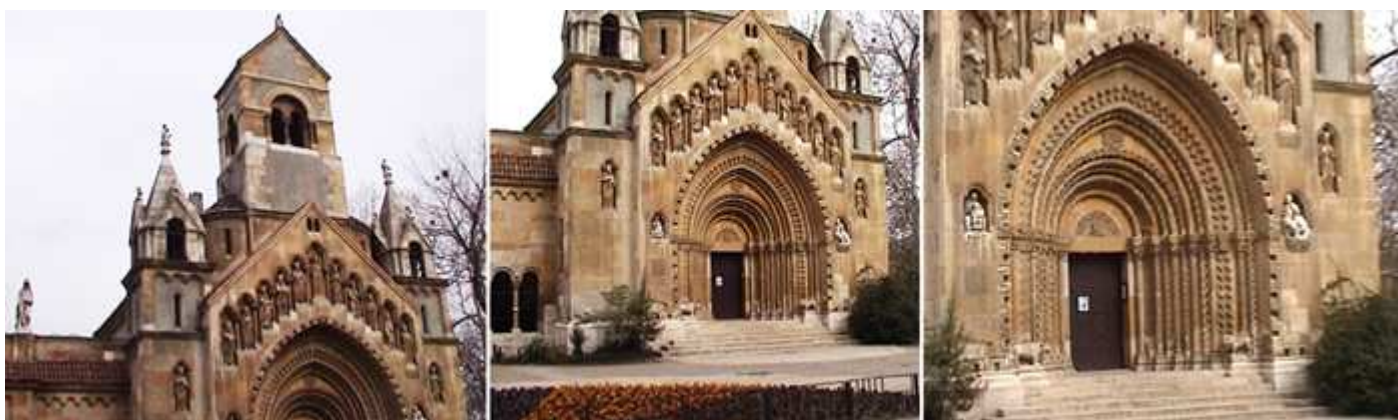
❶ Sobre el cuerpo central de su portada se alza su torre de planta cuadrada de dos cuerpos, el segundo abierto con una ventana ajimezada y con cubierta a dos aguas. ❷ A los lados posee dos torres más pequeñas. ❸ Su portada abocinada por sus arquivoltas talladas con distintos motivos de estilo normando y sobre su puerta un tímpano con Jesús en majestad con dos ángeles, sobre ella en unas hornacinas de arco apuntado se encuentran los Apóstoles. En los jardines delante de este templo esta otra escultura sedente con el político Daranyi Ignac.
