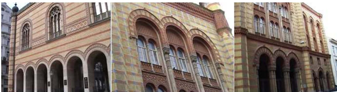
❶ Esquina del edificio de la calle Dohány con Wesselényi. ❷ Parte superior de uno de los cuerpos de la fachada compuesto por unos grandes arcos que cubren las ventanas del primer y segundo piso. Ventanas que son dobles con un fino mainel que las separa. ❸ En la parte inferior tres arcos de medio punto sostenidos con pilastras y capiteles, y los arcos con guarda lluvias.
