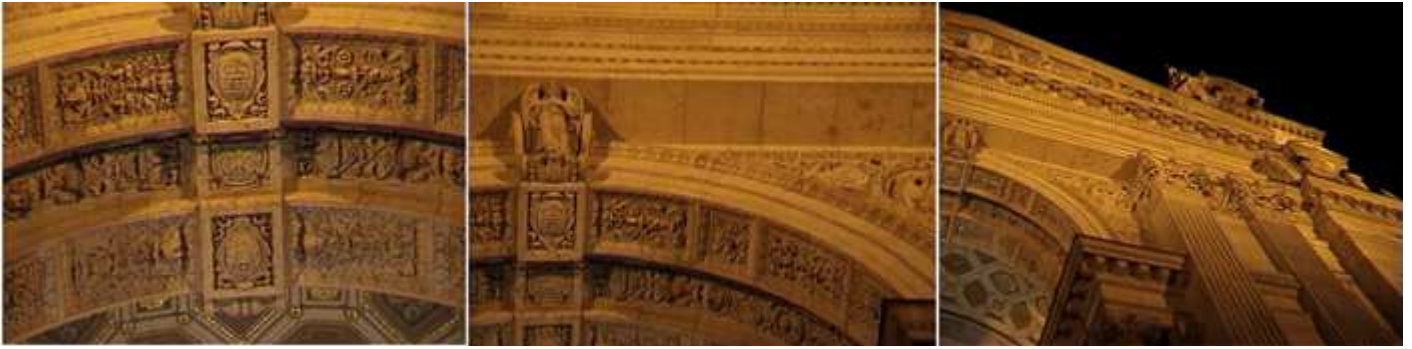
❶ En el intradós de los arcos de su portada principal con diversos relieves y los escudos eclesiásticos. ❷ En el frontal de la clave una figura de un ángel. ❸ Detalle de las columnas y capiteles de la fachada principal.
