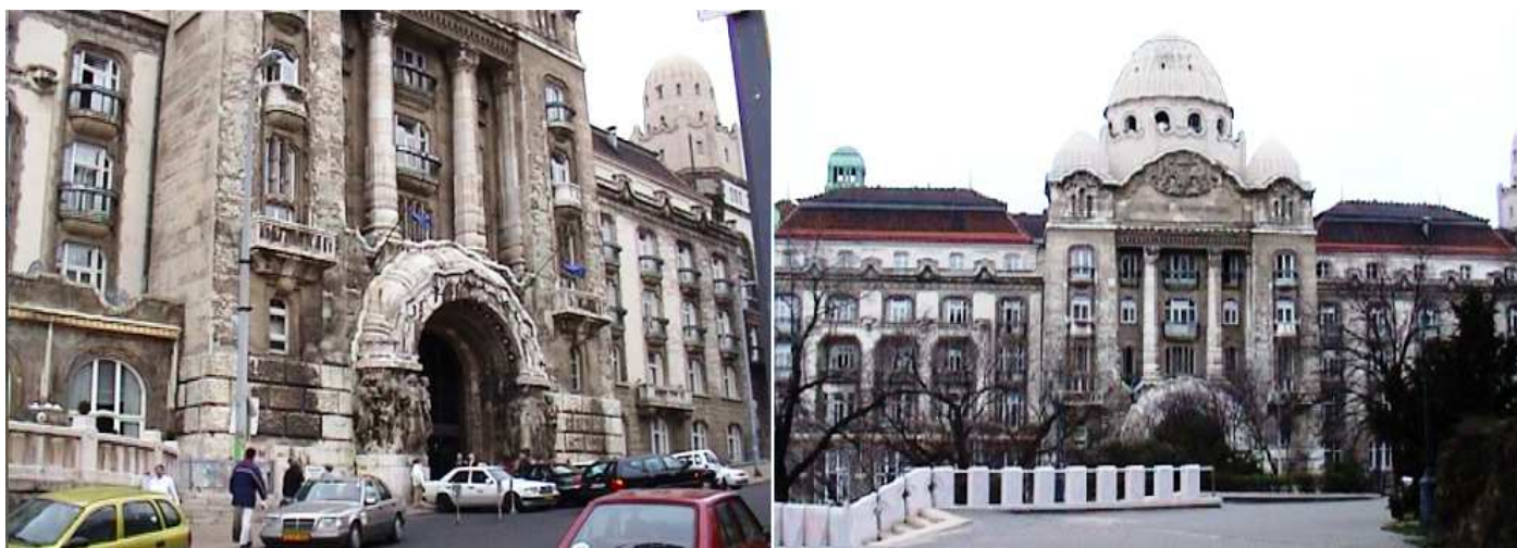
❶ La parte superior cuenta con un pórtico con cuatro gigantescas columnas. ❷ El edificio desde la iglesia Cueva del Monte Gellért.
