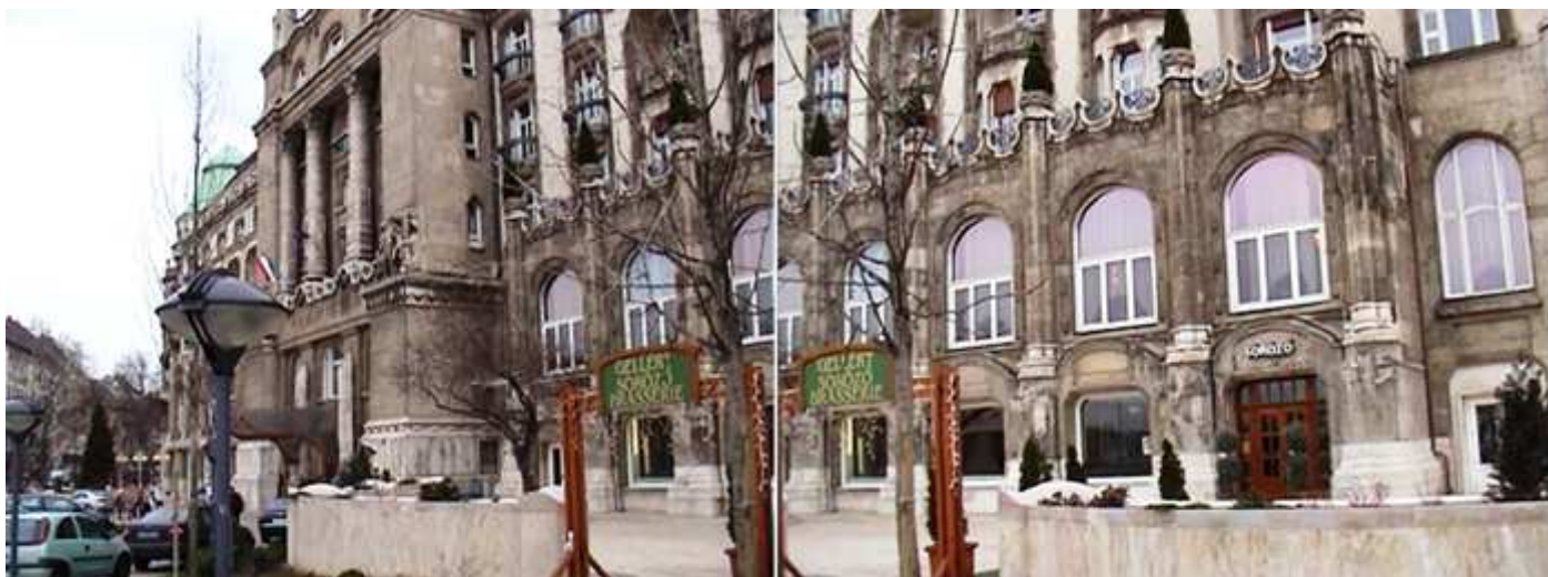
❶ En la fachada principal entrada a la brasería Gellért Sökorózo. ❷ Fachada con numerosos elementos decorativos.
