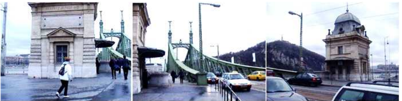
❶ En la orilla donde se encuentra el Mercado Central y la Universidad Corvinus, posee dos edificaciones a cada lado de la entrada del puente. ❷ La estructura de hierro necesaria fue realizada por la Fábrica de Máquinas de los Ferrocarriles Estatales Húngaros. ❸ En estas construcciones llevan una inscripción de Ferencz József como fue conocido durante algún tiempo este puente.
