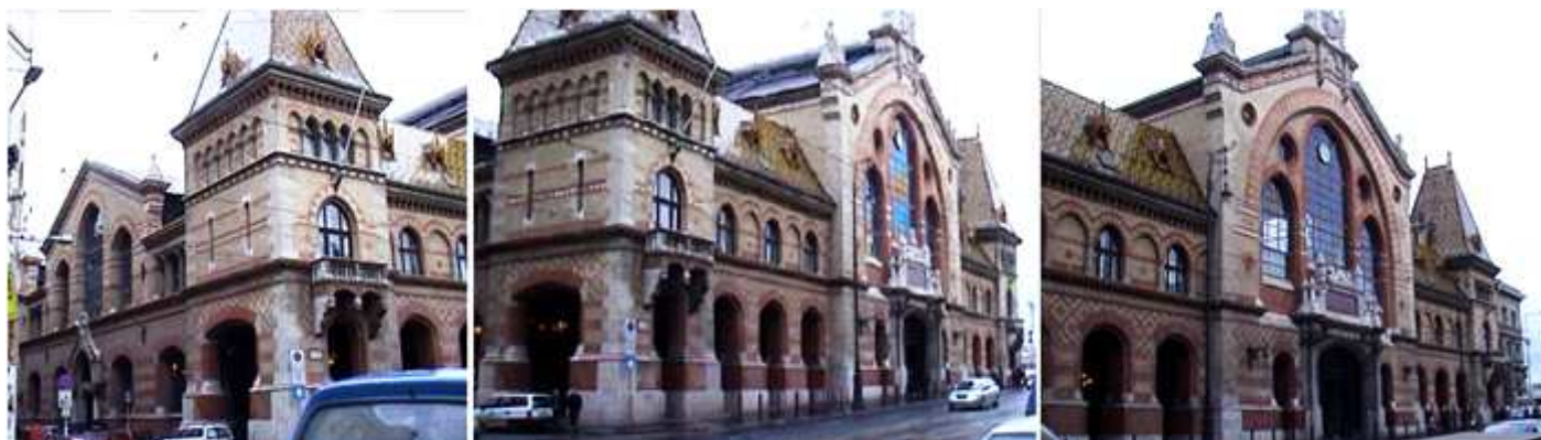
1 Atractiva decoración de la construcción realizada en ladrillo. 2 Tanto las cúpulas piramidales como los tejados de las alas laterales de esta fachada tienen cerámica vidriada con dibujo en zigzag. 3 Cuerpo central de la fachada.
