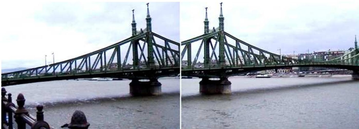
❶ - ❷ Montaje de la estructura metálica de sus arcadas.
