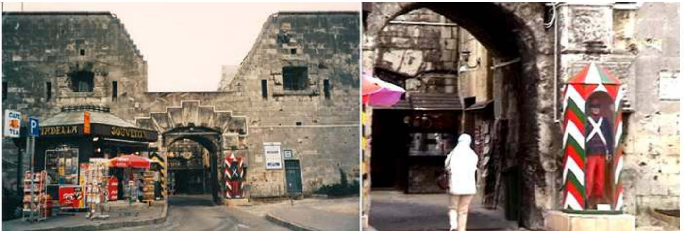
1 Entrada a la Ciudadela. La fortaleza fue construida en 1851 por Julius Jacob von Haynau. Con trabajadores forzosos húngaros. 2 Accedemos a su interior. Actualmente ya han retirado la garita del vigilante.
