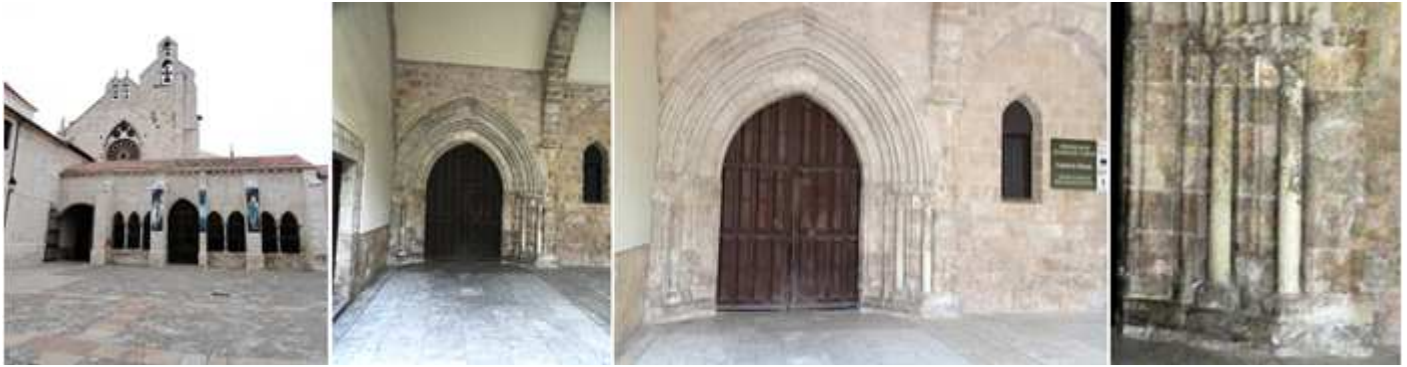
1 Sobre el patio se observa la fachada de la iglesia con un gran rosetón gótico y las espadaña con dos vanos para las campanas. 2 En el interior del patio la puerta del templo de arco apuntado. 3 Puerta con tres arquivoltas baquetonadas. 4 Detalle de sus columnas y capiteles corridos.
