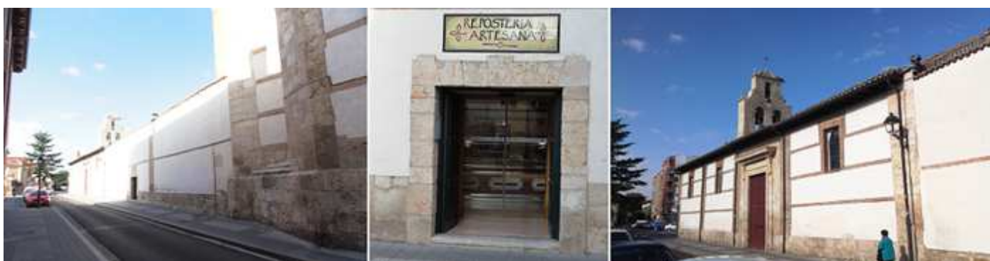
❶ Lateral del monasterio a la calle Hermanos Madrid. ❷ Tienda con la venta de repostería y recuerdos. ❸ Al final de la calle con la Plaza de Juan XXII la iglesia de Santa Marina con una puerta adintelada y la espadaña de tres vanos.
