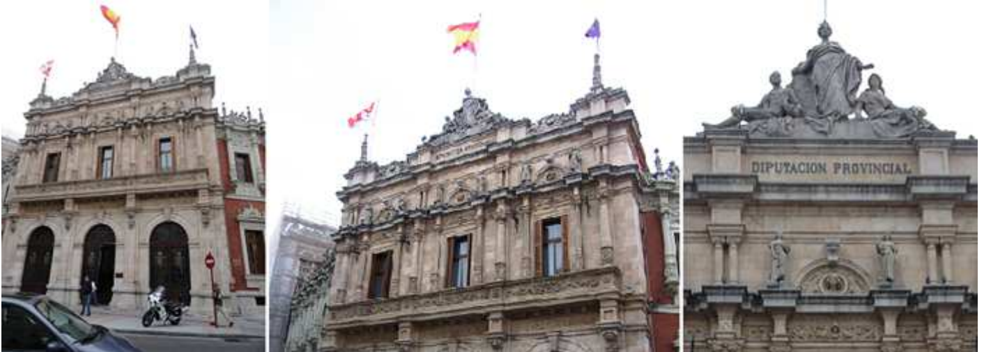
❶ Fachada principal con tres arcos de medio punto en la planta baja. ❷ Y un gran balcón de piedra en la planta noble. ❸ Coronamiento con el grupo escultórico de tres personas que sostienen el escudo de la ciudad.
