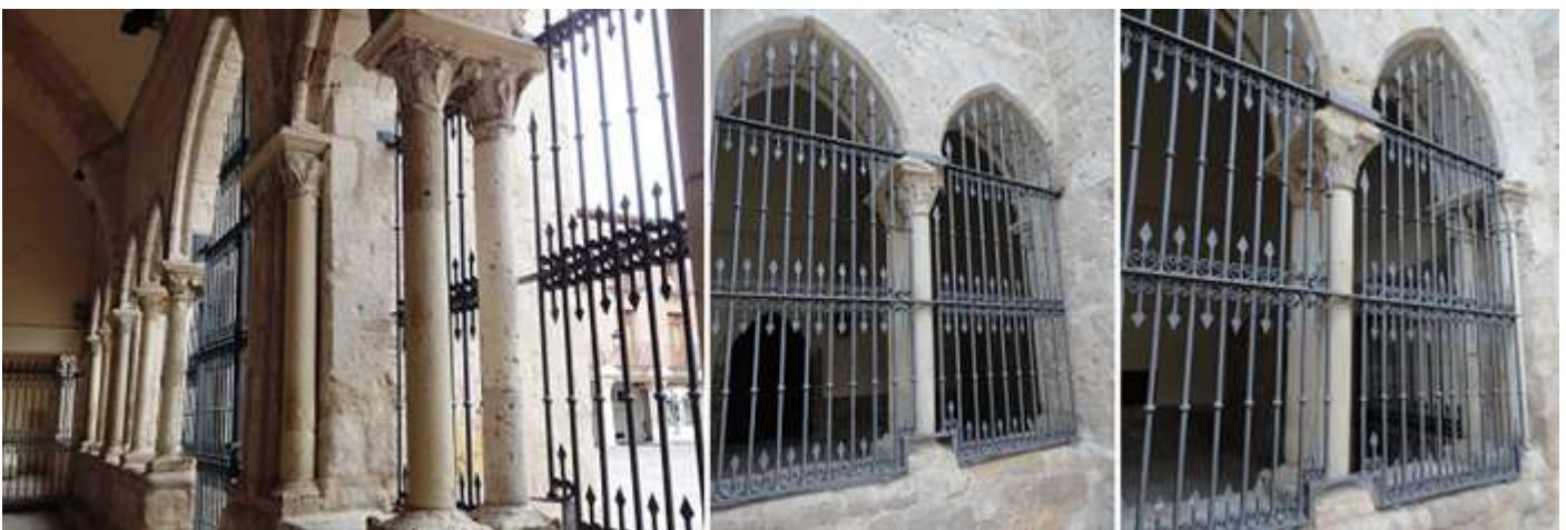
1 La arquería se compone de ventanales de arcos apuntados con columnas geminadas. 2 Los arcos del pórtico cerrados con rejas. 3 Y sus capiteles con decoración vegetal.
