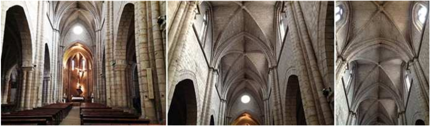
❶ Nave con una altura notable. ❷ Perfectamente iluminada con sus ventanales apuntados. ❸ Con bóveda de crucería.
