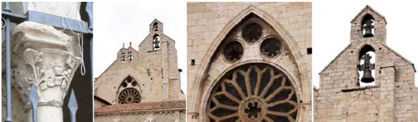
1 Uno de los capiteles del pórtico con decoración de hojas vegetales. 2 En el hastial del templo hay dos campaniles. 3 Detalle del rosetón dentro de un arco apuntado y tres óculos conteniendo otros más pequeños polilobulados. Todo de imitación gótica del S. XIX. 4 Espadaña de la derecha.
