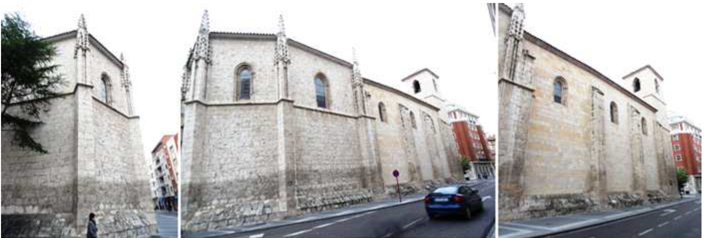
❶ Cabecera con contrafuertes culminados por pináculos. ❷ Cabecera con un amplio presbiterio. ❸ Lateral del Evangelio a la calle Burgos.
