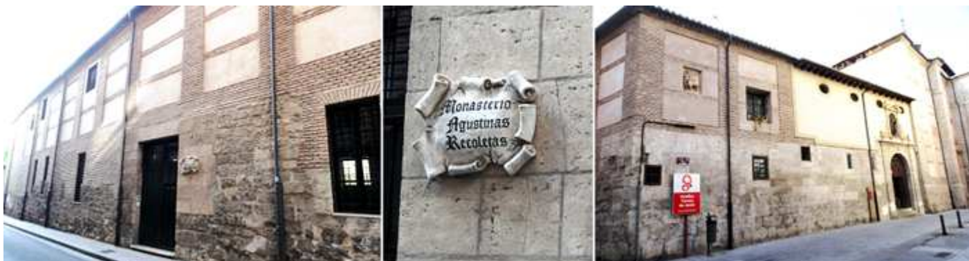
❶ Edificio construido en cantería y ladrillo lateral de la calle Gil de Fuentes. ❷ Relieve de su puerta de entrada. ❸ Fachada con la entrada en el templo por la calle Jorge Ramírez, que encontramos cerrado. En esta fachada en el ángulo superior izquierdo hay un relieve de San Martín.
