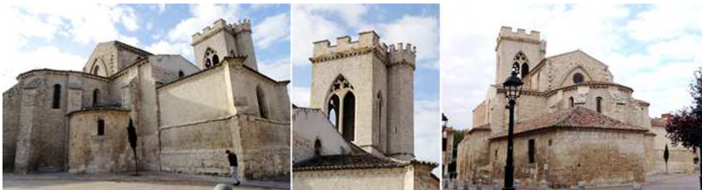
1 Cabecera del templo. 2 Detalle del ventanal ajimezado de arco apuntado con finos maineles y tracería calada y la coronación de la torre con almenas. 3 Otra imagen de su ábside románico concluido a finales del S. XII tapado en parte con una construcción posterior.
