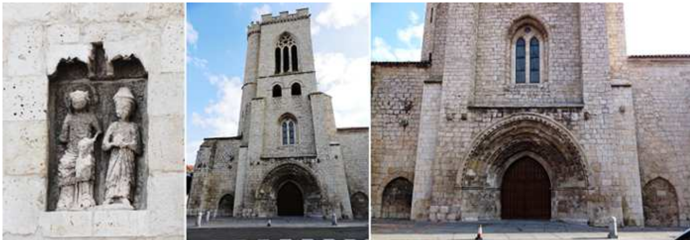
❶ Bajo relieve en el contrafuerte del ángulo derecho de la fachada de la Virgen con el Niño y un personaje. ❷ Su torre con contrafuertes y abierta en sus dos cuerpos superiores con ventanas y coronada con almenas. ❸ Bajo la torre su portada principal gótica con seis arquivoltas. Y dos puertas cegadas ¿? A las naves laterales.
