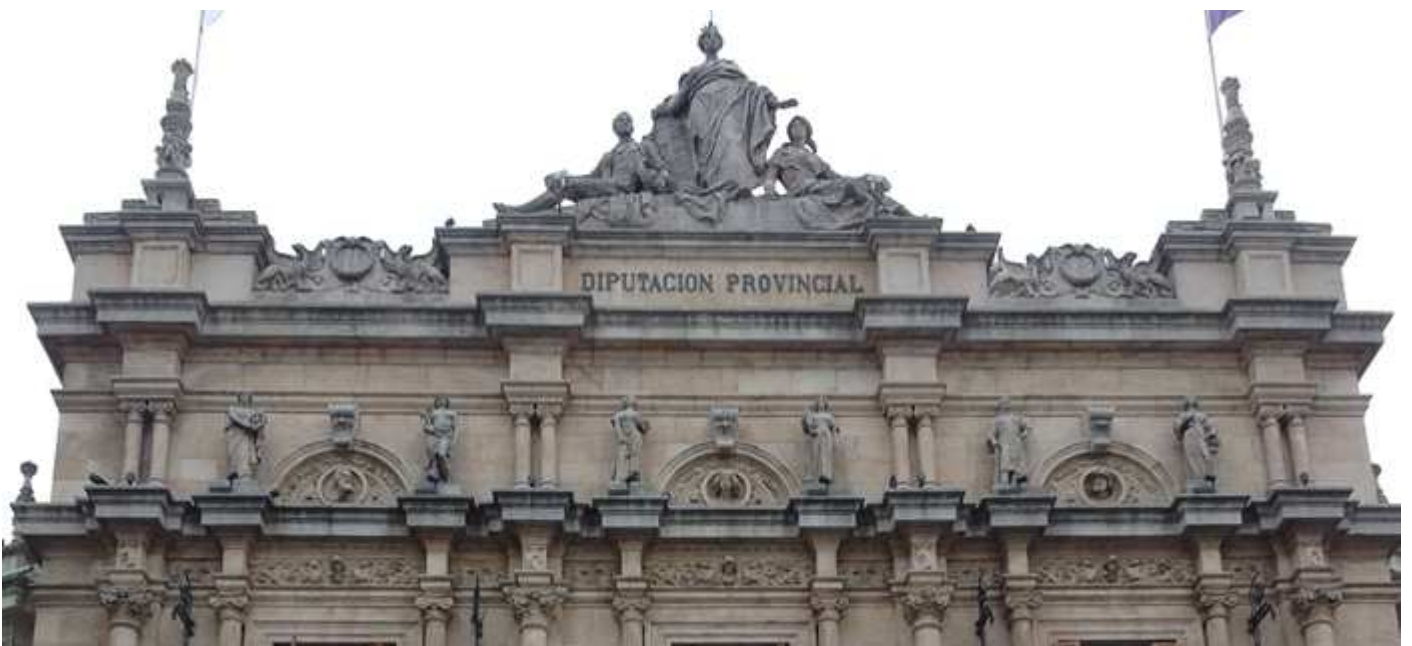
❹ Sobre los tres ventanales de su planta noble una cornisa donde por parejas se sitúan unas estatuas sobre las ventanas y un entablamento que corona edificio con sendos pináculos en las esquinas.
