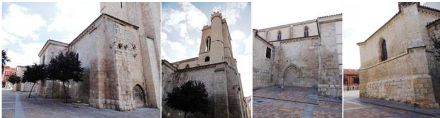
1 Lateral exterior del lado del Evangelio. 2 Vista de la torre por este lado. 3 Puerta apuntada cegada en este lado del Evangelio con dos arquivoltas sobre impostas corridas. 4 Lateral que se prolonga en este lado del crucero.
