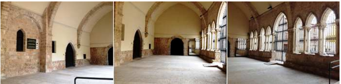
1 Interior del pórtico, la pared junto al templo. 2 Desde el pórtico se accede a las capillas: de la Tercera Orden Franciscana y otra que sus bóvedas y muros ostentan un revestimiento de calaveras y huesos cruzados. 3 Lateral del pórtico que está dotado con dos puertas y dos tramos de dos ventanas y uno de tres.
