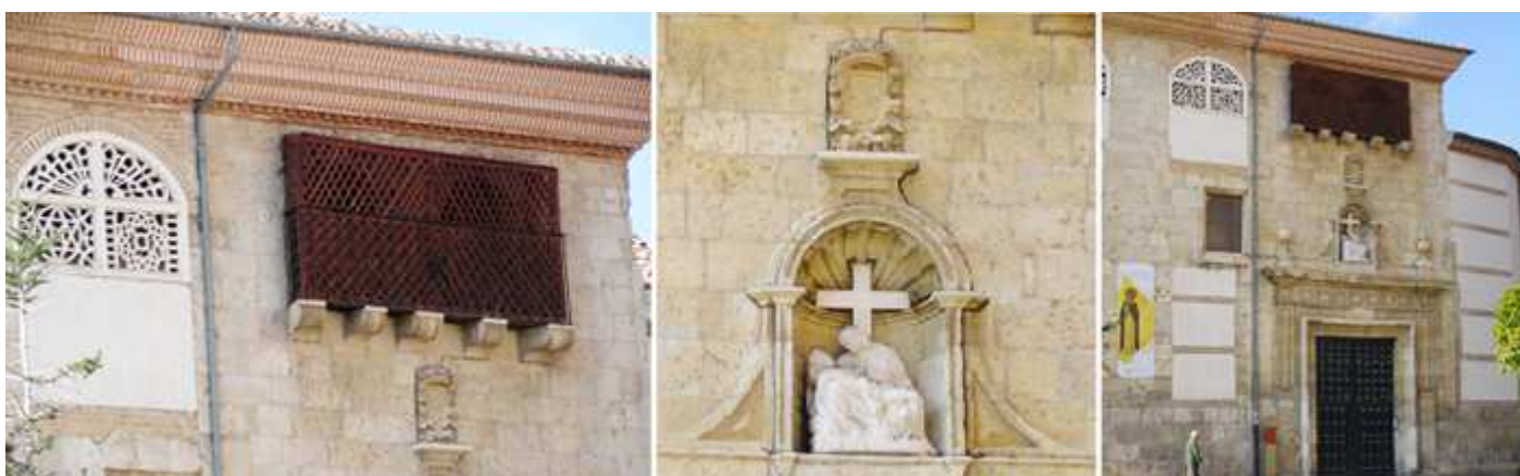
❶ Una de las celosías de obra junto a otra realizada en madera. ❷ Sobre la puerta esta hornacina con una Cruz y la escena de La Piedad. ❸ Puerta dintelada de entrada al templo
