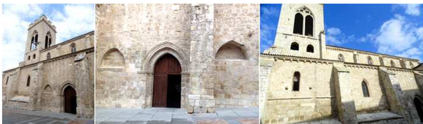
❶ Puerta del lado Epistolar. ❷ De arco apuntado con una arquivolta. ❸ Fachada a la Plaza de San Miguel.
