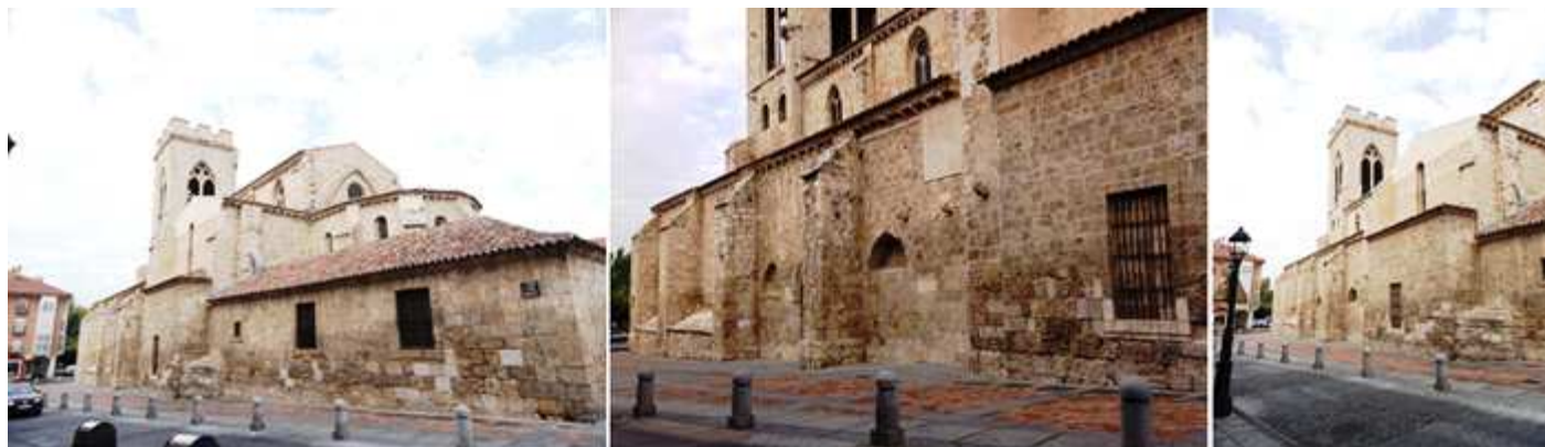
❶ El lateral exterior de la Epístola. ❷ Sobre sus muros varios arcosolios entre los contrafuertes. ❸ Destaca su alta torre de 70m.
