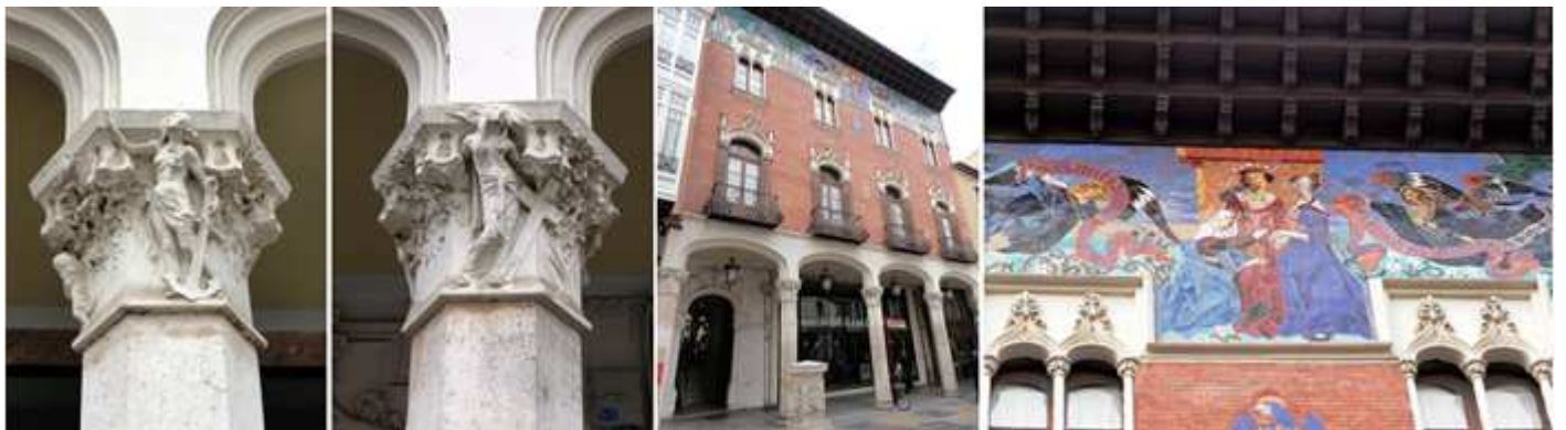
❶ - ❷ Además de los escudos de Villandrando están las tres virtudes teologales en los mismos. ❸ Consta de tres pisos. ❹ El último piso con las ventanas geminadas y el gran friso de Daniel Zuloaga que representa la donación de la fundadora del asilo.
