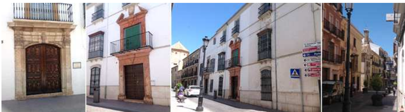
❶ Dispone de una portada barroca de esta vivienda con un patio rectangular y galerías con columnillas de fundición. ❷ Otra casa en el nº 7 de esta calle. Con portada de dos cuerpos. ❸ Los balcones y ventadas de su fachada cerrados con rejas. ❹ Bocacalle del Agua con la Ermita de Dios Padre. Edificada en 1718 bajo el patrocinio de la familia Bruna y Ahumada. En su interior el conjunto escultórico del Sagrado Lavatorio se le atribuye a Pedro Mena.
