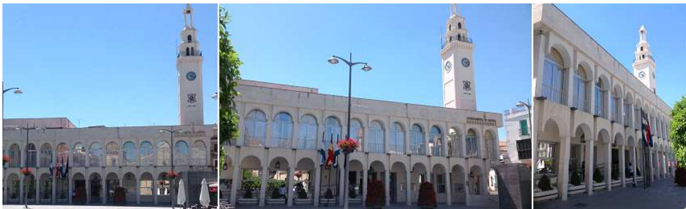
❶ Edificio de dos plantas con una fachada a base de arcos de medio punto. ❷ Siendo la parte baja un porche transitable. ❸ En la parte derecha de su fachada se levanta la torre de planta cuadrada
