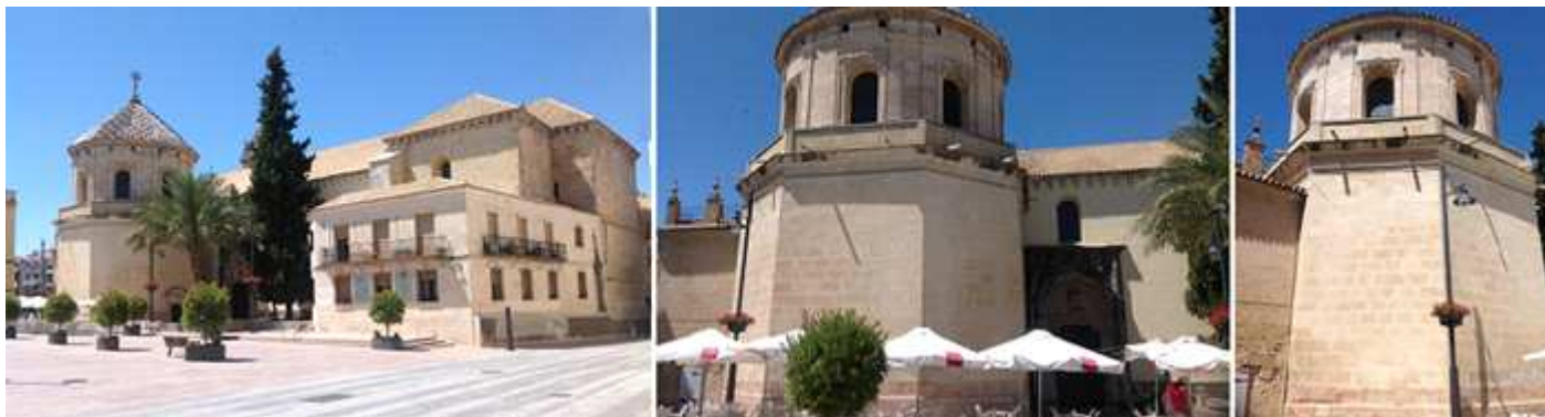
① Lateral epistolar del templo a la plaza de San Miguel ② En este lateral sobresale del templo la capilla ochavada del Sagrario. ③ Cuya parte superior de planta octogona pasa a redonda con ventanas de medio punto.
