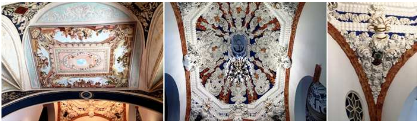
❶ Decoración bóveda del hall de las escaleras. ❷ Con una cúpula octogonal donde proliferan las yeserías con fondos decorados. ❸ Lo mismo que sus pechinas.
