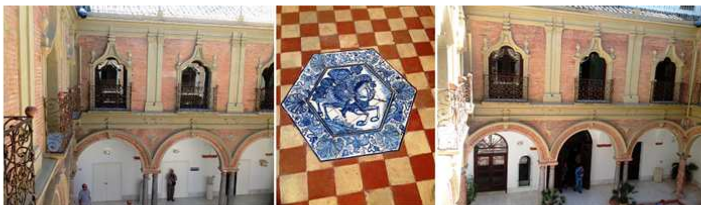
❶ Detalle de uno de sus ángulos. ❷ Detalle de la cerámica de los suelos en una sala de esta primera planta. ❸ Cada paño de los balcones realizado en ladrillo rojo y con pares de columnas adosadas.
