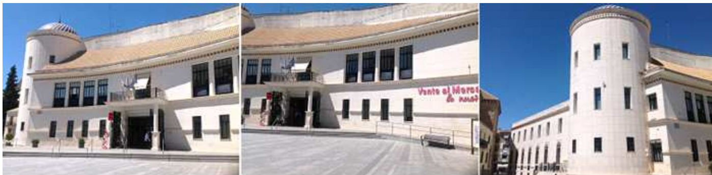
① Fachada a la plaza Archidona con un torreón en su esquina. ② Parte central de la fachada y una de sus entradas. ③ Torreón de tres plantas con servicios oficiales.
