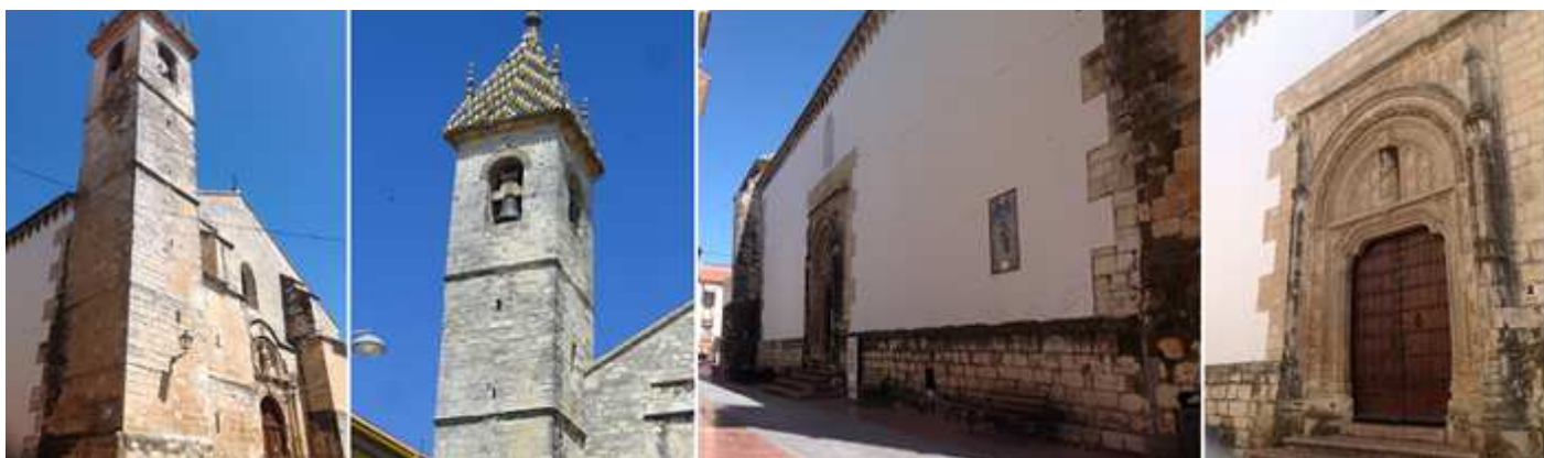
❶ En este ángulo su torre de planta cuadrada de tres cuerpos separados por impostas corridas ❷ Cubierta con un chapiteo piramidal con tejas de colores. ❸ Lateral exterior del Evangelio. ❹ Con la portada de la Virgen en este lado norte, de 1498.
