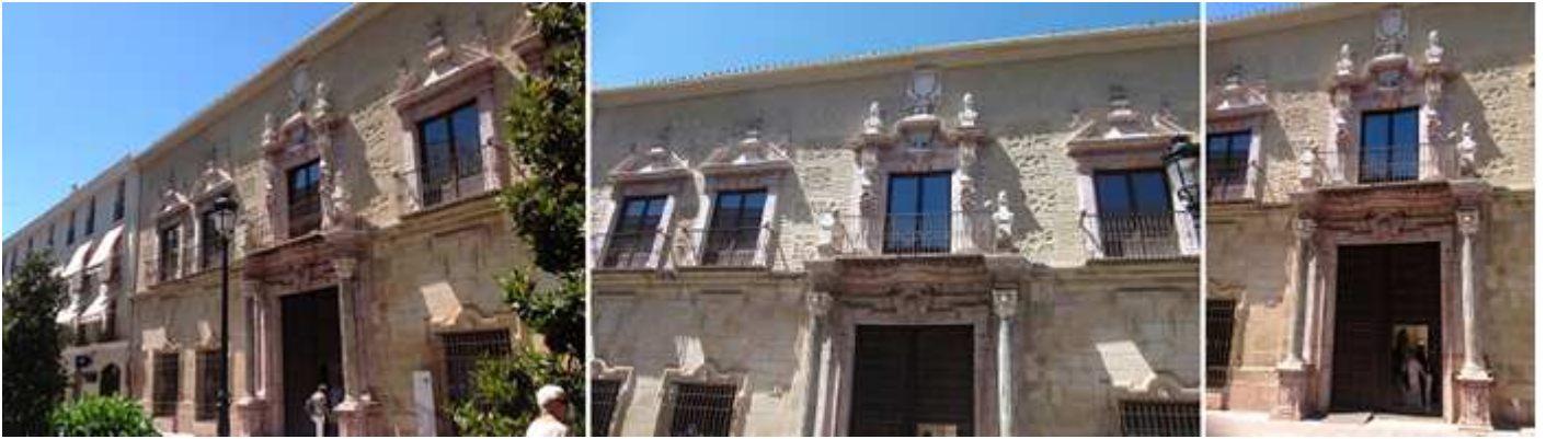
❶ Casa palacio de dos alturas. ❷ Construida con líneas de ladrillo y cantería, más la piedra en los elementos decorativos de puertas y ventanas. ❸ Con una portada de dos cuerpos.
