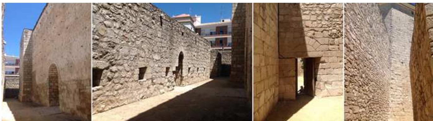
❶ Muro interior del castillo en el que también se uso el tapial. ❷ Detalle del foso en el lado nordeste con los espacios adintelados de sus ventanas saeteras y la puerta de este lado. ❸ Otra pequeña muerte en sus muros. ❹ La anchura del foso es irregular siendo esta parte una de las más estrechas.
