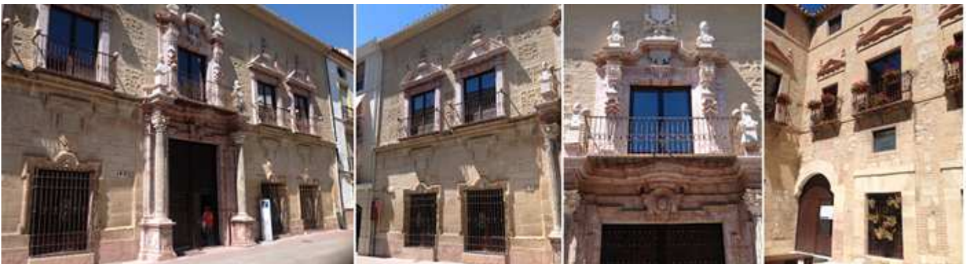
❶ Su puerta adintelada con dos columnas sobre pódium. ❷ Lateral izquierdo de la fachada con sus ventanas cerradas con rejas y sobre las mismas, balcones enmarcados con columnas y con frontis triangulares abiertos. ❸ Sobre su puerta adintelada un balcón sumamente decorado con columnas con pináculos sobre el que ostenta el escudo nobiliario. ❹ Entramos al primer patio, rincón del mismo con una de las puertas de este ángulo.
