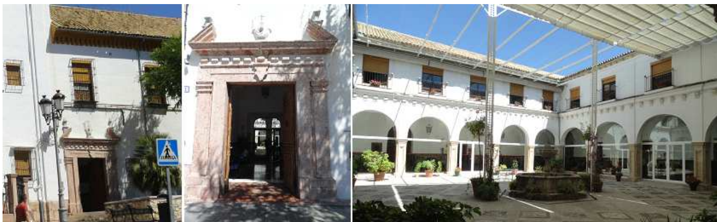
❹ Colindante con el templo tiene la entrada el Hospital. ❺ Con una puerta adintelada con dos columnas rectas a sus lados y sobre el entablamento un frontis abierto con el escudo de la orden hospitalaria. ❻ El antiguo claustro del Hospital de dos plantas con galerías con arcos de medio punto, sobre pilares cuadrados con pilastras del orden toscano y con bóvedas de arista, que actualmente están cerradas por cristales. Y la planta superior abierta con ventanas.
