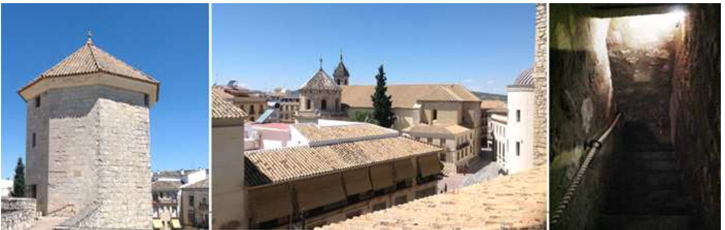
❶ Aspecto de la torre en el paso de ronda. ❷ Vista de la ciudad hacia la iglesia de San Mateo. ❸ Interior de una de sus escaleras.
