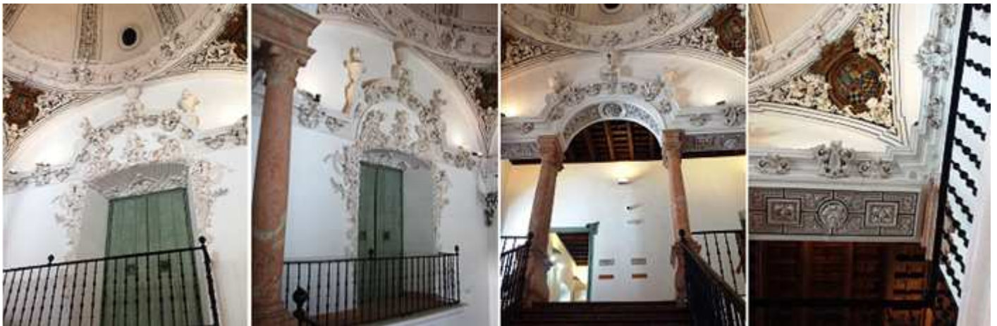
1 Lateral opuesto del hueco de la escalera con una galería volada. 2 Que da acceso a las habitaciones de este lado 3 Detalle del arco en el último tramos de la escalera. 4 Una de las pechinas.
