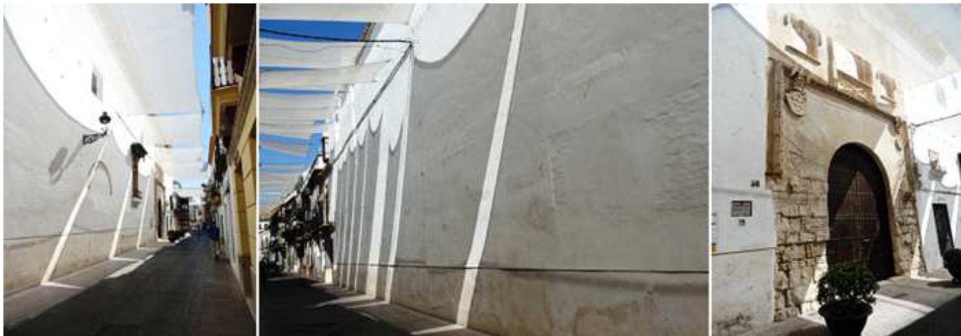
❶ Lateral de este palacio convertido en convento. ❷ Sin espacios abiertos a esta calle del Conde. ❸ Y la puerta de piedra sillar.
