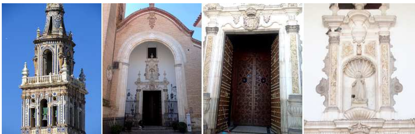
1 Los dos últimos cuerpos de la torre campanario. 2 Su portada barroca cobijada en este amplio arco de dos cuerpos diseñada por Antonio Matías. 3 El inferior con vano adintelado y a los lados pilastras sobre pedestales. Y se cierra con una puerta de caoba con clavos de bronce. 4 Y en el superior una hornacina avenerada con la talla de la Asunción.
