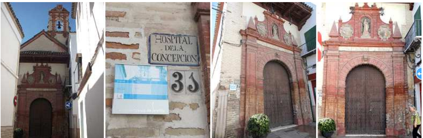
❶ El hastial del templo culminado con un frontis triangular y a su derecha una espadaña. ❷ Portada de estilo manierista en ladrillo. ❸ Bajo el entablamento se encuentra la fecha alusiva a la construcción hospitalaria.
