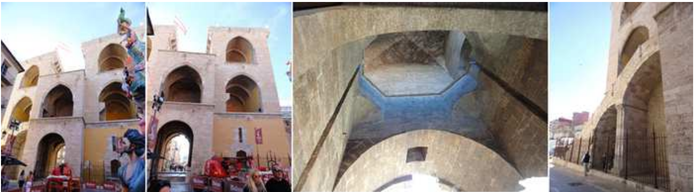
❶ parte interior con los tres pisos abiertos abovedados. ❷ m. ❸ Bóveda del espacio central de la puerta. ❹ Lateral con la escalera de acceso a las plantas superiores.
