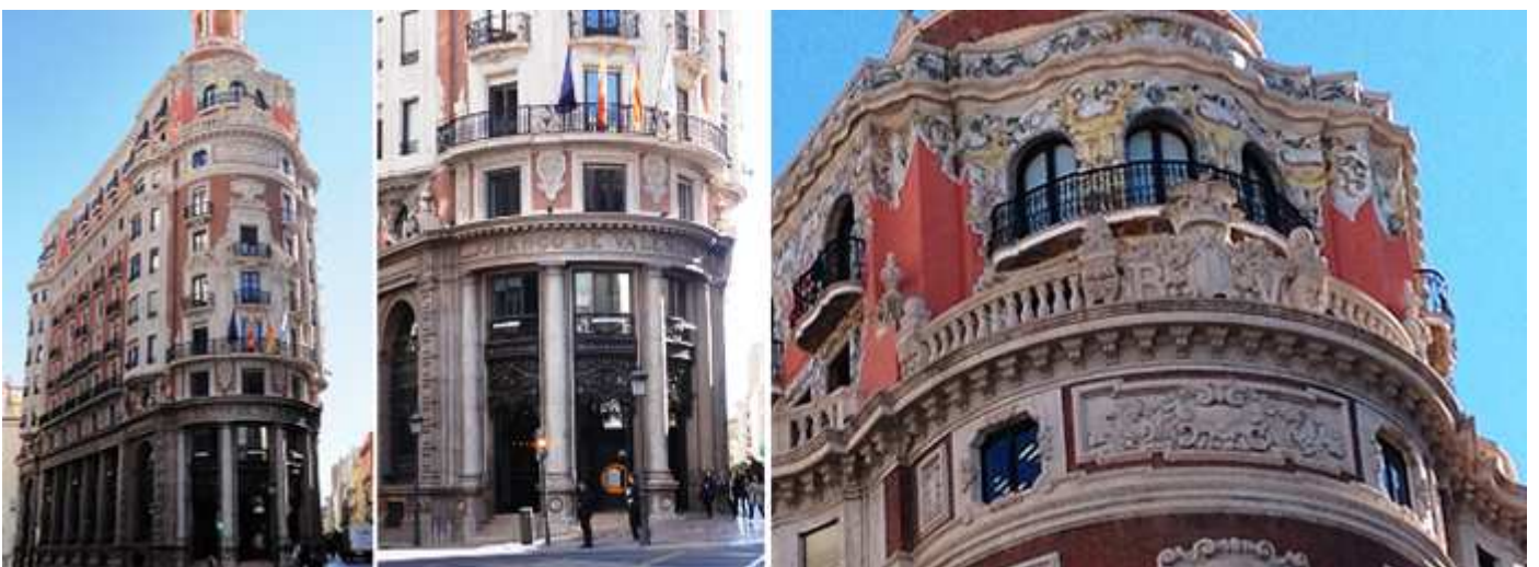
❶ El edificio con la parte curvada de su chaflán. ❷ La base del edificio dispone de dos alturas dotada con columnas. ❸ Parte superior del chaflán con una terraza con balaustrada con el escudo de la ciudad. Este cuerpo está decorado con fondo rojo y elementos de decoración en su parte superior. Remata un templete el edificio.
