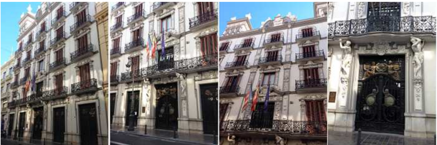
❶ Este edificio de cuatro plantas más los torreones se construyó entre 1883 y 1887. ❷ Fachada de inspiración barroca dotada de balcones. ❸ Su fachada, balcones y frontis contienen decoración vegetal, y en la parte central superior destaca el escudo de España. ❹ Portada que su espacio adintelado cuenta con una verja con dos hojas que su forja mantiene elementos decorativos y a sus lados dos esculturas masculina y femenina parecen sostener el balcón alojado encima
