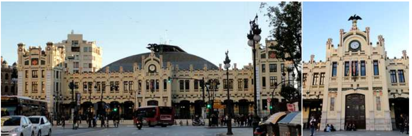
❶ Fachada de la estación ante la avenida del Marqués de Sotelo y la calle Játiva. ❷ Cuerpo central de la fachada.
