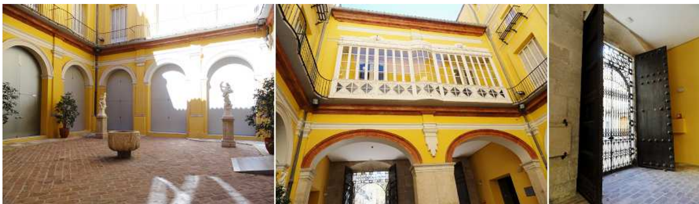
❶ El pario rodeado de arcadas de medio punto que actualmente están cegadas y que posee sendas esculturas en sus ángulos. ❷ Galería sobre el pórtico. ❸ Detalle de las verjas de las puertas.
