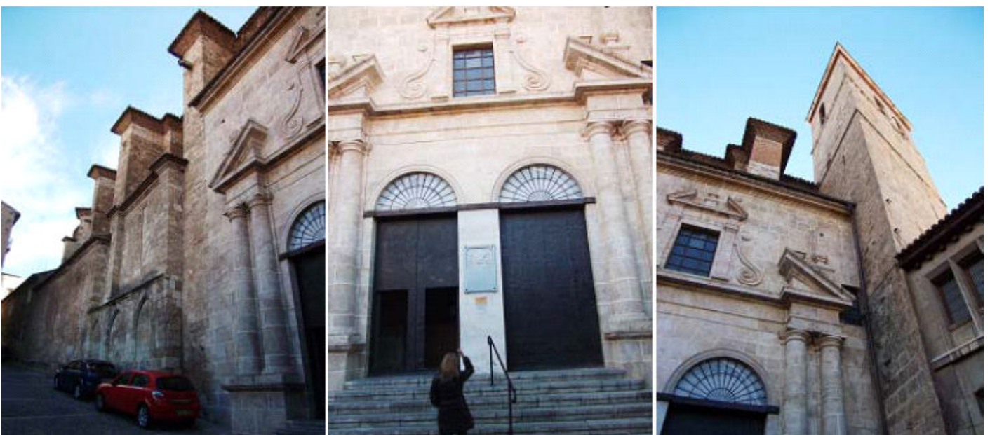
1 Fachada de la Catedral. 2 Portada principal con la solución óptica de dos puertas cuando la derecha está invalidada por el contrafuerte. 3 Con tu torre trapezoidal.
