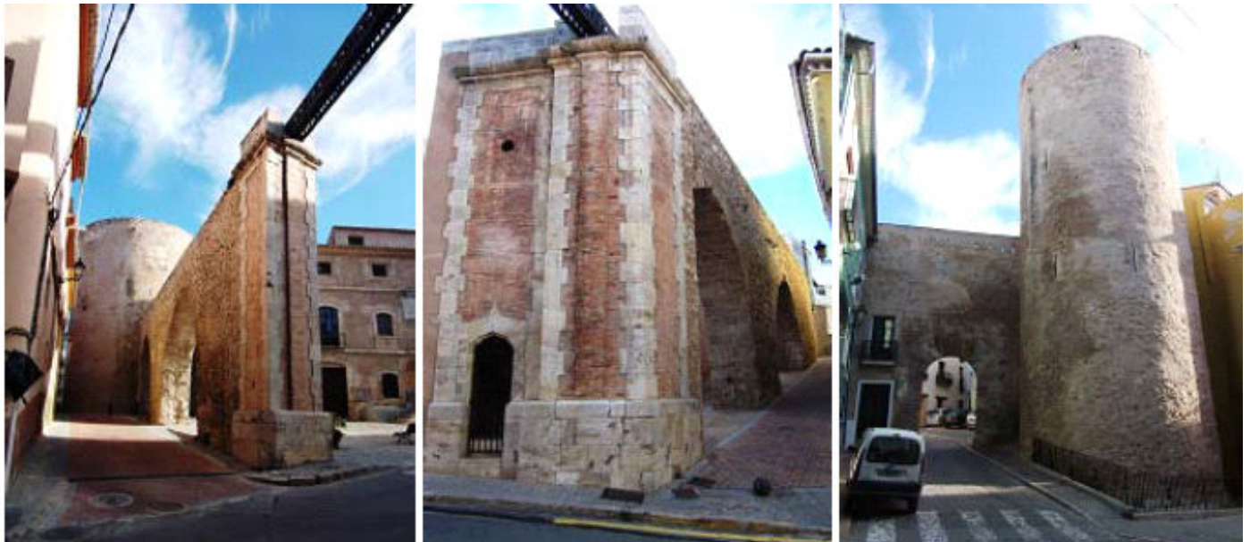
❶ La torre de la Cárcel y el Acueducto musulmán. ❷ Vista de otro tramo. Esta construida con piedra sillar y ladrillo. ❸ Puerta y Torre del Verdugo.
