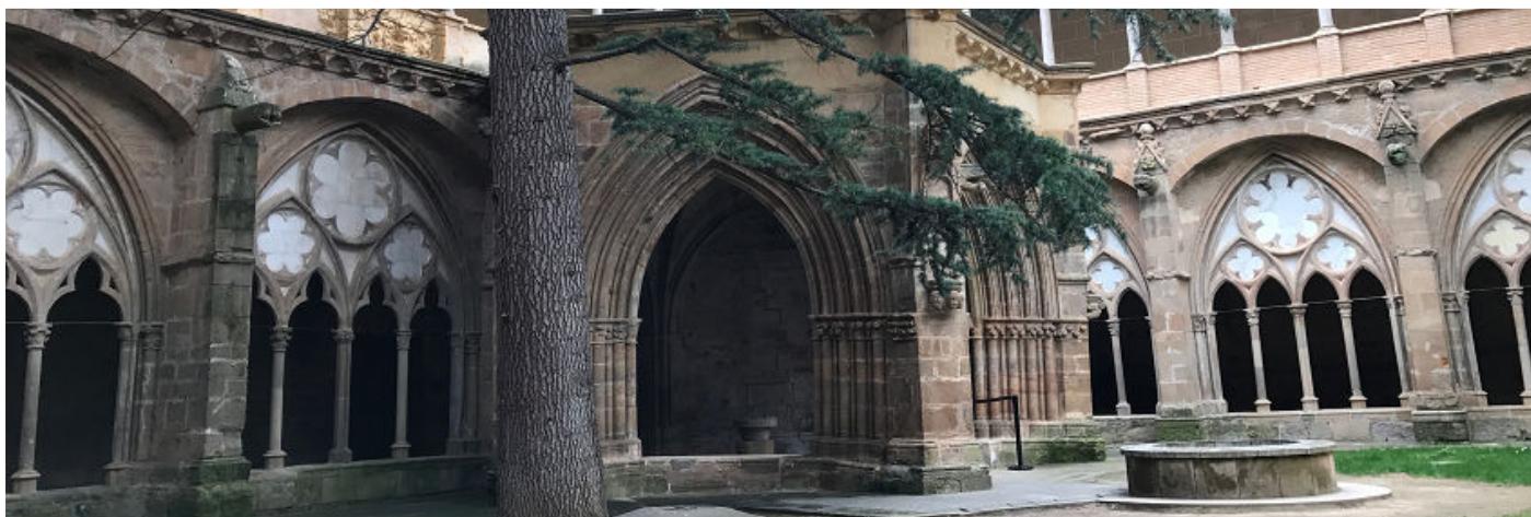
❶ Rincón del claustro con el lavatorio.
