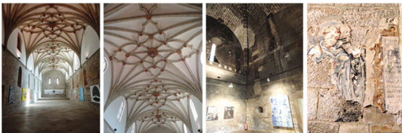
❶ Refectorio S. XIII, remodelado en 1548, gótico y renacimiento. ❷ Bóveda del mismo ❸ Cocina mediados del S. XIII, gótico. ❹ Galería de los abades, pintura mural renacimiento 1600.
