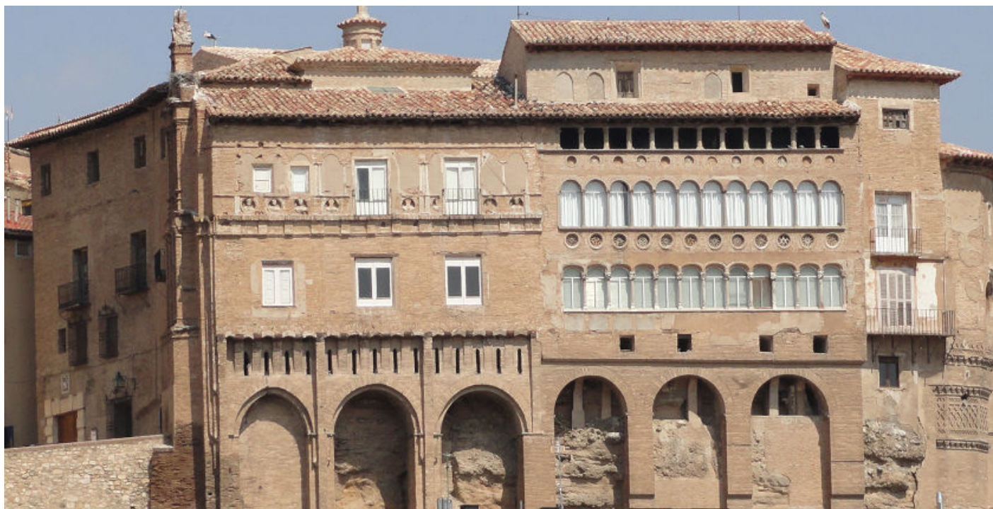
📍 La fachada más característica es la del sur, con sus arcadas de cimentación y la triple galería de arquillos, tan aragonesa.
