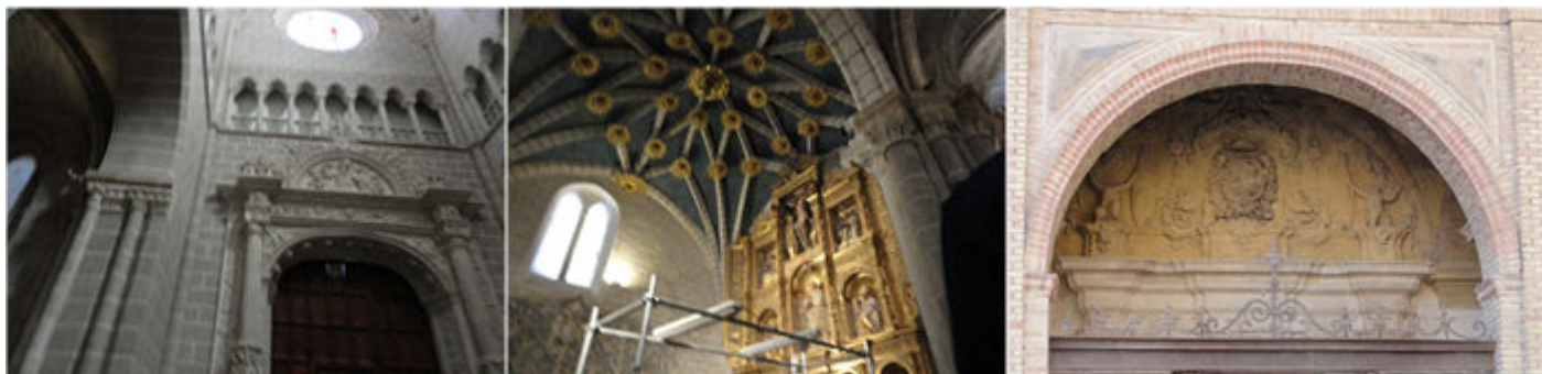
1 Detalle de la puerta que da al claustro. 2 Cúpula de la capilla de la Purificación. 3 Pórtico pequeño en la fachada.
