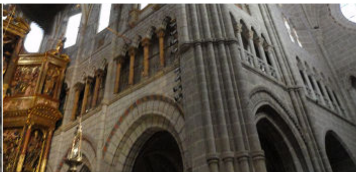
2 Detalle de la galería de arquivoltas y sus columnas del crucero.
