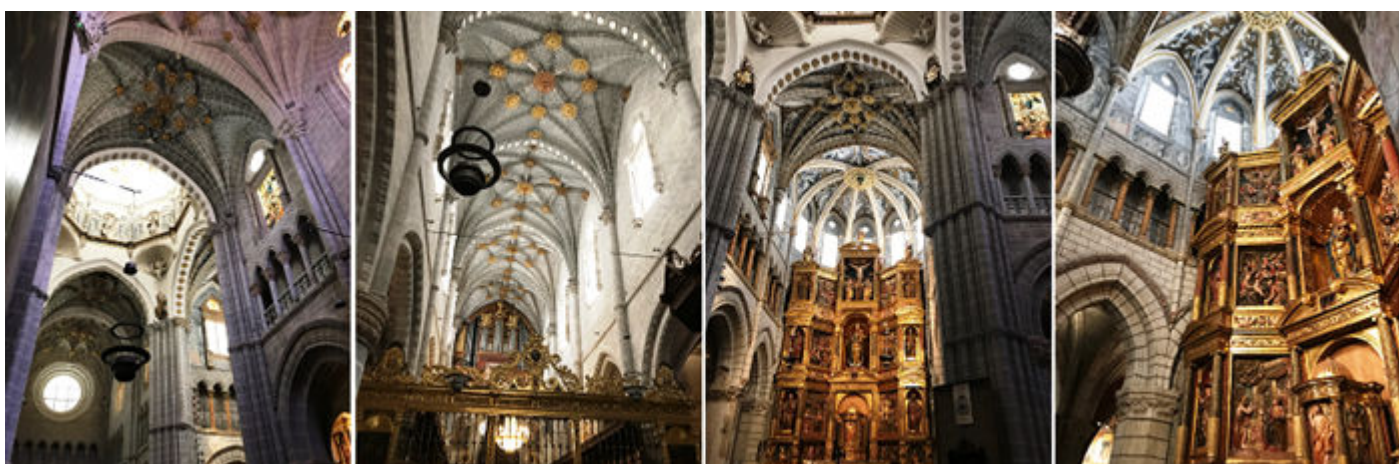
1 Imagen de sus bóvedas desde la nave central. 2 Las bóvedas de crucería estrellada sobre la parte del coro que dispone de una sillería gótica del S. XV. 3 La cabecera vista desde el crucero. 4 Vista lateral de la capilla Mayor con el retablo y parte de la galería que la rodea.
