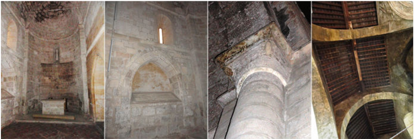
1 - 2 - 3 Imágenes de la zona del ábside románico y sus columnas. 4 Detalle de la techumbre de madera de la nave del Evangelio.
