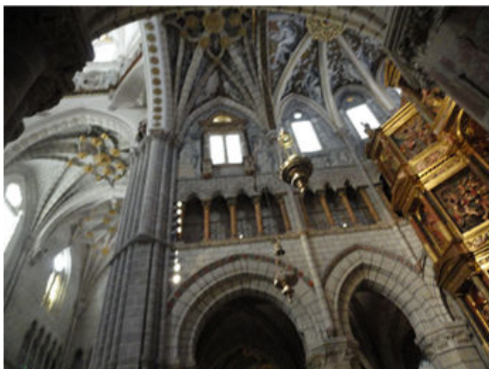
3 Detalle del ábside junto al altar Mayor.
