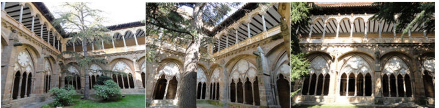
1 - 2 - 3 Claustro donde apreciamos los dos pisos del mismo con sus ventanas de arco apuntado en la galería inferior y de medio punto en la superior.
