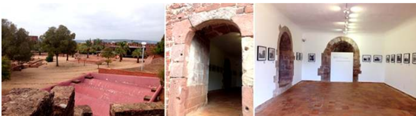
1 Las bóvedas del aljibe principal. 2 Puerta de acceso a uno de los torreones. 3 Donde se encuentra una exposición fotográfica.
