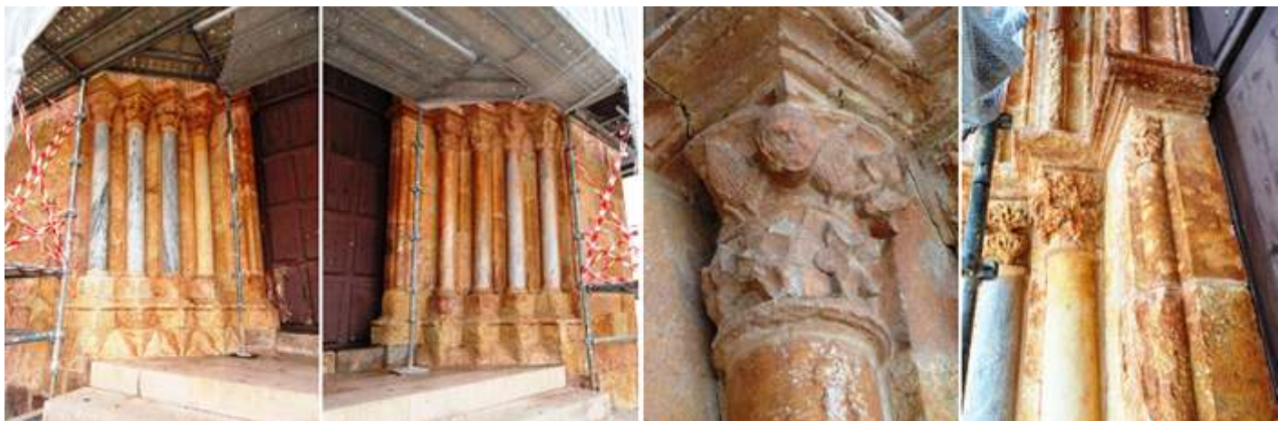
❶ Lateral izquierdo de la portada. ❷ Y su lado derecho. ❸ Capitel con una cara y dos piñas a sus lados. ❹ Capiteles y jamba del lado izquierdo decorados con hojas.
