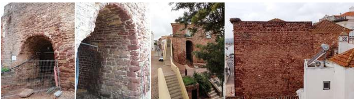
❶ Puerta que tiene en su vertical la rúa de la catedral. ❷ Otra instantánea de la puerta actualmente vallada por obras. ❸ Escaleras que bajan de la calle la Puerta de Loulé y de la rúa de la Catedral a la plaza ajardinada. ❹ Estructura de la torre albarrana vista desde el Museo Arqueológico.
