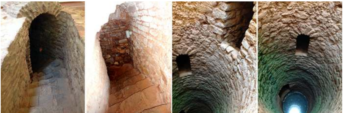
❶ Escaleras que rodean el pozo. ❷ Por las que se accede para tomar el agua. ❸ A lo largo de la escalera hay unas ventanas de medio punto para acceder a sacar el agua. ❹ Según la altura del agua hay que bajar más o menos.
