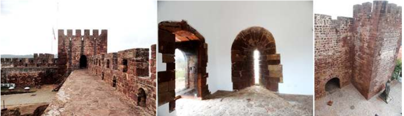
❷ El paseo de ronda hacia el torreón sobre la puerta de entrada. ❸ Interior de la sala superior del torreón. ❹ La puerta vista desde uno de los torreones que la rodean.
