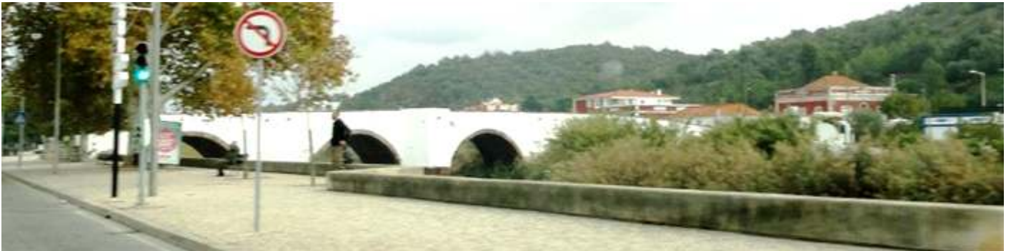
❶ En la avenida que bordea la ribera del rio Arade.
