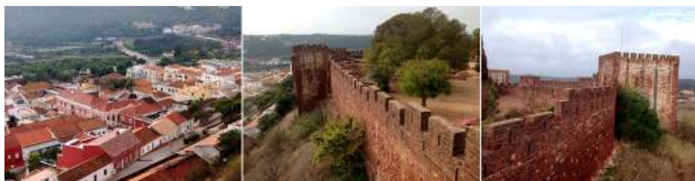
1 Desde cualquier parte de la muralla se divisa a los pies la ciudad. 2 Toda la muralla en este lado dispone de un gran desnivel del terreno. 3 Algunas torres (cuatro) tuvieron alteraciones en los S. XIV y XV y presentan salas abovedadas y puertas góticas. Murallas de la zona norte.
