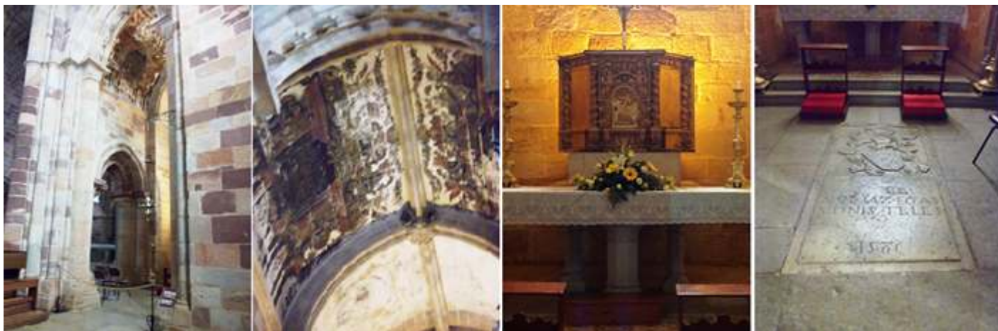
❶ Capilla del Santísimo Sacramento, que se comunica con la capilla Mayor. ❷ Bóveda con restos de pinturas. ❸ Altar con el Sagrario. ❹ Lauda sepulcral de Egas Monis Teles en la parte superior dispone de un escudo heráldico †1581.
