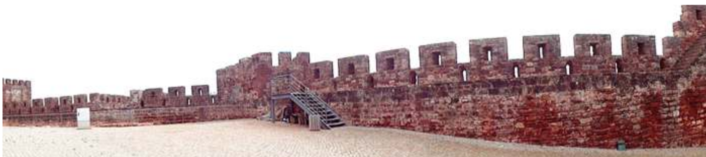
❶ Línea de la muralla con sus almenas abiertas por las aberturas de las saeteras.
