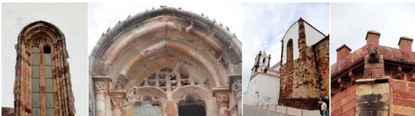
❶ Ventanal de arco apuntado del crucero. ❷ Su interior con dos arcos trilobulados, y una celosía calada cuadrada sobre los mismos. Con dos arquivoltas con capiteles de hojas. ❸ Lateral con el brazo del crucero. ❹ Bajo su alero unos capiteles que conforman arcos cóncavos y en el frontal del contrafuerte la figura de un animal, posiblemente un perro.
