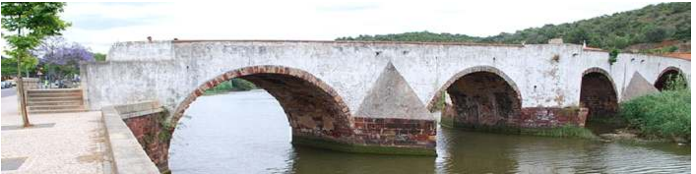
❶ El puente actual tiene cinco arcos entre sus tajamares, a la izquierda existía otro ojo que al realizar la avenida por la que transitamos se eliminó.
