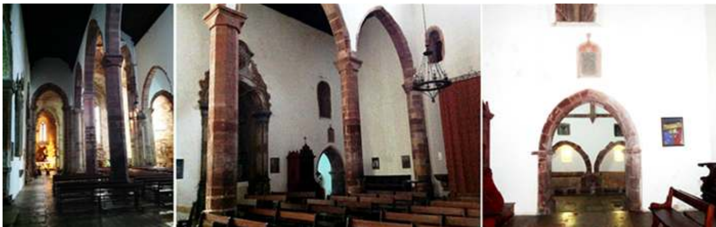
❶ Nave del Evangelio desde los pies del templo, igual que la central cubierta con artesanado de madera. ❷ El lateral de la Epístola con la puerta principal cubierta con un cortinaje. ❸ Capilla funeraria de los Rego.
