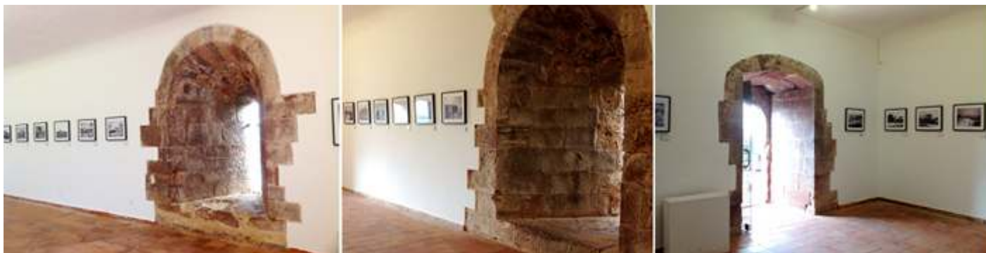
❶ Fotos retrospectivas sobre el castillo. ❷ Su ventana con una gran abocinamiento con derrame interior. ❸ Puerta de acceso a esta sala.
