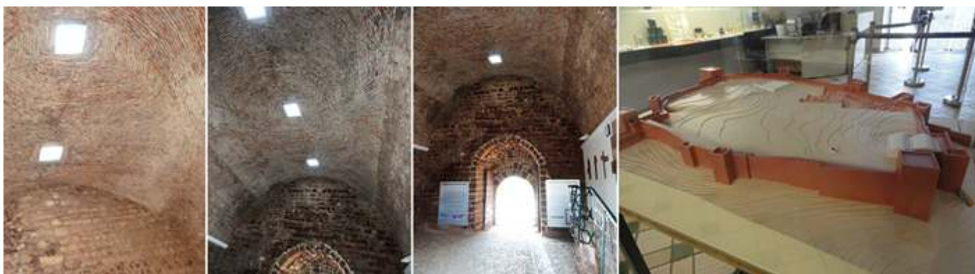
❶ Bóveda con lucernarios en la sala comprendida entre la puerta de entrada exterior y la interior del castillo. ❷ Es una sala muy amplia con bóveda de cañón apuntado. ❸ En el lateral izquierdo según se entra esta la recepción con una pequeña sala expositiva. ❹ Maqueta con el perímetro del castillo donde se aprecia el área excavada, las cisternas y silos que poseía.
