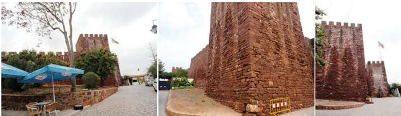
❶ Última rampa de acceso ❷ Una de las esquinas del castillo. ❸ Y al fondo los torreones con la puerta de acceso.
