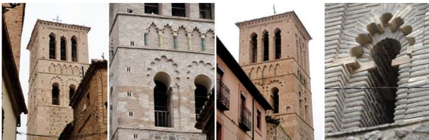
❶ En su interior conserva el manchón central por donde discurren las escaleras. ❷ Su decoración en el segundo cuerpo unos arcos polilobulados acogen las ventanas de arco de herradura, y sobre las mismas hay un friso de arcos ciegos polilobulados que sus fustes con columnillas de cerámica vidriada en verde y ocre. ❸ El último cuerpo es de altas ventanas. ❹ detalle de una ventana.
