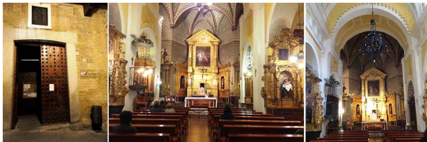
❶ Puerta de entrada. ❷ Nave central y algo más estrechas las laterales. ❸ Cubierta con bóvedas de cañón con lunetos.
