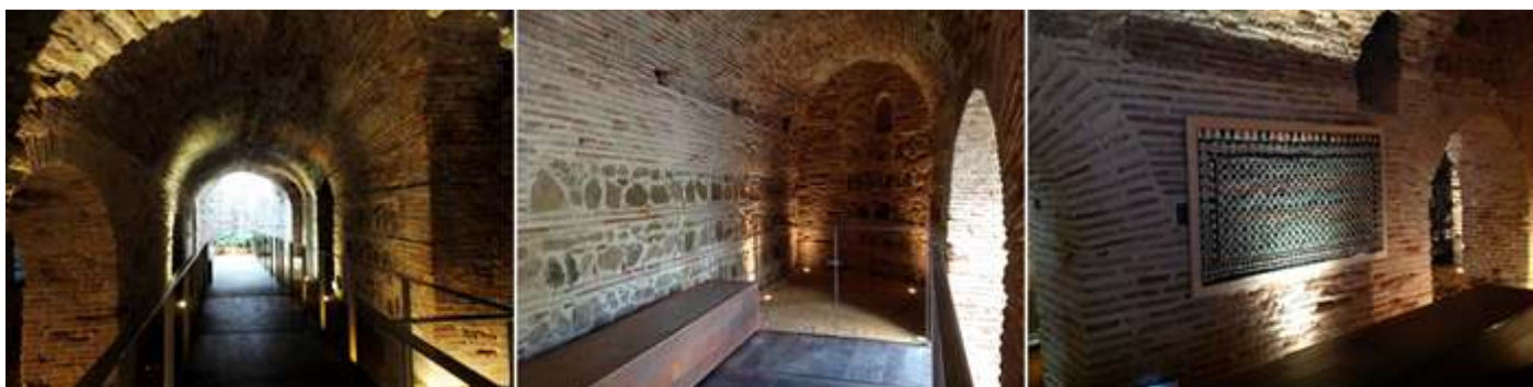
1 Pasadizos construidos con cantería y ladrillo. 2 Con bóvedas de medio punto en ladrillo. 3 Sobre este muro un interesante mosaico que parte interior está con estrellas de seis puntas.
