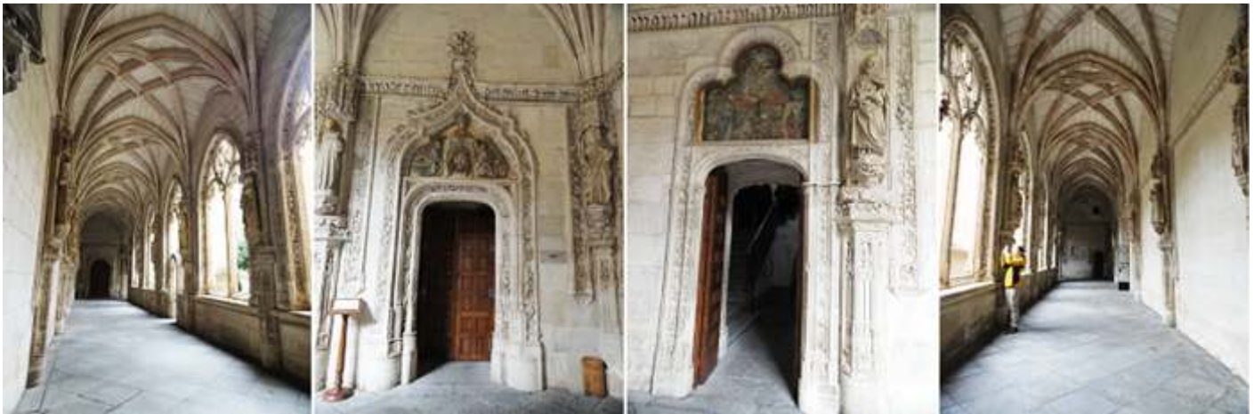
❶ El claustro bajo permanece abierto con ventanales apuntados con dobles ventanas. ❷ Puerta que une el claustro con la iglesia y que en su tímpano tiene un bajo relieve de la Verónica que muestra en su lienzo el rostro de Cristo. ❸ Puerta de la escalera con una pintura al fresco de la Crucifixión del Señor con santos franciscanos. ❹ Bóvedas de crucería sobre arcos apuntados.
