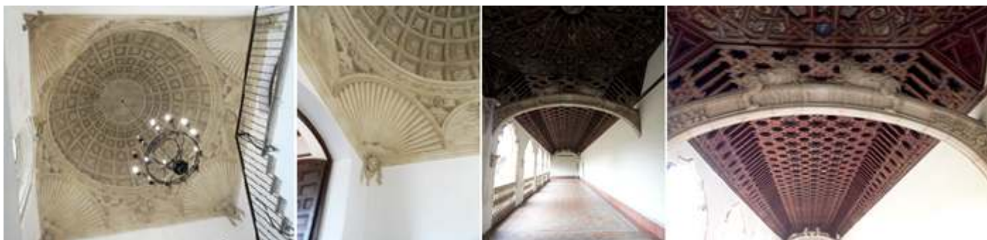
❶ La cúpula de la escalera decorada con casetones. ❷ Trompa en un ángulo de la cúpula. ❸ El artesonado de esta planta de claustro, es una recreación de Arturo Mélida restaurado a finales del S. XIX. ❹ Detalle de uno de los arcos rebajados existentes.
