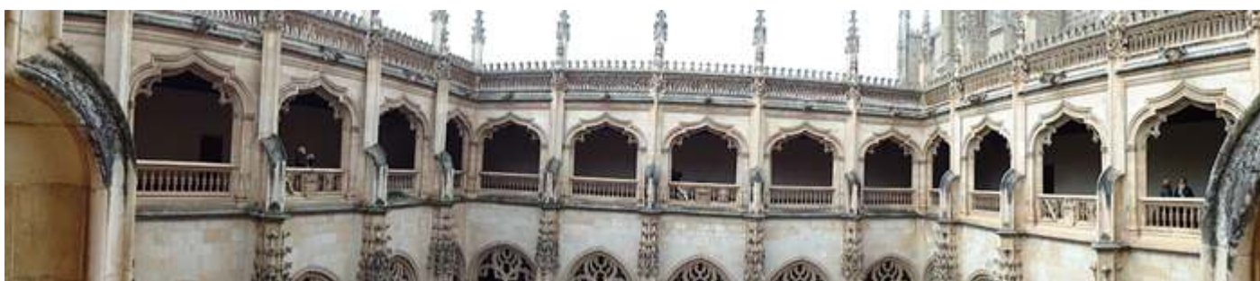
❶ Panorámica de la segunda planta del claustro.
