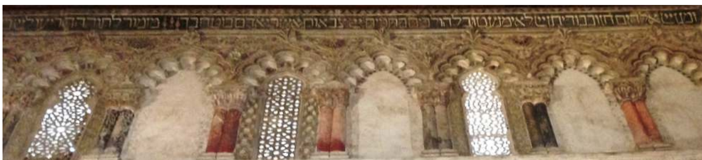
1 Detalle de las ventanas del lateral.
