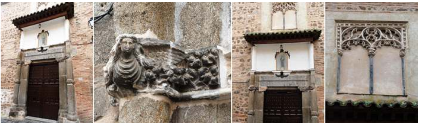
1 Puerta con dos columnas adosadas a sus lados. 2 Capitel del lado izquierdo de esta puerta. 3 Sobre su puerta un ventanillo gótico. 4 Doble ventana actualmente cegada pero que conserva perfecta su decoración.
