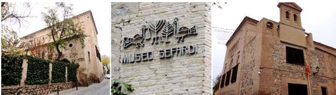
❶ Parte posterior donde se encuentra el jardín que posee. ❷ Rótulo del museo Sefardí. ❸ Lateral de su fachada principal y sobre su puerta dispone de una pequeña espadaña de dos vanos.
