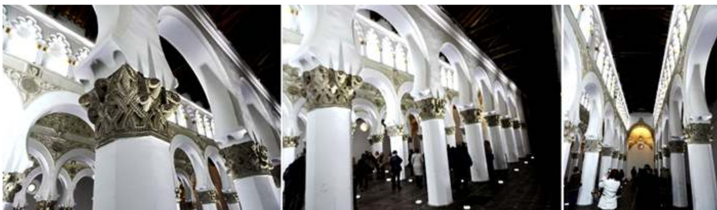
❶ Cuatro líneas de arcadas con columnas octogonales lisas separan su nave, ❷ Sobre ellas los arcos de herradura encalados como las columnas. ❸ Las tres naves centrales más altas con una línea de ventanas con arcos polilobulados le aportan la luminosidad al templo.
