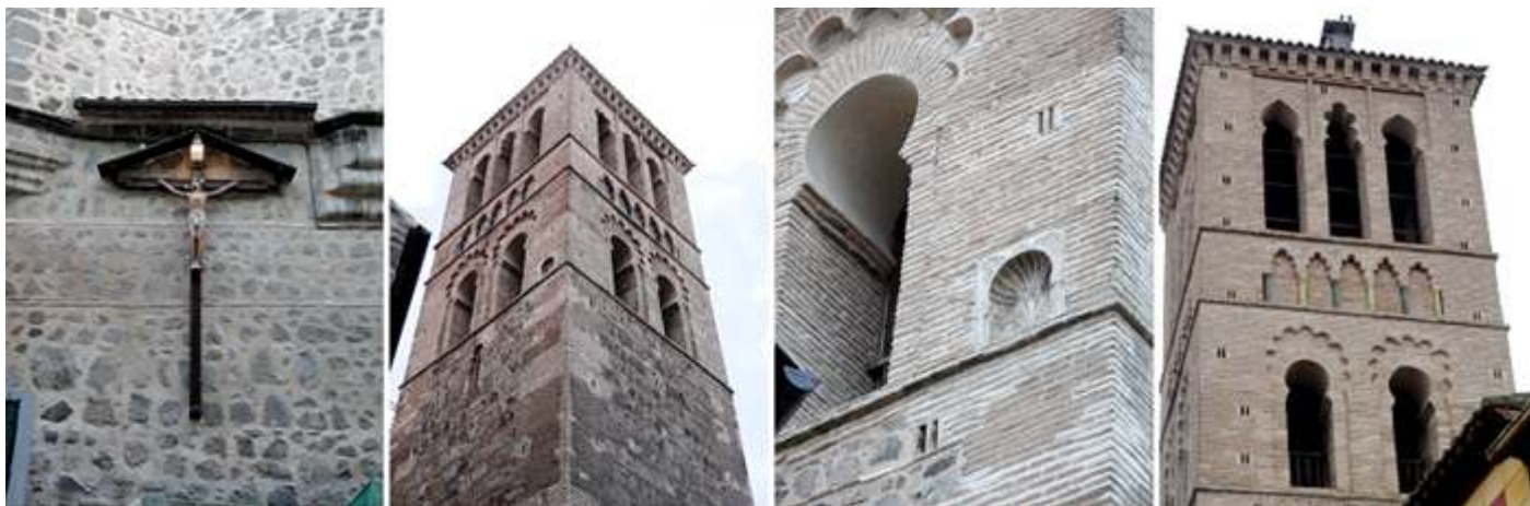
❶ Santo Cristo en la cabecera de la iglesia, en el exterior de la calle Santo Tomé. ❷ La torre es el elemento que perdura de la primitiva iglesia y de cuya iglesia estaba exenta. ❸ La parte inferior es de mampostería y los dos últimos cuerpos de ladrillos, abiertos con arcos de herradura donde están las campanas. Placa nicho visigodo. ❹ Sigue los esquemas de los alminares islámicos.
