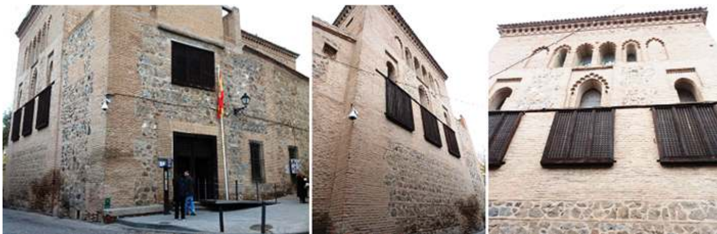
❶ Esta sinagoga se construyó entre los años 1355 y 1357. ❷ Para reflejar el apoyo de la comunidad judía a este rey en las luchas dinásticas que mantuvo con los Trastámara. ❸ Parte del hastial con ventanas con celosías de madera unos arcos de medio punto y el central dentro de uno lobulado y con una tercera fila de ventanas ciegas y abiertas.
