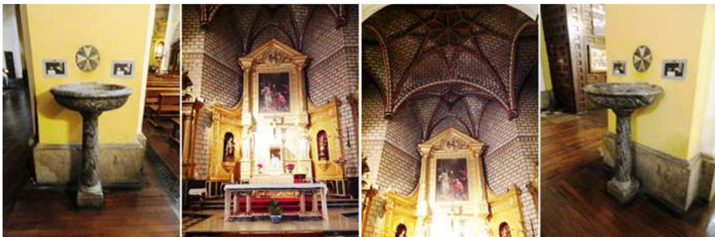
1 Pila de mármol jaspeado gris de taza plana con un fuste cilíndrico y basa cuadrada a la entrada en el lado izquierdo. 2 Cabecera poligonal fruto de la ampliación a comienzos del S. XVI. 3 La cabecera cubierta con una bóveda de crucería del gótico final. 4 La otra pila similar en el lado de la Epístola.
