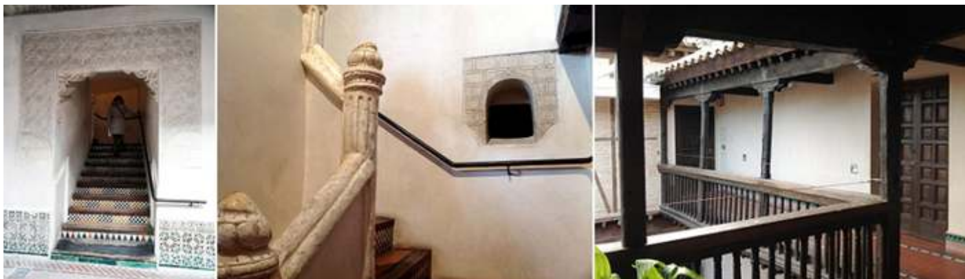
❶ Puerta de la escalera con decoración de yeserías. ❷ Interior de las escaleras ❸ Las galerías del patio
