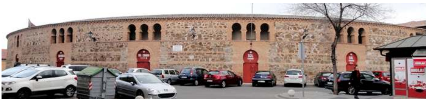
❶ Esta plaza que ya ha cumplido sus 150 años se construyo en 1866 mediante una suscripción de 884 acciones de 500 reales siendo alcalde de la ciudad Gaspar Díaz de Labandero. Su construcción de piedra de cantería y las hiladas de ladrillo con los tramos de puertas y ventanas de herradura realizadas en ladrillo.
