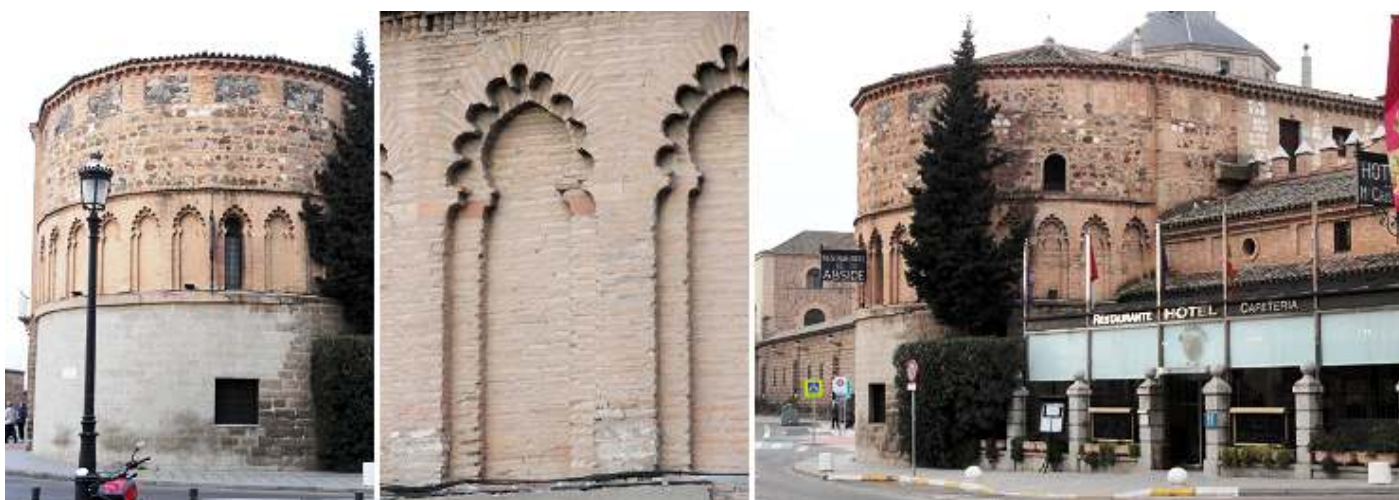
❶ El ábside que mantiene sus arcos ciegos abiertos por una sola ventana. ❷ Detalle del arco exterior polilobulado e interior de herradura. ❸ Lateral del Evangelio con las instalaciones del hotel.
