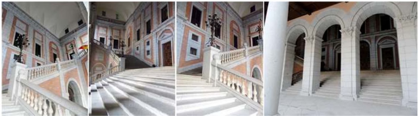
❶ Francisco Villapando diseño esta escalera, importando las técnicas y gusto florentino ❷ Reconstruida con los peldaños de granito originales. ❸ Salida al Patio de Armas de la escalera por estos tres arcos.
