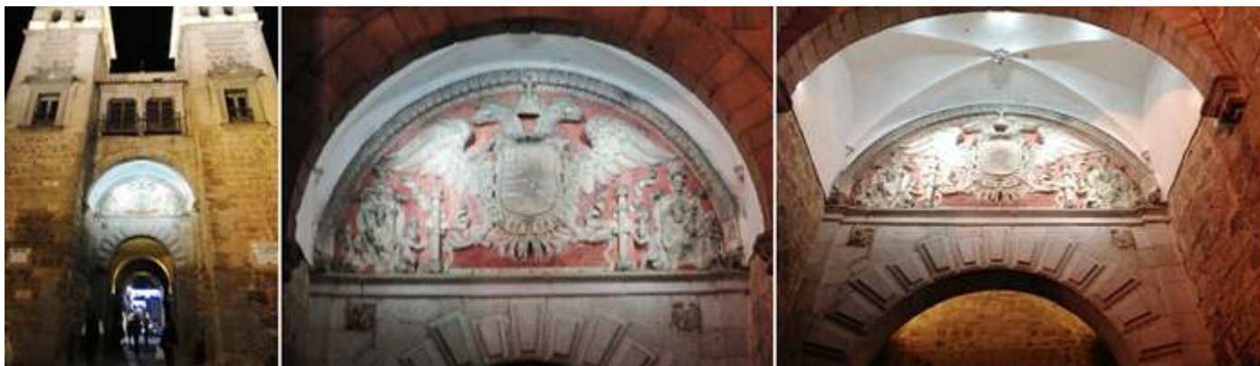
❶ Fachada al patio de armas con dos torres cuadradas y un arco almohadado de medio punto. ❷ Sobre el mismo un tímpano con el escudo Carlos I y los escudos de la ciudad. ❸ Bóveda de este arco.
