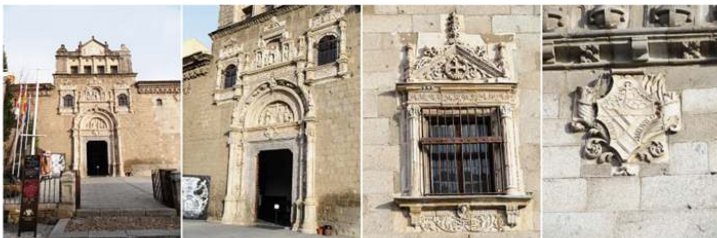
1 Un gran patio ante su fachada al mediodía. 2 Su puerta adintelada bajo un arco de pedo punto con un tímpano con la Invencción de la Cruz sendas columnas sobre pilastras e a su lados llenas de relieves con grotescos, ángeles y otros ornamentos. 3 Una ventana lateral con columnas estriadas y un frontis con el emblema de la Cruz. 4 Escudo del cardenal Mendoza.
