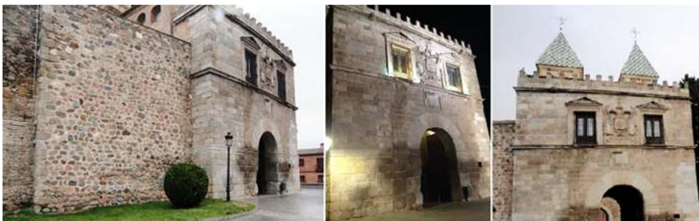
❶ Parte que da al interior de la ciudad con las murallas a sus lados y sendas puertas que se abrieron en la década de los años 30 del siglo pasado para los vehículos. ❷ La puerta de medio punto con dovelas lisas y sobre la misma una imposta corrida con dos ventanas que en el centro nuevamente está el escudo de Carlos V. ❸ Está construida de piedra sillar y coronada con almenas. Sobre la misma se divisan los tejados piramidales de las torres en tejas policromadas.
