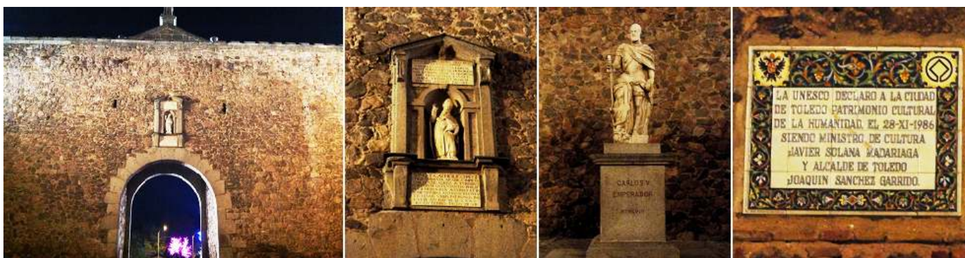
❶ Parte posterior de la puerta de la Bisagra y de los dos cubos laterales. ❷ Hornacina sobre la puerta interior de la fachada principal con el primer obispo de la ciudad San Eugenio, con unos versos del rey Godo (Wamba). ❸ Estatua de Carlos I de España y V de Alemania en el patio colocada en 1958. ❹ Reconocimiento de la Unesco como Patrimonio de la Humanidad en 1986.
