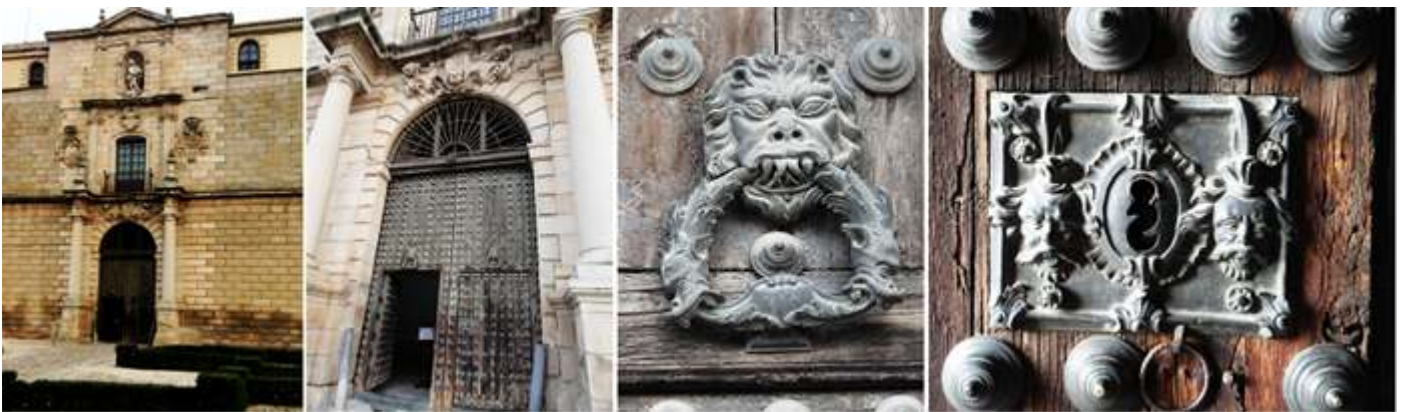
❶ Los dos primeros cuerpos del orden dórico y ostentando columnas y pilastras, y el tercero es jónico con una hornacina con San Juan Bautista. ❷ Portada de medio punto almohadillada y con dos columnas exentas sobre pilastras. ❸ Llamador o aldaba con la fecha de 1763. ❹ Detalle de la artística cerradura, con los tachones claveteados de la puerta.
