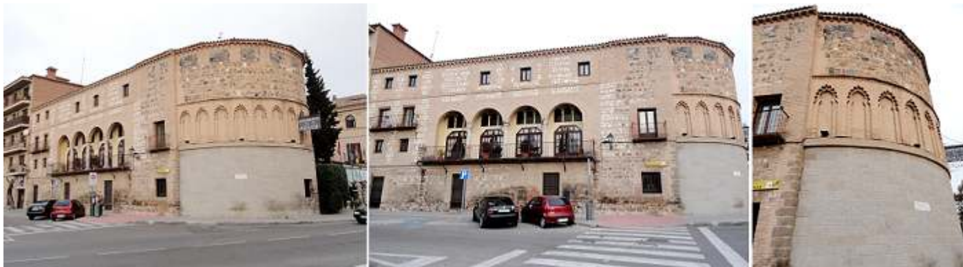
❶ Fachada a la calle Costanilla de San Lázaro. ❷ Todo este lateral se ha transformado. ❸ El ábside que su parte inferior esta revestida, quedando una franja de arcos polilobulados ciegos y la superior de cantería.
