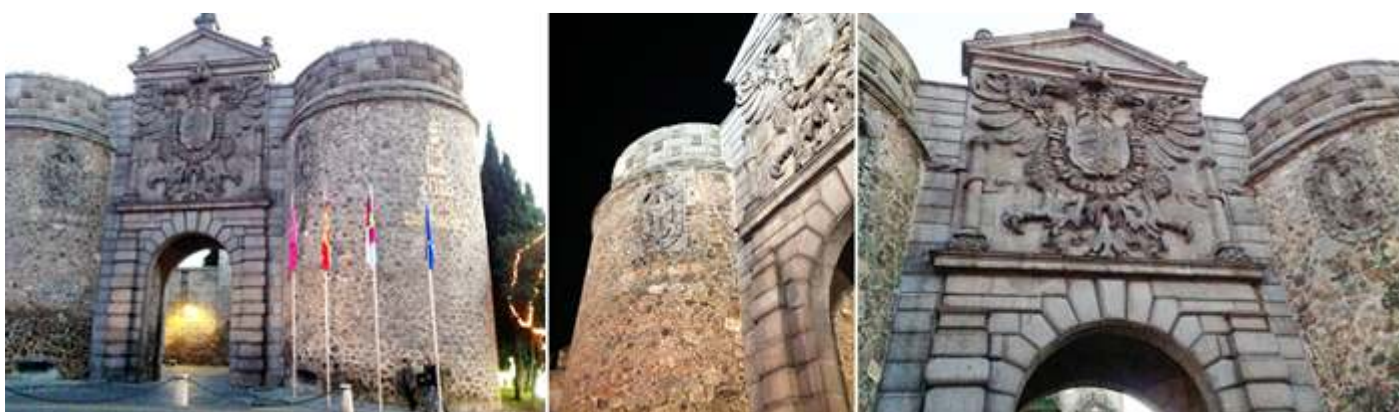
❸ Frontal de la puerta con su patio en el interior. ❹ Los cubos semicirculares están contruidos con cantería irregular. ❺ Su parte central construida con sillares almohadillados y sobre la puerta el escudo de la ciudad imperial con el águila bicéfala (que Carlos V otorgó a Toledo) culminado con un frontón triangular.
