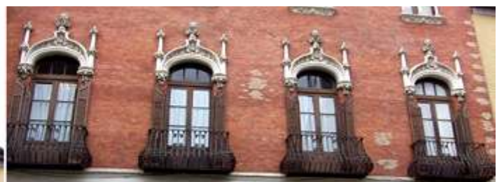
2 Fue construido en 1911 con un fachada gótico veneciano.
