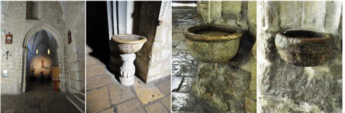
1 Capilla en el primer tramo del templo 2 Pila agua bendita a la entrada del templo. 3 - 4 Pilas de agua bendita a la entrada de la puerta gótica en el lado de la Epístola.
