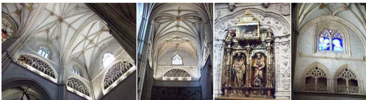
❶ Detalle de las bóvedas y la galería en los dos primeros tramos de la catedral. ❷ Parte central del primer tramo del templo. ❸ Lateral del trascoro en el lado de la Epístola con un retablo de piedra de 1534 del palentino Juan Ortiz el Viejo discípulo de Felipe de Vigarny. (está es la parte central) con las imágenes de San Pedro y San Pablo. ❹ Ventanas con vidrieras a los pies del templo. De las vidrieras góticas de la catedral son pocas las que han llegado a nuestros días.
