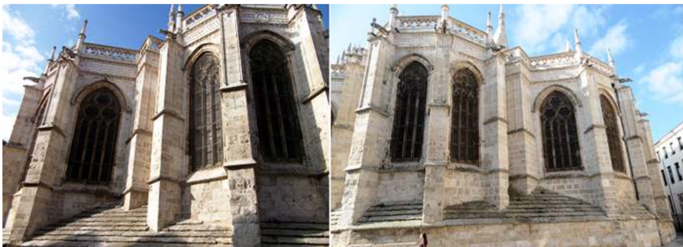
❶ Su ábside con grandes ventanales entre sus contra fuertes. ❷ Ventanales apuntados calados con tracería y dotados de vidrieras.
