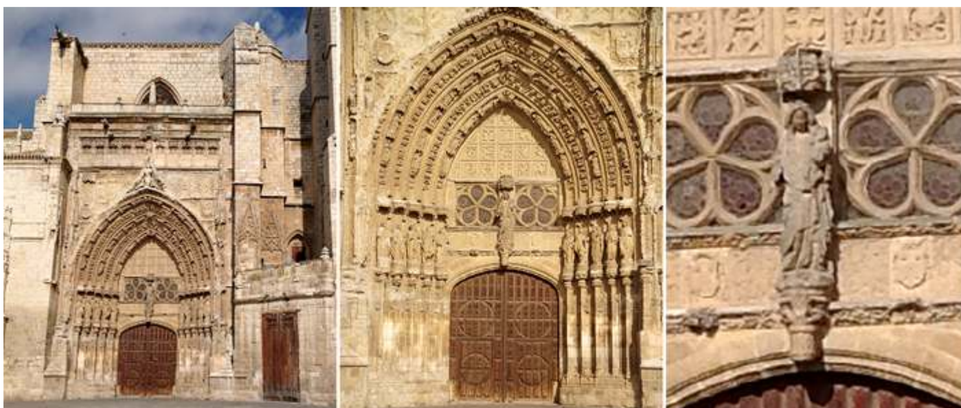
1 Puerta de Santa María o del Obispo. 2 Su puerta con un arco de medio punto rebajado. 3 Sobre el dintel de la puerta la escultura de la Virgen María, de factura gótica.
