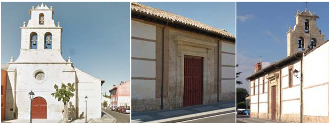
❶ Fachada a la plaza de Juan XXIII, entre sus contrafuertes una puerta de medio punto sobre la que dispone de un óculo, y un segundo cuerpo separado por una imposta corrida su espadaña de tres vanos. ❷ Puerta adintelada en la calle Hermanos Madrid. ❸ Perspectiva desde esta calle y colindante el convento de La Piedad.
