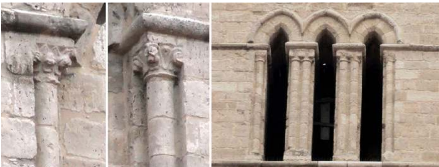
1 - 2 Columnas y capiteles de la ventana bífora. 3 Sobre al anterior esta ventana trifora de arcos apuntados y dobles columnillas.
