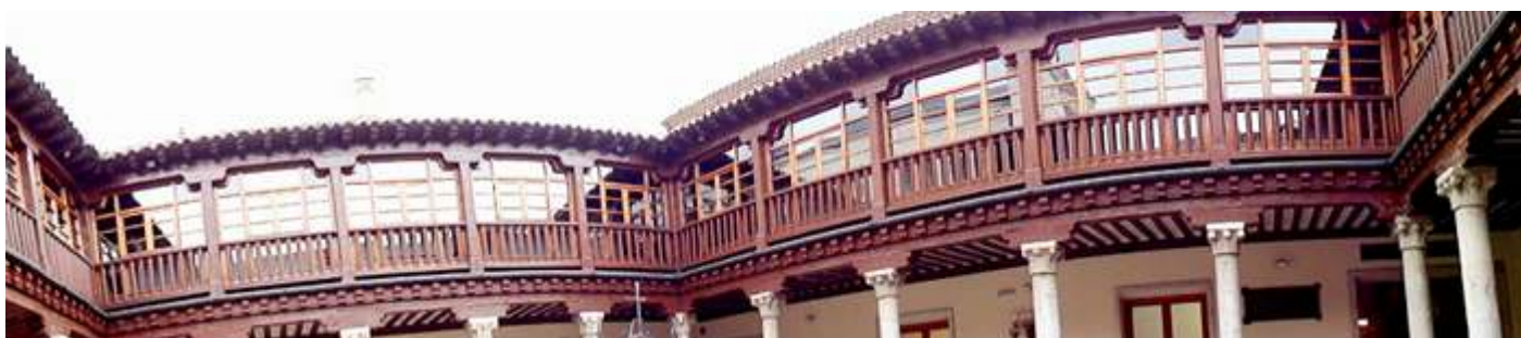
❶ Panorámica de la calería superior de madera con columnas con zapatas.
