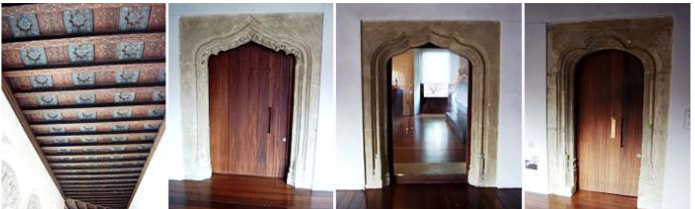
❶ Artesonado de las galerías del primer piso del claustro. ❷ - ❸ -. ❹ Diferentes puertas con arco carpanel en el claustro correspondientes celdas de los colegiales.
