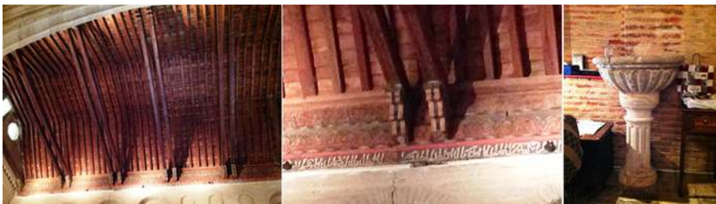
1 Detalle del artesanado con un cubierta a dos aguas. 2 Donde se aprecian los canes y travesaños decorados. 3 Pila agua bendita de piedra con una taza semicircular con gallones excavados bajo su borde con un fuste torneado y una parte estriada, sobre una basa redonda, situada a la izquierda de la puerta de entrada.
