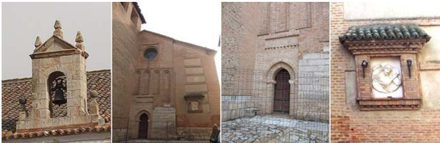
1 Espadaña en la fachada al medio día. 2 Hastial con su puerta de medio punto apuntada y adosada su torre ante los pies del templo y la nave del Evangelio. 3 Portada del hastial. 4 Retablo con la imagen de Jesucristo con la cruz en relieve.
