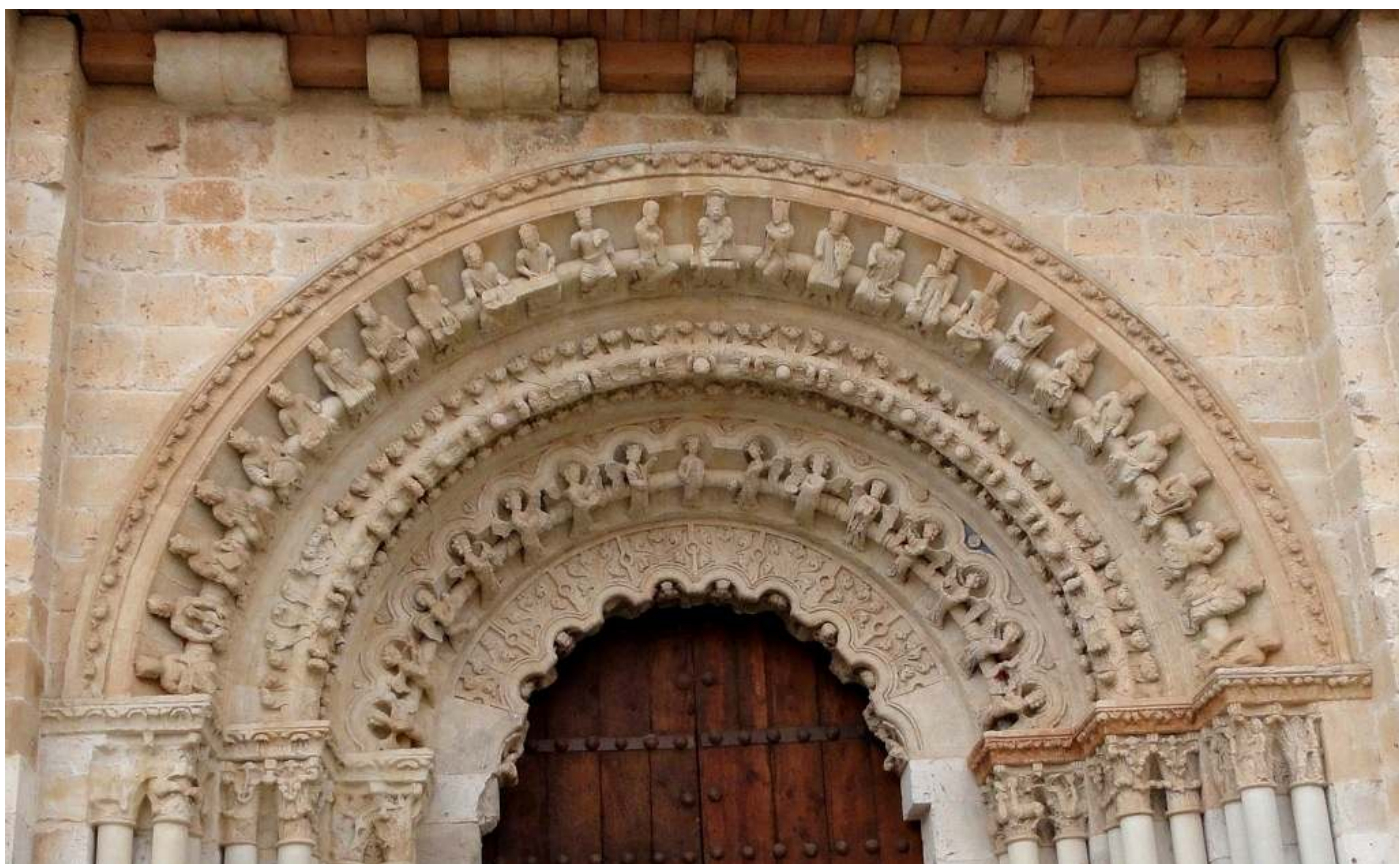
❶ Portada compuesta por cuatro arquivoltas, las tres exteriores sobre impostas y capiteles con agrupación de tres columnas, la interior polilobulada con motivos florales y en cada arco un personaje, en la siguiente tiene unas arcuaciones donde están situados los ángeles en cada espacio, la siguiente arquivolta está decorada con motivos vegetales que se parecen cogollos, y en la exterior una representación de 26 instrumentos medievales tocados por los ancianos del apocalipsis, y las tres figuras centrales son San Juan Bautista, Cristo en Majestad y la Virgen, y se completa con un guardapolvo.
