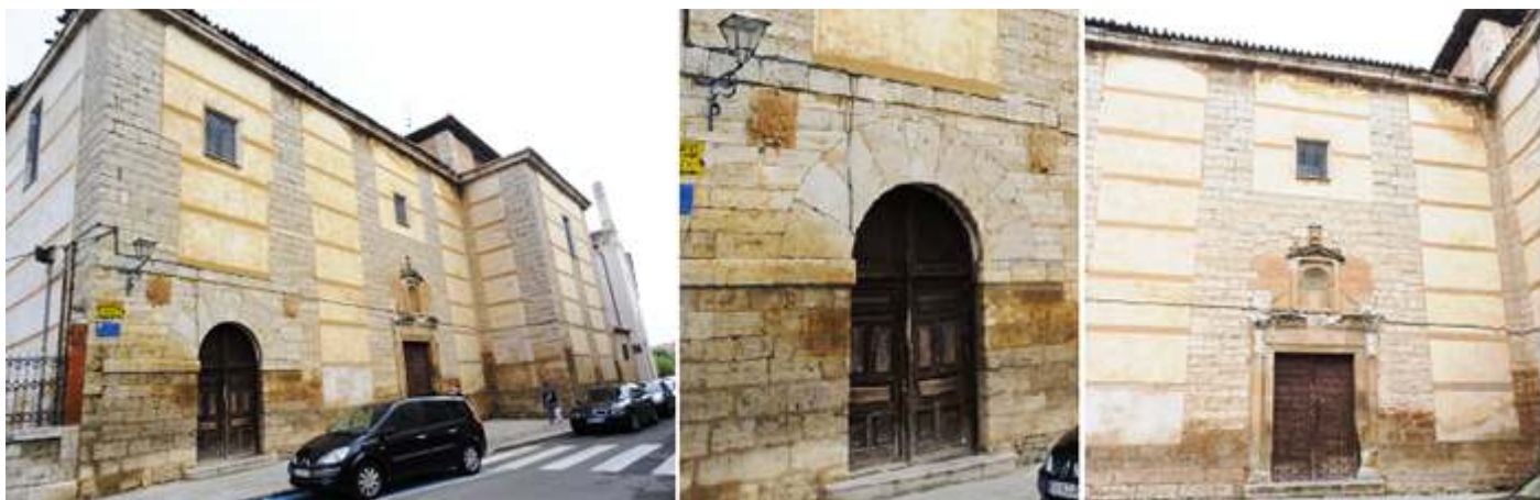
1 Edificio levantado en sillería y lienzos de argamasa dispone de dos puertas. 2 Una de ellas con grandes dovelas lisas y que ostenta un escudo a cada lado de la misma. 3 La siguiente puerta adintelada es para la capilla
