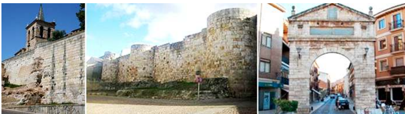
1 Muralla desde la cuesta, con la atalaya de San Cipriano. 2 Cubos de la muralla del alcázar. 3 Calle de la Corredera, 55-57.
