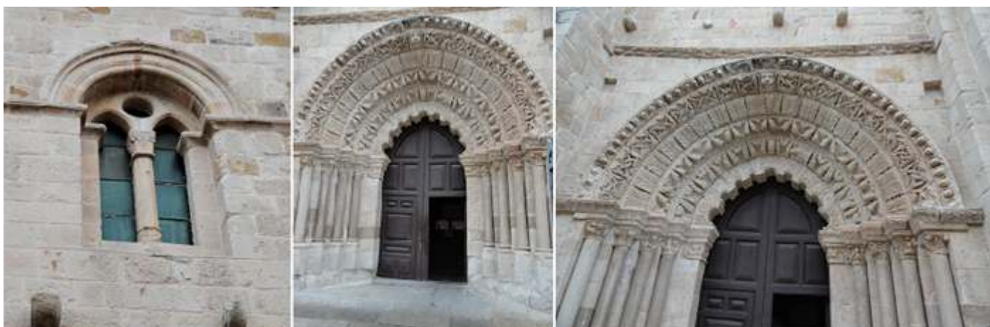
❶ Ventana de medio punto gótica con un ajimez en su interior de arcos apuntados y frontón calado. ❷ Portada meridional que dispone de un guarda lluvias con caritas, le sigue una arquivolta con entrelazos vegetales en sus dovelas y la central tiene un animal mitológico con sus fauces muerde los lazos, la siguiente son hojas del palma, continua con otra que los tallos de las hojas se entrelazan, la penúltima es otra labor con las hojas que se vuelven abarquillándose por los laterales con una cara y un personaje eclesiástico en las dovelas centrales y la última polilobulada con vegetales. ❸ Con una imposta decorada sobre la portada.
