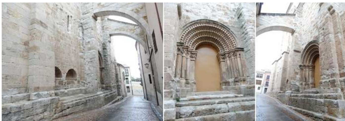
❶ Lateral epistolar con dos arcosolios y sendos arbotantes sobre los contrafuertes de la portada. ❷ Entre los contrafuertes en el tercer tramo con cuatro arquivoltas y un guarda lluvias. ❸ Vista del lado opuesto con una altura considerable la puerta con respecto a la calle.
