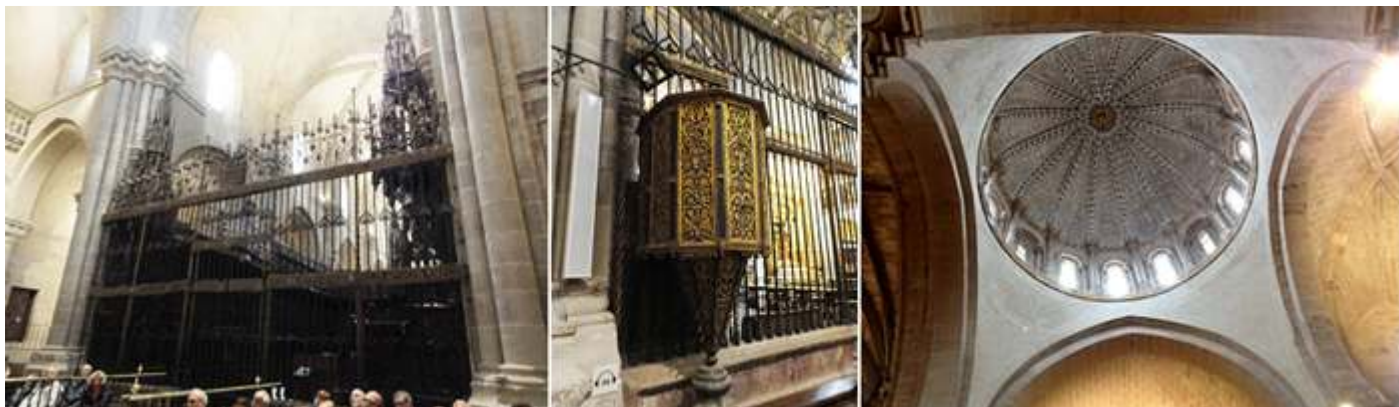
❶ El coro cerrado con una verja ha. 1500 de Francisco de Salamanca. ❷ Púlpito del lado izquierdo de la capilla Mayor que está cerrada con una verja de forja gótica del S. XV. ❸ Su cúpula sobre pechinas y arcos torales, con un tambor abierto por ventanas.
