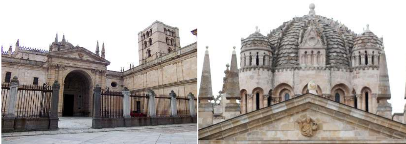
1 Un patio rectangular delimitado por una verja para acceder por la portada del transepto del Evangelio 2 Una de las señas de identidad de Zamora es este cimborrio de influencia bizantina con las escamas de piedra sobre sus cúpulas y con cuatro cubos, uno en cada ángulo.
