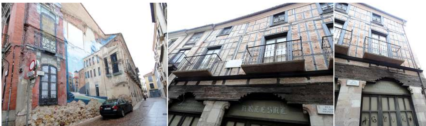
❶ Medianiles de dos casa en la Calle Moren, que dan un efecto óptico de la existencia de los edificios ❷ Casa con una estructura de los pisos superiores con ladrillo y tablonos de madera. ❸ En la misma calle de la Rúa de los Francos.
