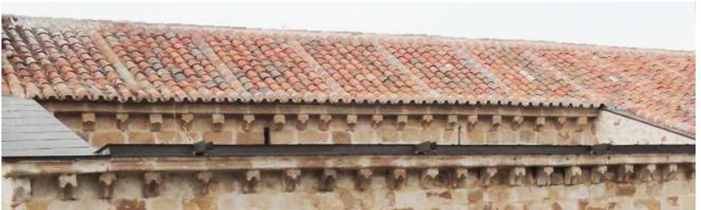
❶ De la época románica solo se conserva el muro meridional y el alero con los canecillos.
