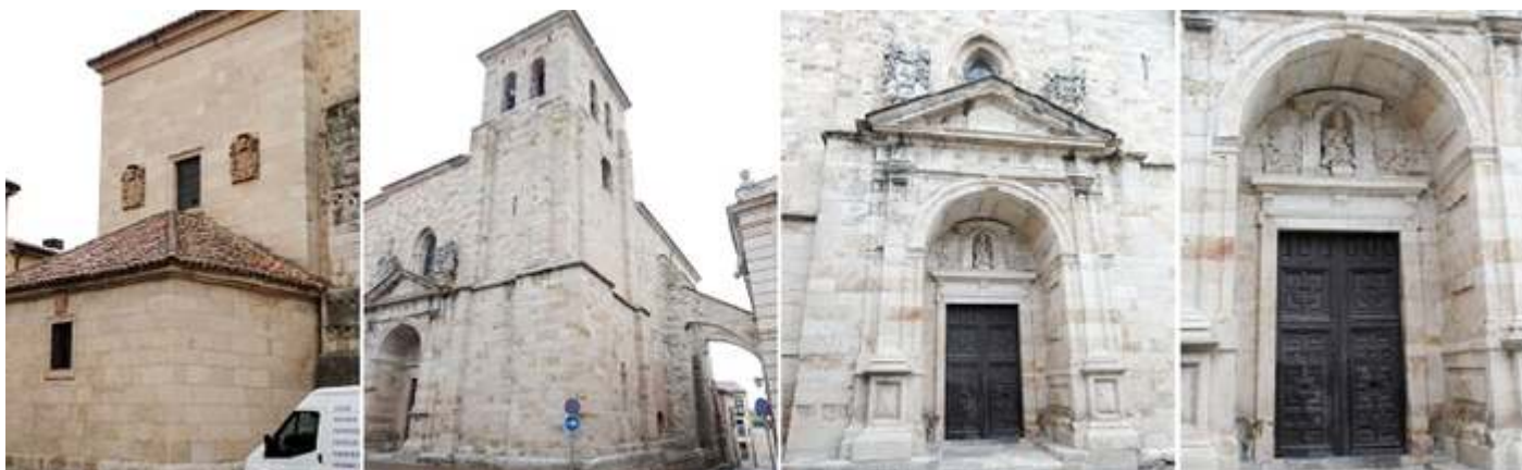
❶ Construcción en la parte posterior que tapa la parte de los ábsides. ❷ Su torre de planta cuadrada situada en la nave de la Epístola y conserva parte de su hechura románica. ❸ Su portada que está bajo una ventana románica que se conserva de arco apuntado. Con columnas rectas adosadas con un frontis triangular. Es del S. XVIII. ❹ Y bajo el arco se encuentra su puerta adintelada con una hornacina que tiene al imagen sedente de San Pedro.
