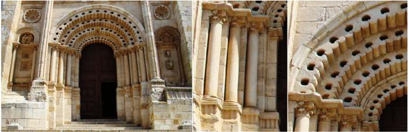
❶ Puerta del Obispo, con su portada sobre una terraza para salvar el desnivel del terreno con unas escaleras. ❷ Columnas acodilladas y capiteles del lado izquierdo. ❸ Detalle de sus arquivoltas lobuladas. Esta es la única portada de la antigua fábrica
