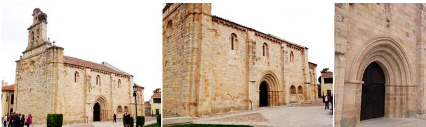
❶ El templo ante el amplio espacio abierto entre las murallas y el parque ❷ Lateral epistolar reforzado con contrafuertes rectangulares. ❸ Portada norte con cuatro arquivoltas.
