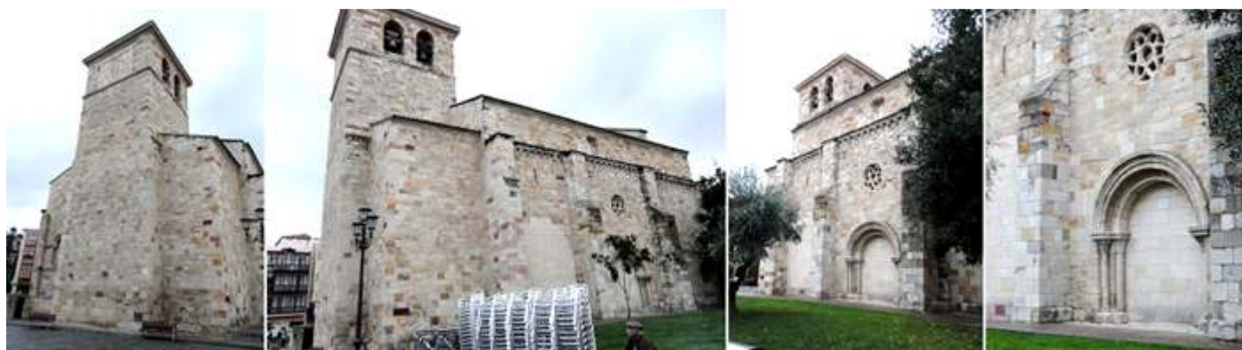
❶ Sobre la capilla Mayor se levanta su torre abierta con ventanas de medio punto. ❷ Lateral exterior del lado del Evangelio. ❸ Con una puerta (cegada) de medio punto con dos arquivoltas baquetonadas con guardapolvo y capiteles lisos almenados. ❹ Otro rosetón sobre la puerta de este lado con seis radios dobles.
