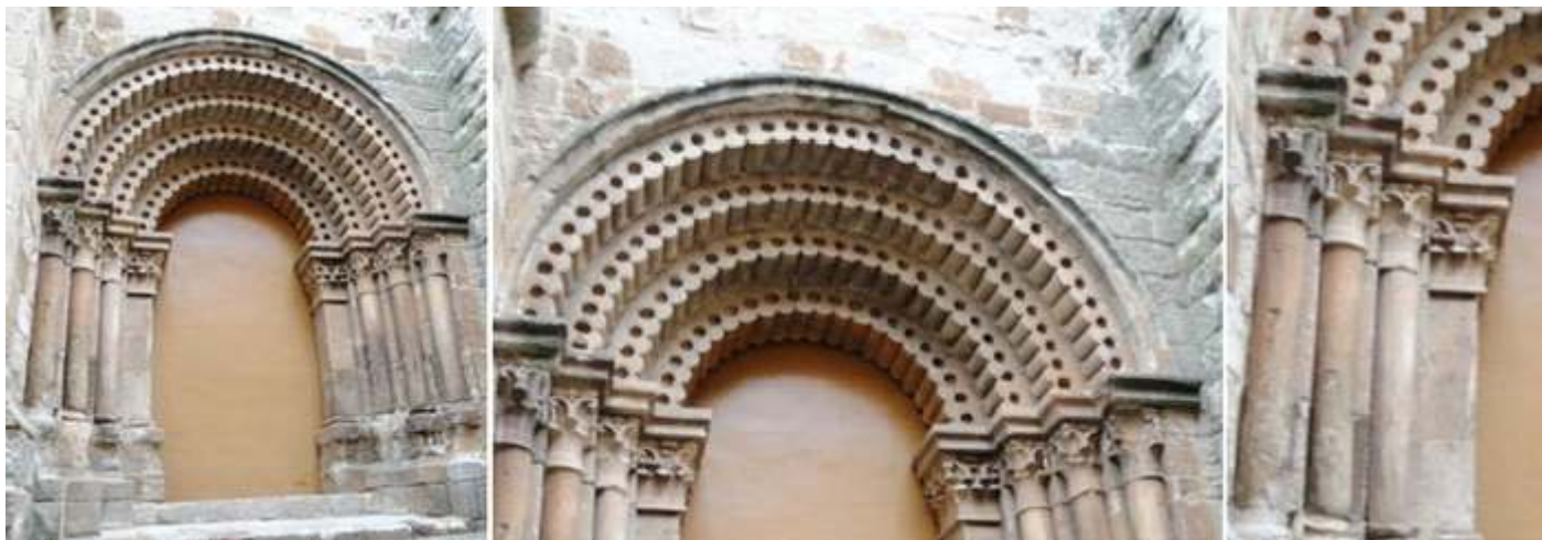
① Portada con sus arquivoltas lobuladas como la puerta del Obispo de la Catedral, que descansan sobre una imposta corrida. ② Sus arquivoltas con lóbulos que parecen rollos, le confieren un aspecto abocinado. ③ Bajo la imposta capiteles con columnillas acodilladas (3) la interior sobre la jamba de la puerta.
