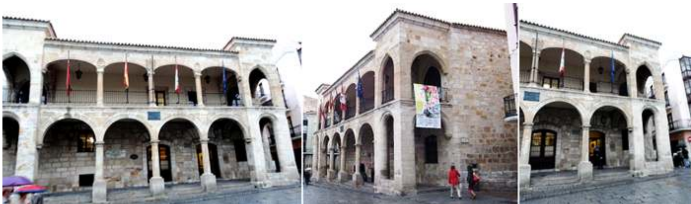
1 Su parte baja central con tres arcos con columnas sobre zócalos, y el superior con arcos campaneles. En las enjutas de los arcos están los escudos de España y Zamora. 2 Lateral izquierdo de esta fachada.
