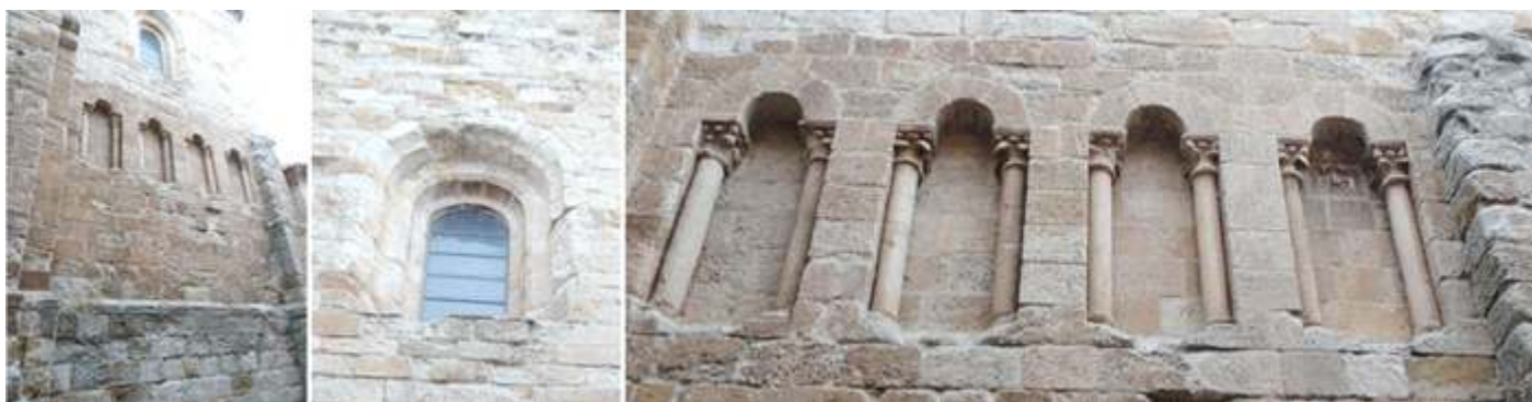
① Detalle del muro del cuarto tramo del templo. ② Ventana ya de la reforma de medio punto. ③ Y las cuatro ventanas ciegas.
