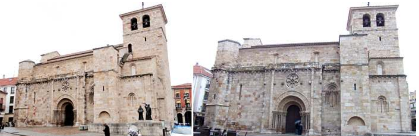
❶ Fachada sur del templo. ❷ Construida con piedra sillar con su portada adelantada, en este lado no dispone de contrafuertes.
