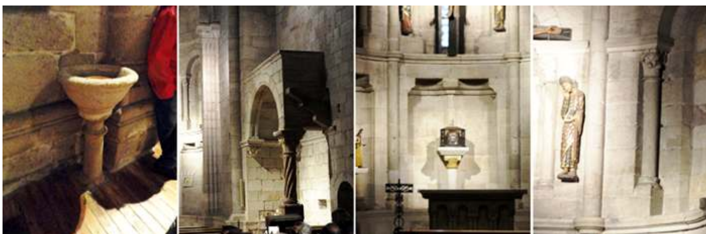
❶ Pila agua bendita de piedra troncocónica con doble bocel en su base y con fuste circular con un bocel y con basa cuadrada, colocara a la entrada de su puerta principal a la derecha. ❷ Baldaquino en el lateral epistolar, con columna helicoidal. ❸ Parte central del ábside con el Sagrario. ❹ Detalle San Juan y de las columnas del ábside.
