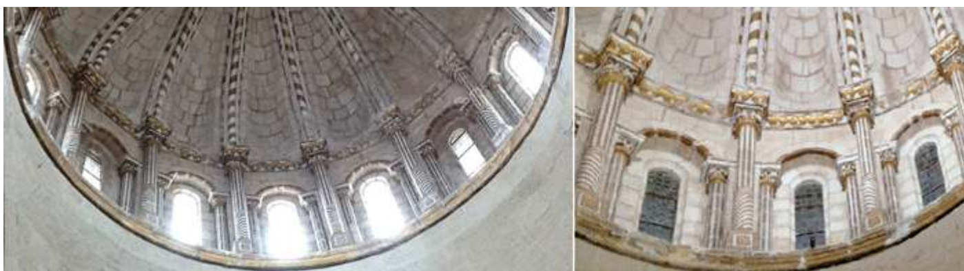
❶ El tambor con las ventanas propicio la iluminación y ventilación del templo. ❷ La columnas del tambor llevan capiteles vegetales. El dorado se aplicó en el S. XVII.
