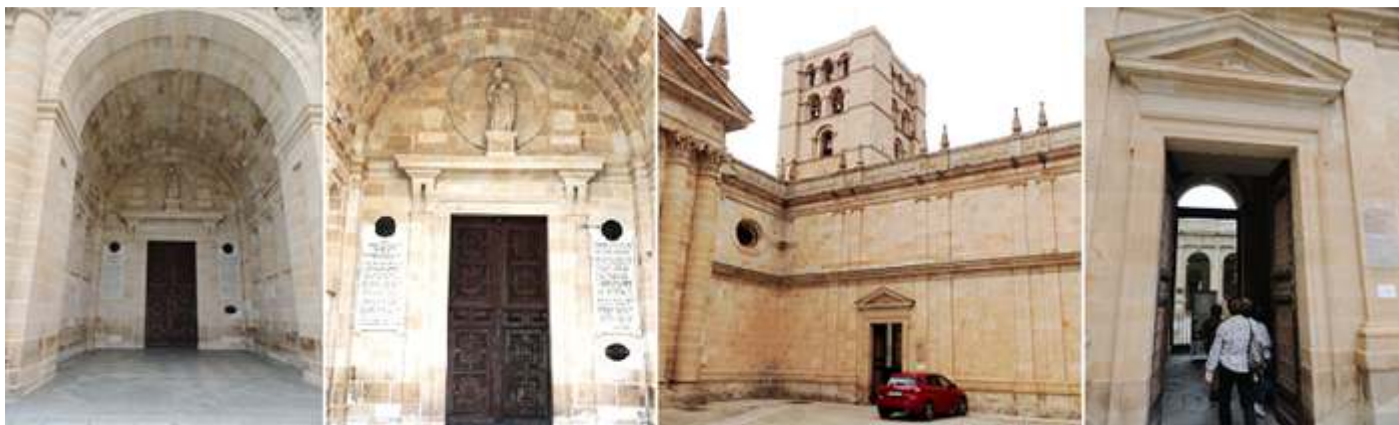
❶ Arco e interior de la portada norte. ❷ Con una puerta adintelada con columnas rectas adosadas y sobre el entablamento la imagen de San Salvador. A ambos lados esta la inscripción de discurso realizado por el Papa a los peregrinos zamoranos que acudieron a Roma en 1956. ❸ Entrada a la visita de la catedral. ❹ Por esta puerta adintelada con frontis triangular se accede al claustro.
