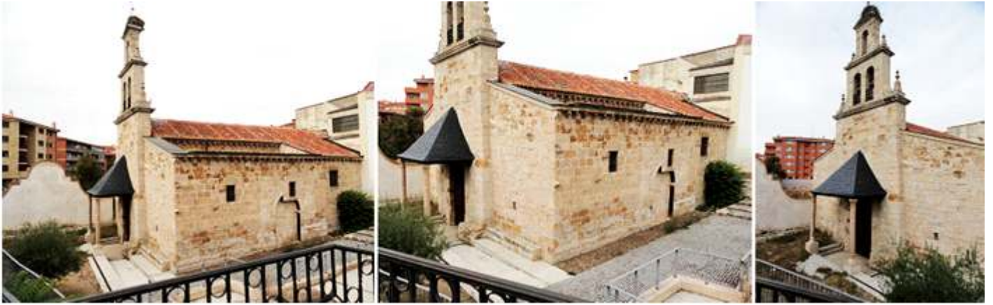
❶ Imagen de la Ermita construida con piedra sillar. ❷ En este lado epistolar conserva una puerta cegada. ❸ En su hastial tiene un poche moderno y culmina con una espadaña de tres vanos. El nombre original del Templo fue Nuestra Señora de Los Olleros.
