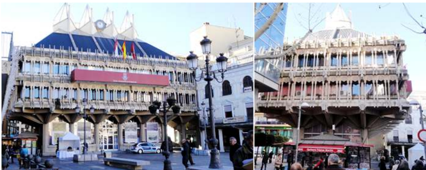
❶ La parte inferior del edificio está diáfana con lo que queda como suspendido por estas columnas. ❷ El lateral que queda libre en uno de sus lados.
