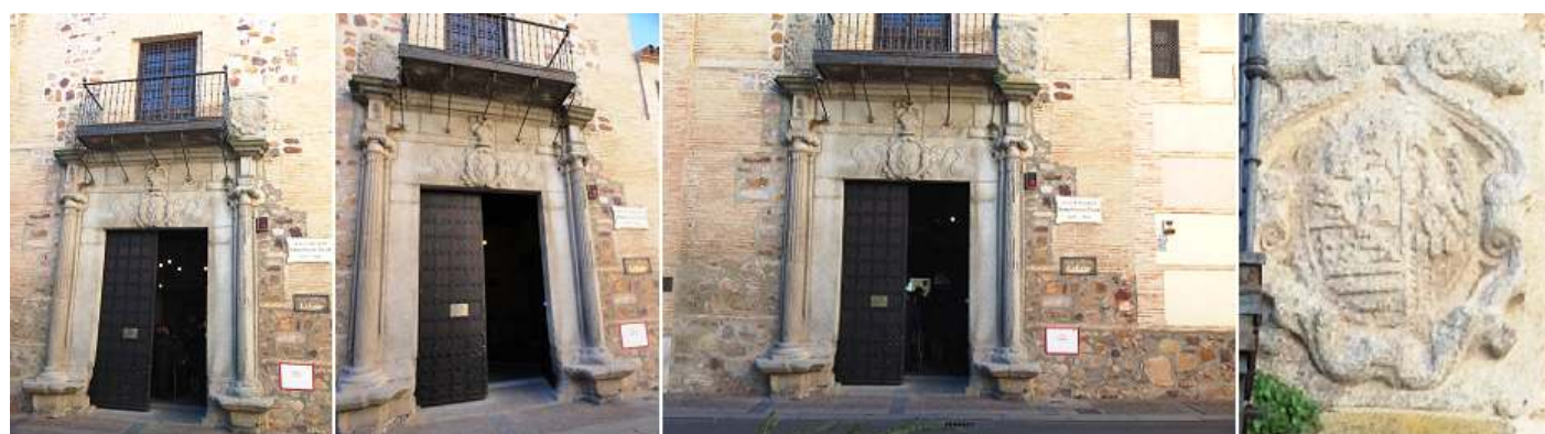
1 En la calle Reyes, 1 2 Se cree que en esta casa nació Hernán Pérez del Pulgar. 3 Es la casa más antigua de la ciudad. 4 Su puerta adintelada con sendas columnas redondas adosadas posee sobre la misma un balcón y dos escudos familiares a sus lados. Este museo dedicado a la obra de este pintor y también acoge exposiciones temporales está ubicado en una casa del S. XV (📞 926 25 52 00 consultar horarios)
