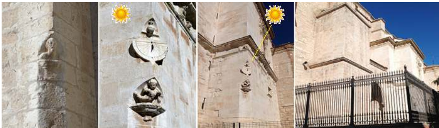
❶ Esquina de uno de sus muros con una figura humana. ❷ Reloj de sol emplazado en el ángulo de la fachada. Tipo: vertical, semicircular. Con los números y horas excavados. Orientación al mediodía. Traza: de las 7 a las 6 h. p.m. en números árabigos. Gnomon de cartabón (posee los puntos de un gnomon de varilla con apoyo. Estado: perfecto (salvo la parte fragmentada de la derecha). Año:1625 Cuando se inició la torre?. ❸ Ubicación de este reloj. ❹ Lateral exterior junto a la portada principal con una reja.
