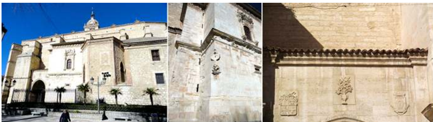
1 Fachada de la Epístola a la plaza. 2 Primer cuerpo comenzando por los pies. 3 Escudos sobre la portada epistolar.
