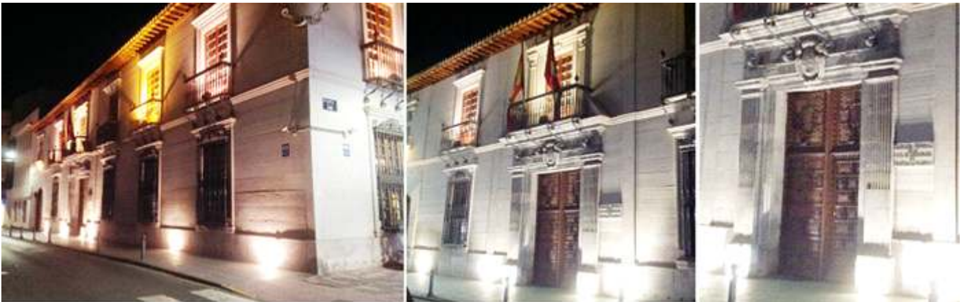
❶ En fachada principal está compuesta por una Puerta con pilastras que sostienen un escudo y un frontón ❷ Sobre la puerta principal ostenta un balcón. ❸ Puerta adintelada que ostenta un escudo.
