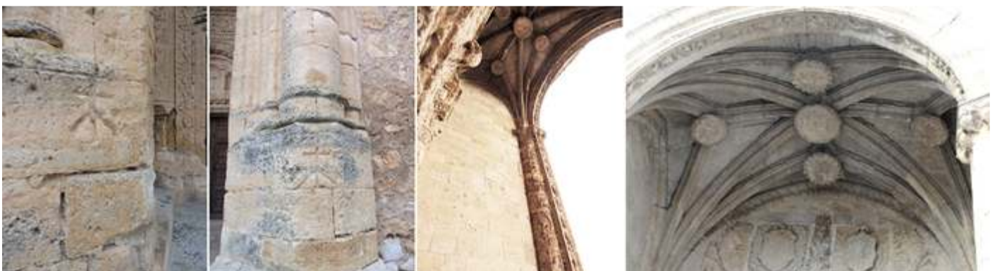
❶ Marcas con una cruz en la parte baja de su pórtico. ❷ Otra de las mismas características. ❸ Columnas y nervios de la bóveda del pórtico. ❹ Esta bóveda posee cinco gruesas claves escenificadas.
