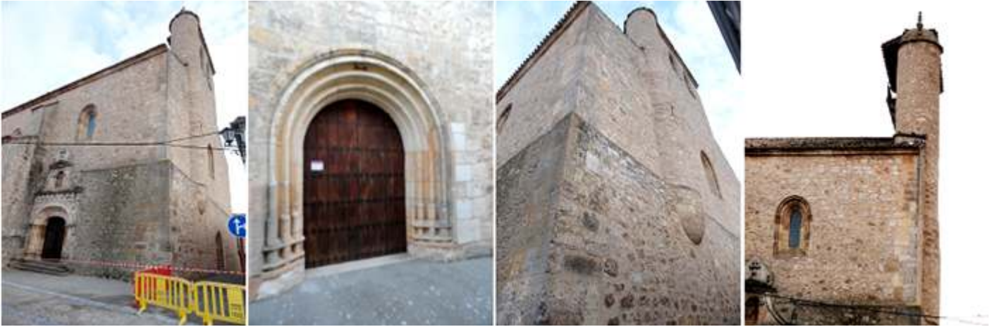
❶ Puerta en este lado exterior del Evangelio, ligeramente abocinada. ❷ Puerta a los pies del templo. Con cinco arquivoltas. ❸ Hastial con la escalera de su espadaña. ❹ Y la espadaña por este lado vista.
