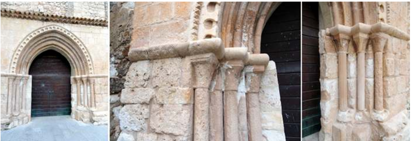
❶ Portada de este templo del S. XII siguiendo las directrices del románico pero con influencias del gótico. ❷ La arquivolta exterior posee una decoración de arquillos. ❸ Columnas y capiteles de la parte derecha de la portada.
