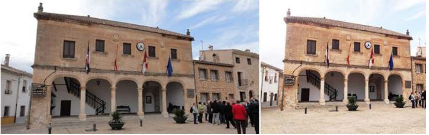
❶ La casa consistorial albergada en este palacio renacentista, construcción significativa de esta Plaza del Infante D. Juan Manuel. ❷ En su parte inferior posee una lonja renacentista con cinco arcos rebajados.
