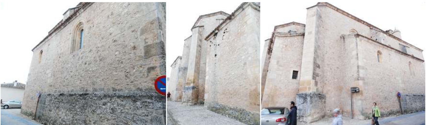
❶ Algunas ventanas de medio punto en este lateral. ❷ Imagen de la cabecera poligonal y sus gruesos contrafuertes. ❸ Otra vista desde el lado opuesto de este exterior.
