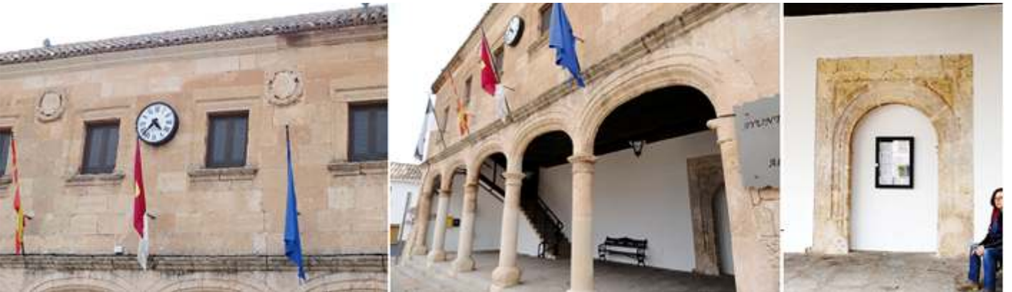
❶ Parte central de la primera planta con ventanas adinteladas enmarcadas y sendos escudos con un reloj. ❷ Detalle de las arcadas y al fondo la escalera de acceso al primer piso. ❸ Puerta de medio punto en la planta baja actualmente cegada.
