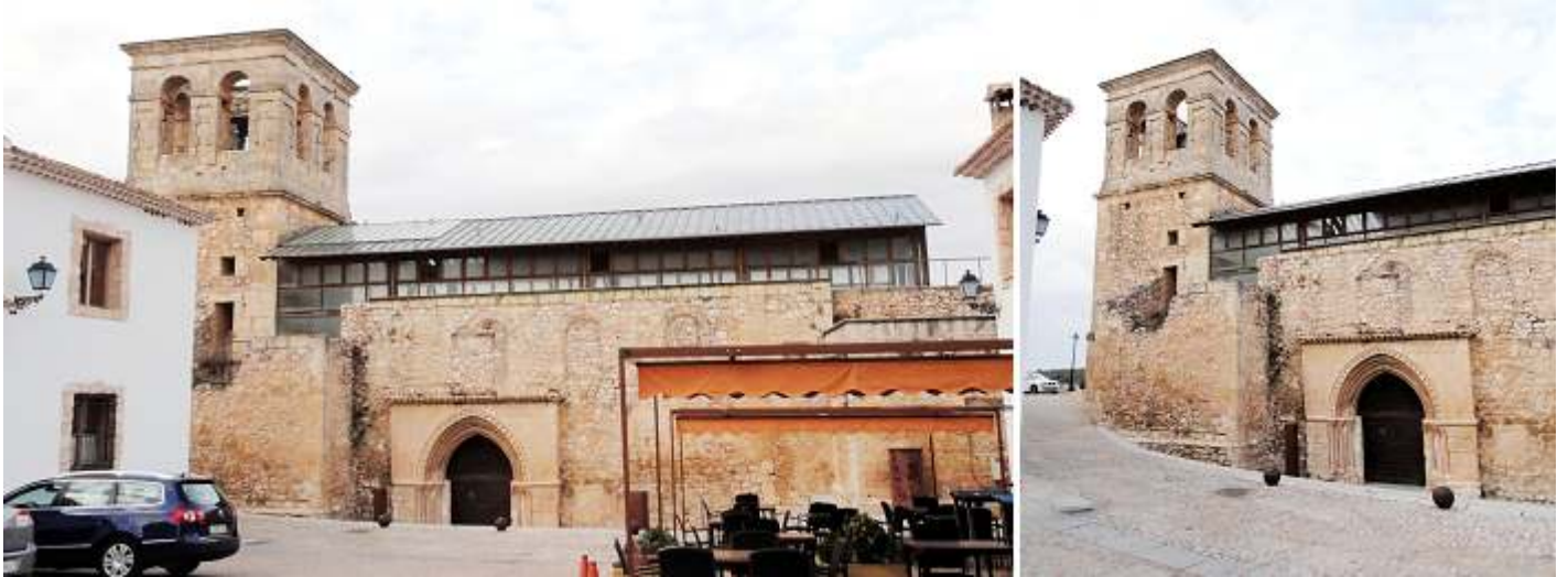
❶ Actualmente su torre sin cubierta y sobre la nave una nueva estructura de madera a dos aguas. ❷ Aspecto de su fachada ante la plaza y con unas gradas escalonadas hacia su portada.
