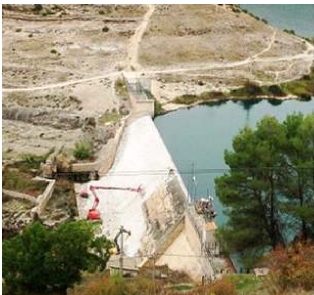
1 Presa del Henchidero en el río Júcar.
