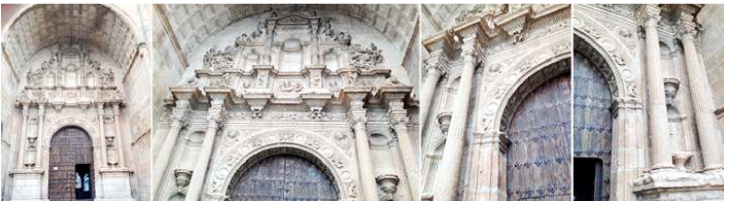
❶ Esta portada es obra de Esteban Jamete. ❷ Con arco de medio punto y doble columnas corintias sobre pódium, entre ellas están alojadas dos hornacinas, sobre el entablamento de la misma, una balaustrada y un segundo cuerpo que dispone de tres hornacinas. Todo el arco del pórtico está decorado con casetones. ❸ El arco de la puerta está decorado. ❹ Detalle de las columnas pareadas y con las hornacinas intercaladas entre las mismas.
